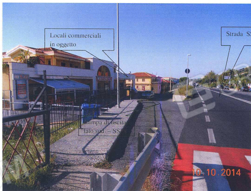
Fotografia n. 24 – Prospetto Est, rampa di uscita lato sud – SS18
