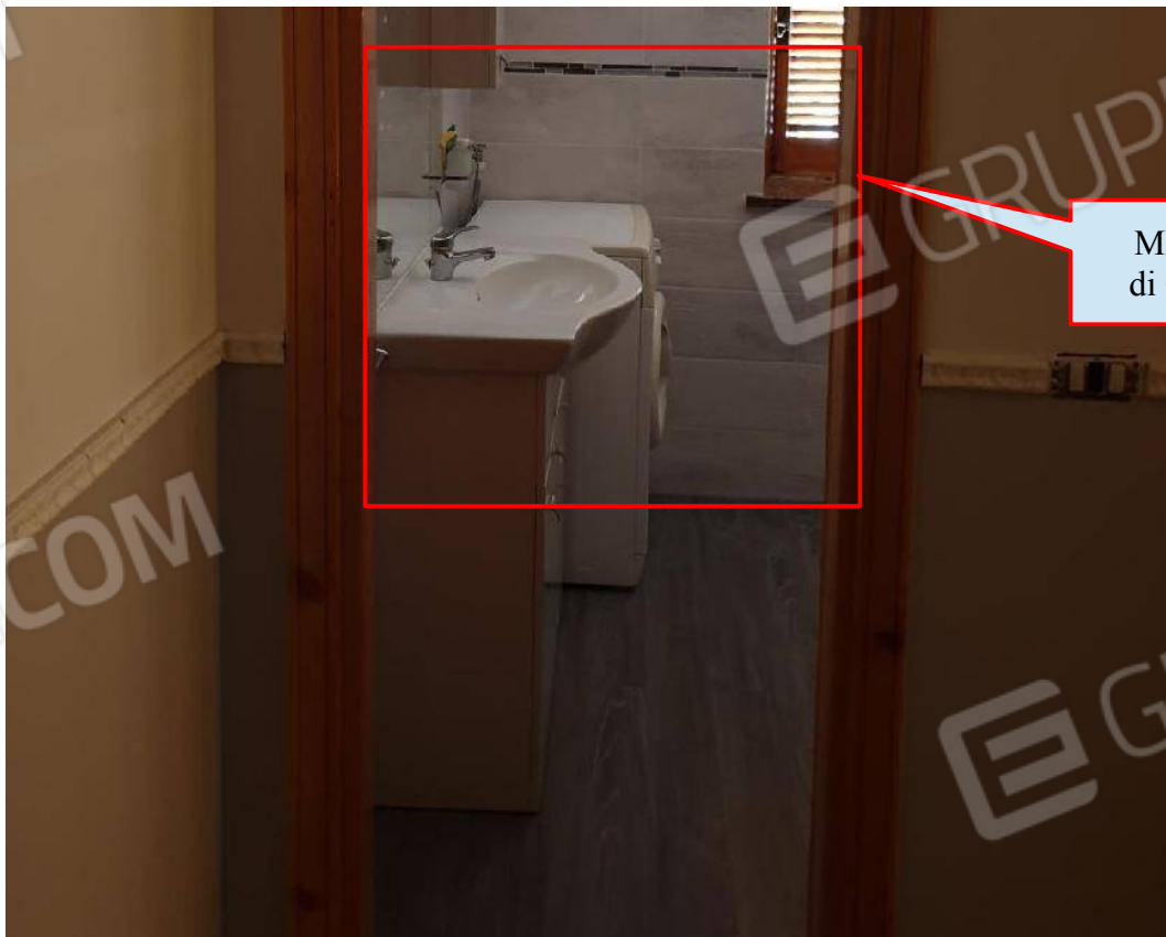
Foto n. 12 Pavimentazione in Mattoni di Ceramica (WC)
