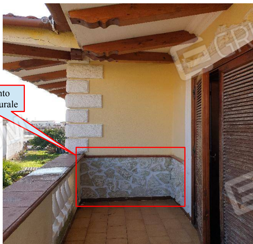
Foto n. 18 Terrazzo T2 (Lato Sud)
