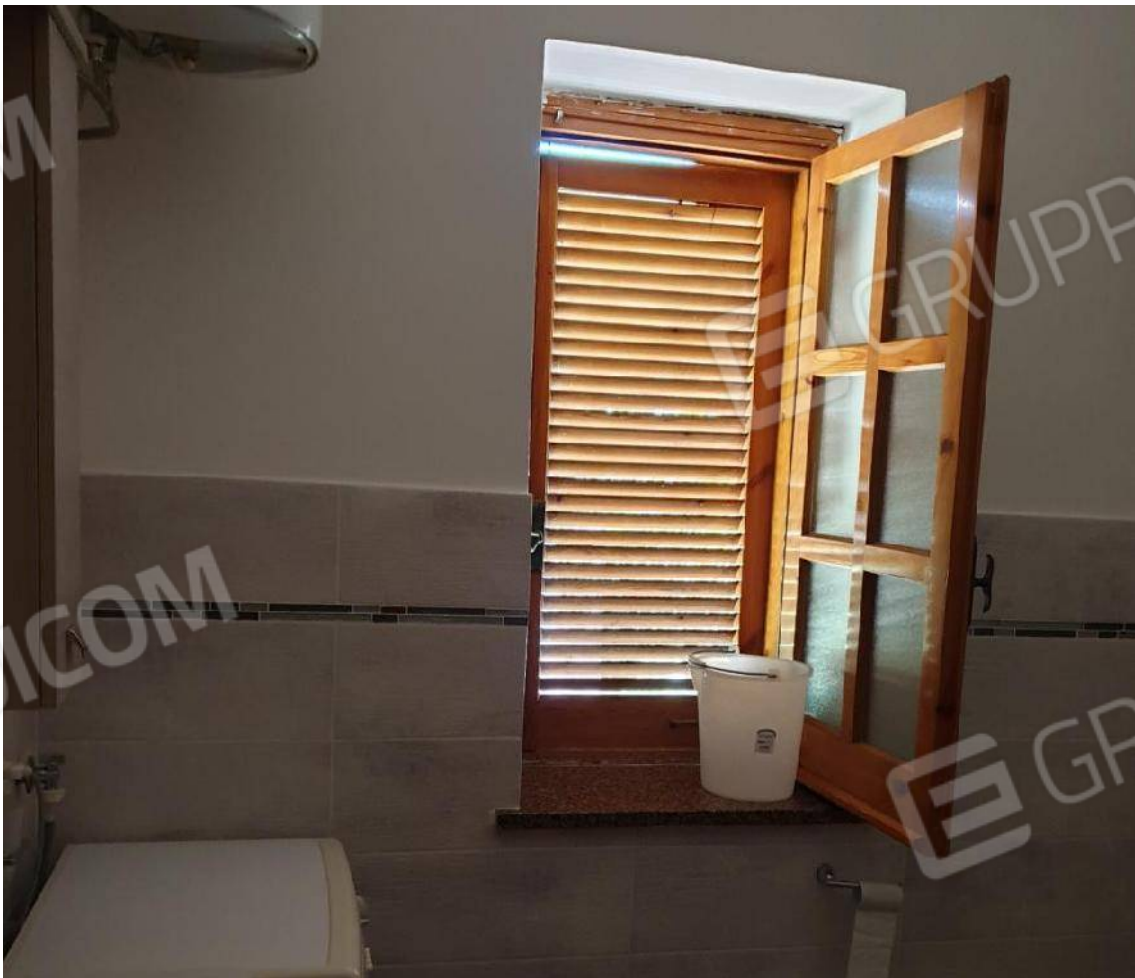
Foto n. 6 Finestra con Persiane in Legno Massello (WC)
