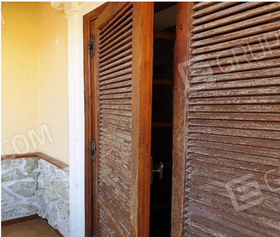
Foto n. 20 Particolare "Persiane" Balcone Terrazzo T2
