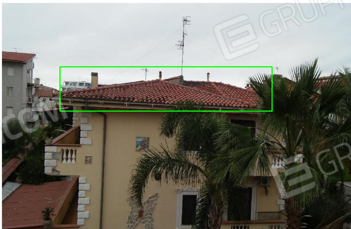
Foto n. 6 Tetto di Copertura con tegole di argilla
