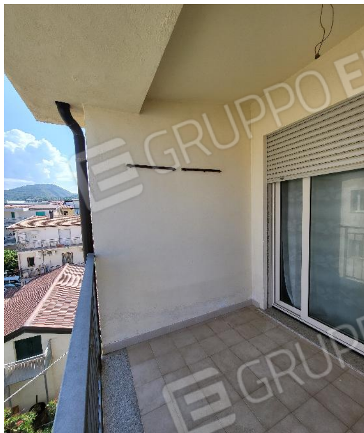
Foto n. 11 Loggia LG2 (lato Est)
