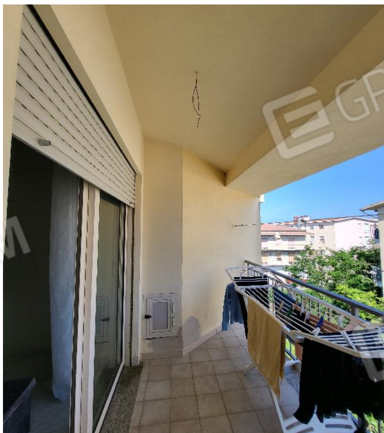
Foto n. 6 Loggia LG1 (lato Ovest)
