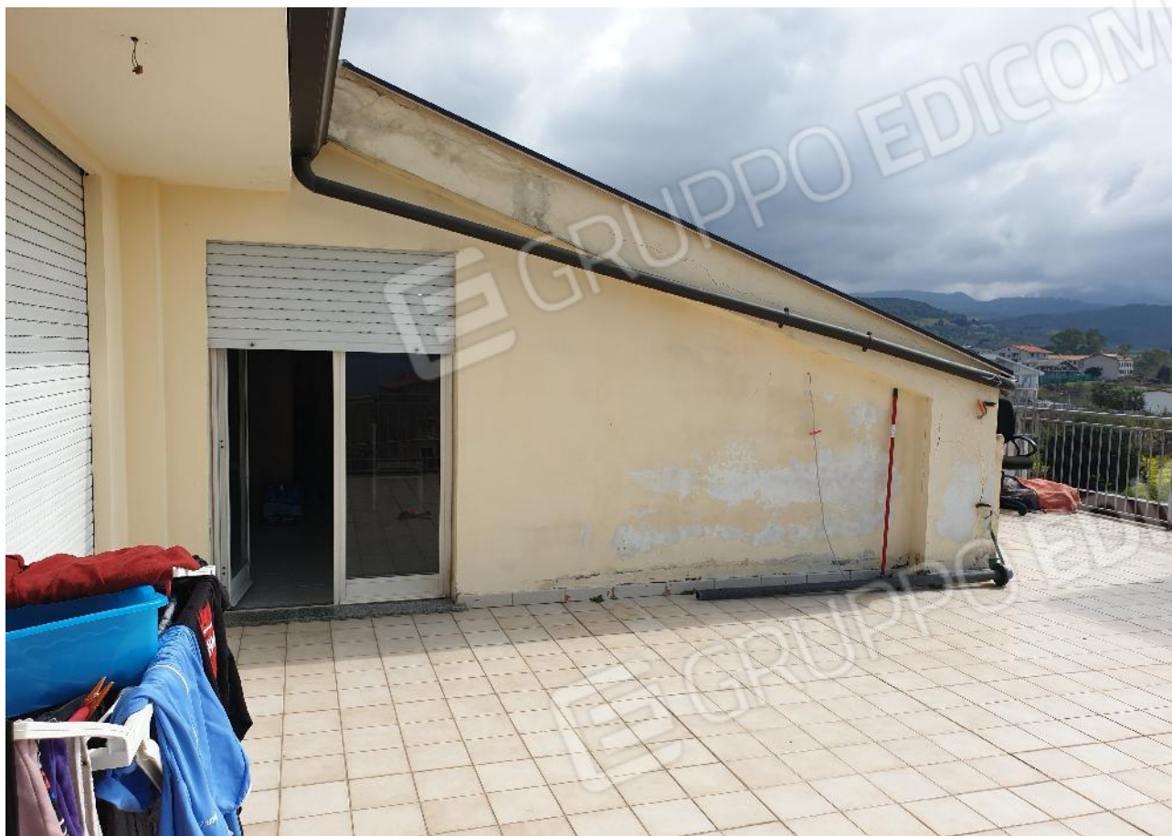
Foto n. 33 Terrazzo S/P2 (lato Est)
