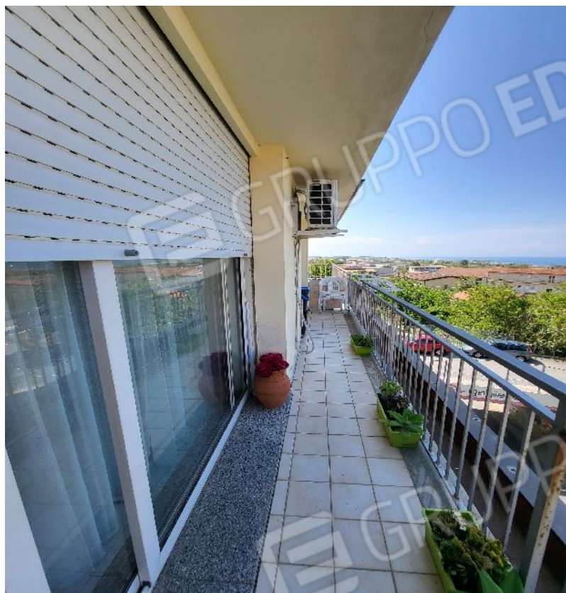
Foto n. 29 Balcone S/P1 (lato Sud)
