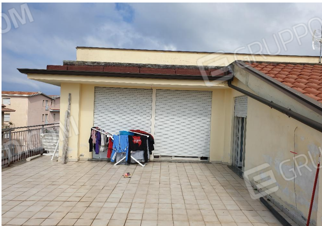
Foto n. 18 Terrazzo (lato Nord – Est)
