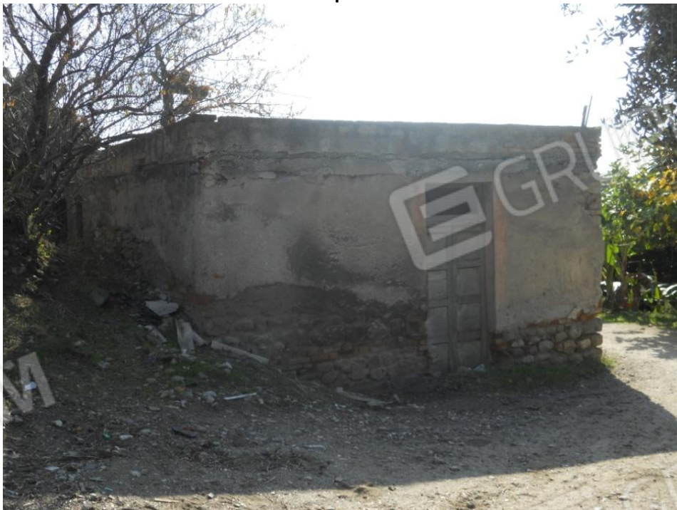
Fabbricato rurale p.lla 140
