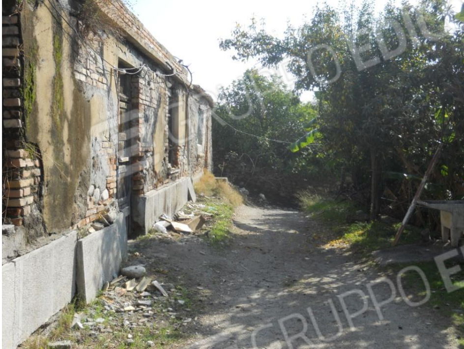
Manufatti insistenti sulla p.lla 142
