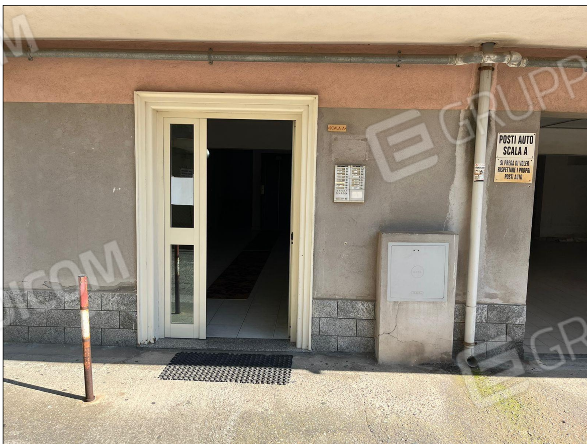
Foto 6: Vista ingresso edificio "A" - condominio "Le Palme"
