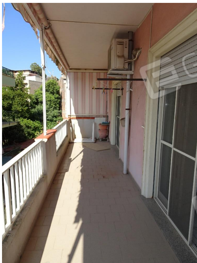
Foto 16: Vista balcone appartamento
