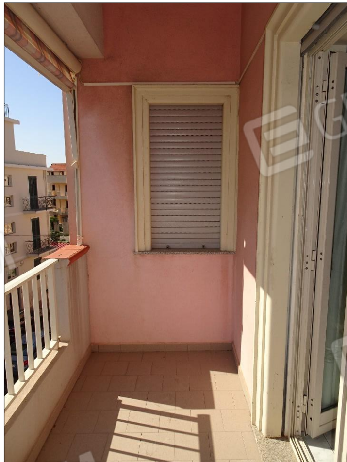
Foto 26: Vista balcone appartamento
