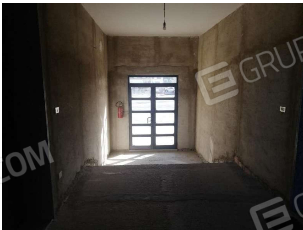
Foto 28. Vista interna dell'ingresso principale e dell'androne condominiale sub 1 B.C.N.C.
