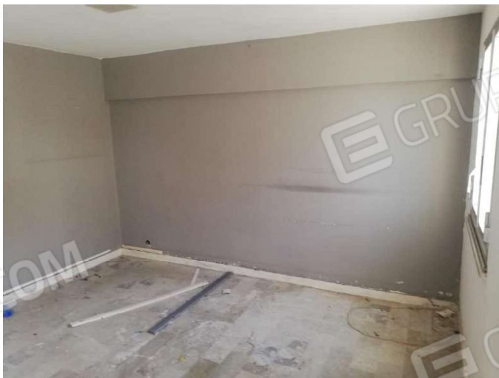
Foto 20. Vista dei locali interni: ambiente 2 adibito ad ufficio.
