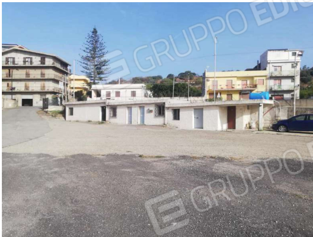
Foto 15. Vista esterna del prospetto principale del fabbricato adibito ad ufficio.
