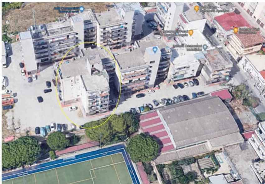
Vista del maggior fabbricato in cui è ubicato l'immobile (estratto da google maps)
