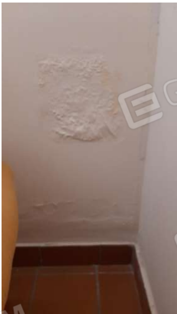
Segni di infiltrazioni al piano Seminterrato
