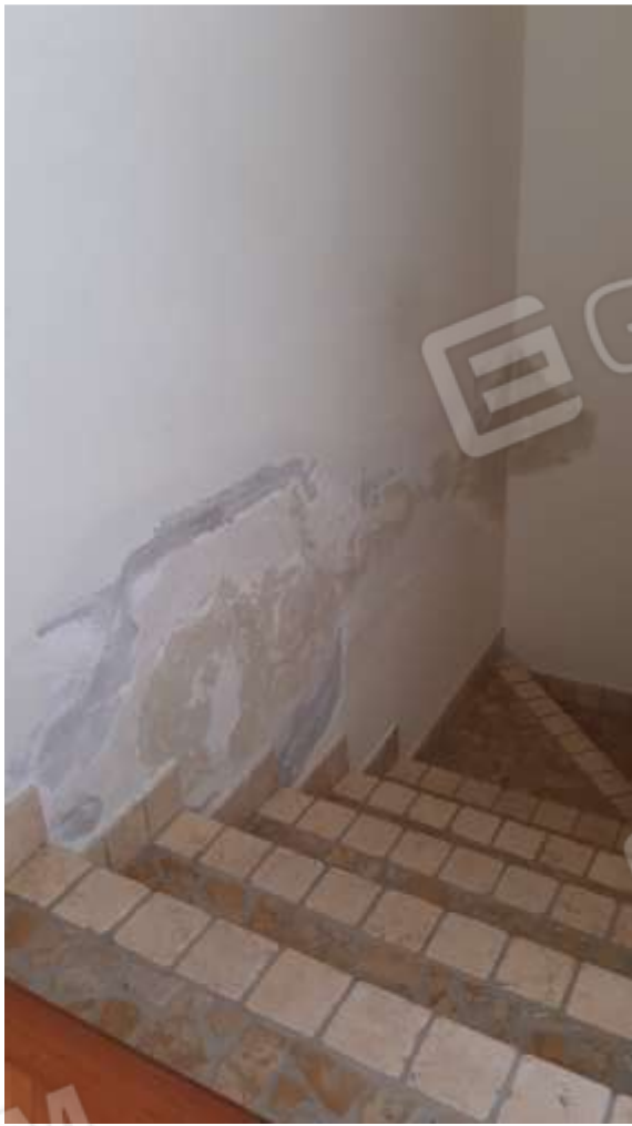
Infiltrazioni e umidità al piano secondo, proveniente dal terrazzo
