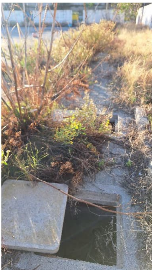
Pozzetti passaggio cavi
