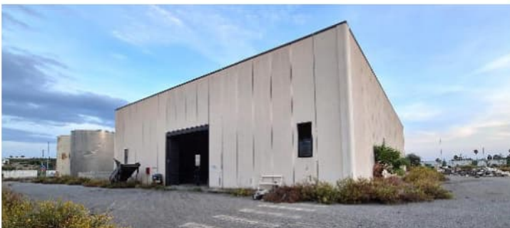
Capannone B _ Vista dall'esterno
