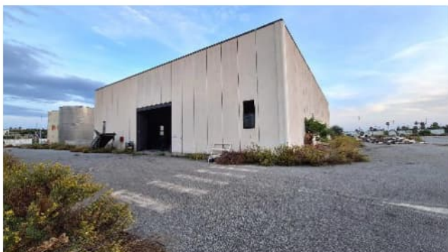
Vista del capannone C
