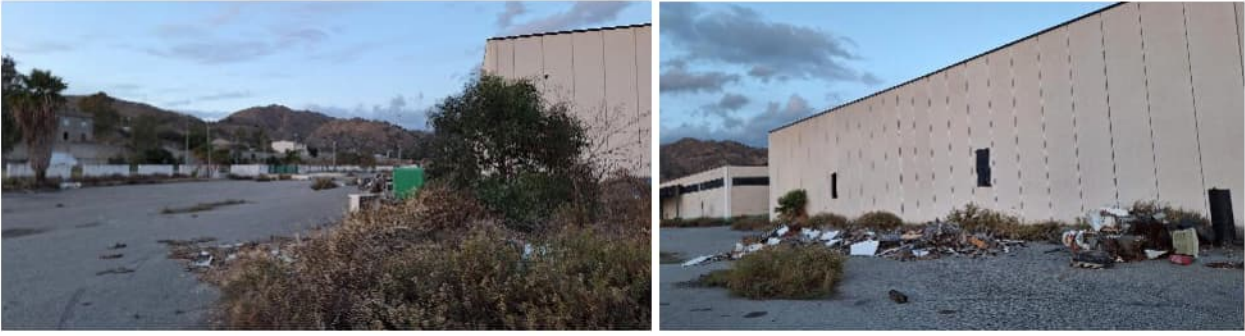
Vista dell'area libera vicino al capannone 2 (C)
