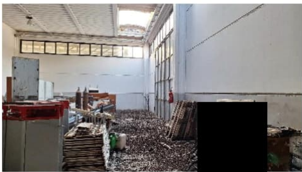
Copertura divelta: deposito capannone B
