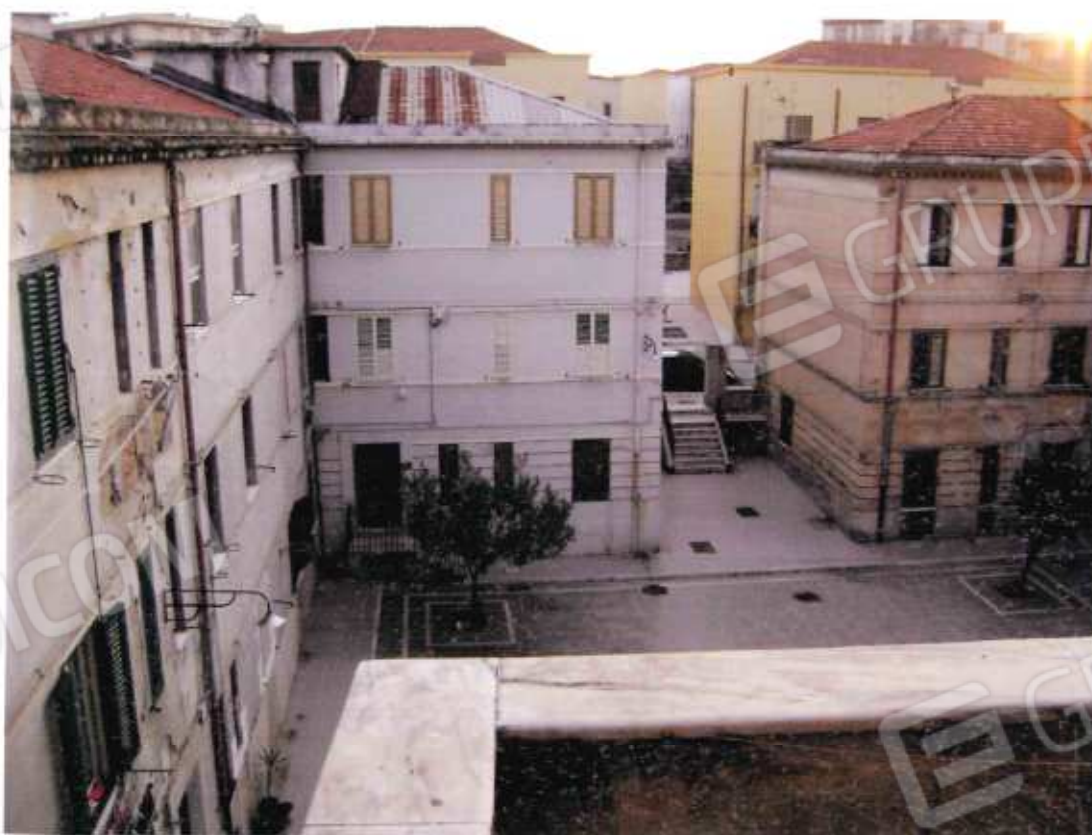
Foto 24 – Balcone in corrispondenza della camera da letto - lato cortile retrostante
