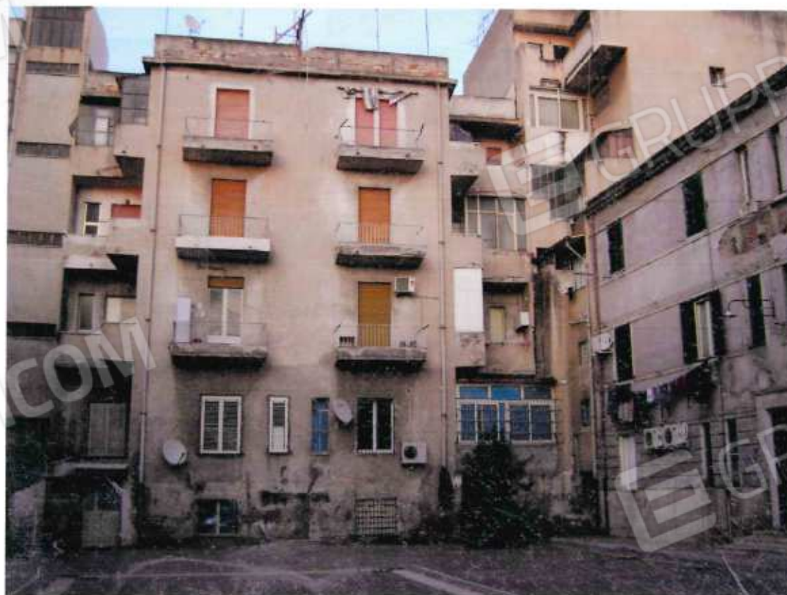
Foto 2 – Prospetto fabbricato lato Cortile retrostante
