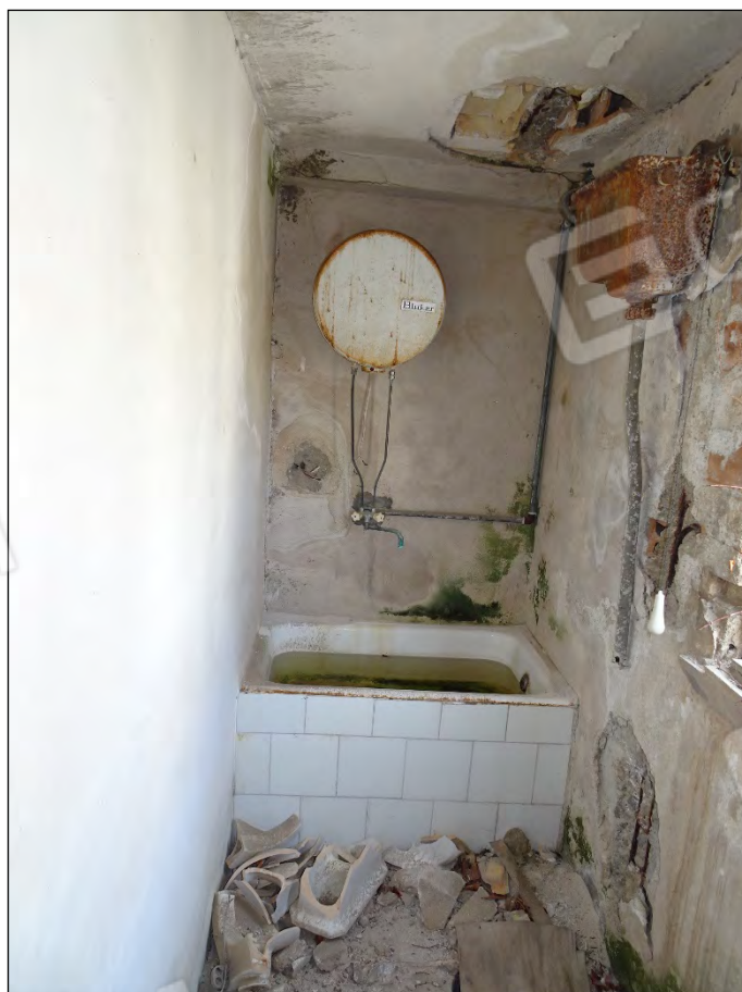
Foto 140: Vista vano tecnico piano copertura
