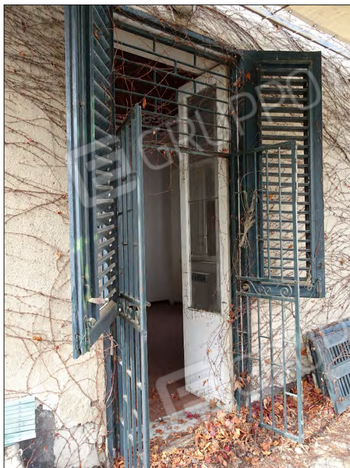
Foto 81: Vista terrazzo lato est immobile piano primo sub 10
