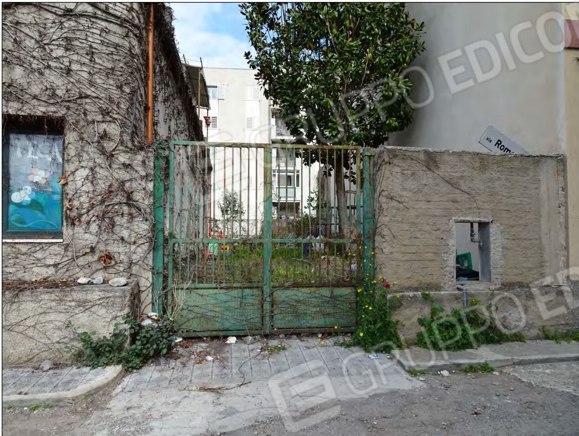
Foto 5: Vista prospetto esterno fabbr. Reggio Cal. località Catona Via Romana n. 29
