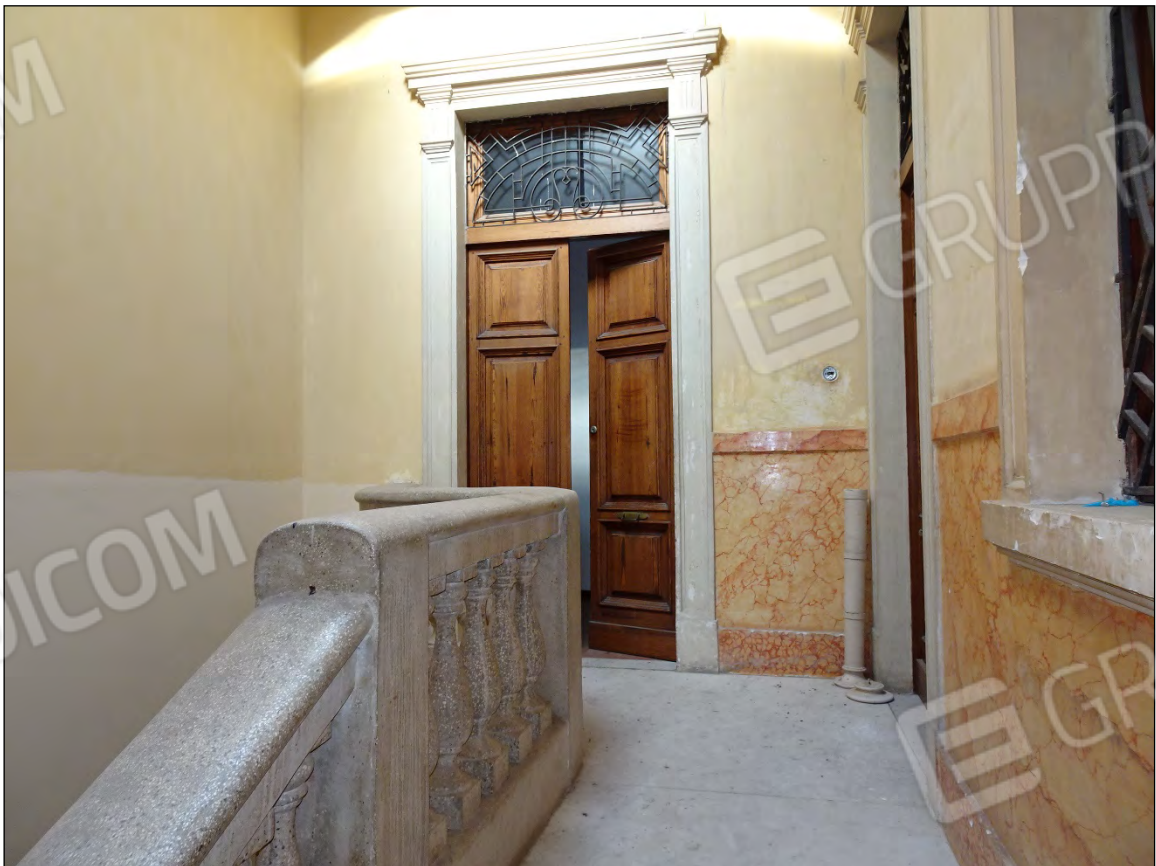
Foto 72: Vista vano scala sub 7 (B.C. ai sub 9 e 10) di accesso al piano primo sub 10
