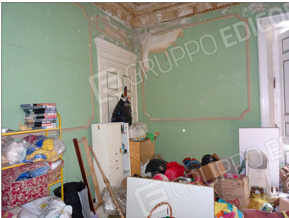
Foto 105: Vista interna vano 5 immobile piano primo sub 10
