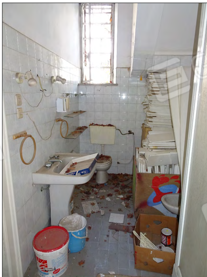
Foto 130: Vista wc immobile piano primo sub 10
