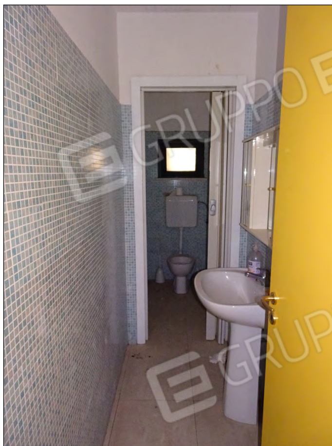
Foto 49: Vista wc 4 immobile piano terra sub 9
