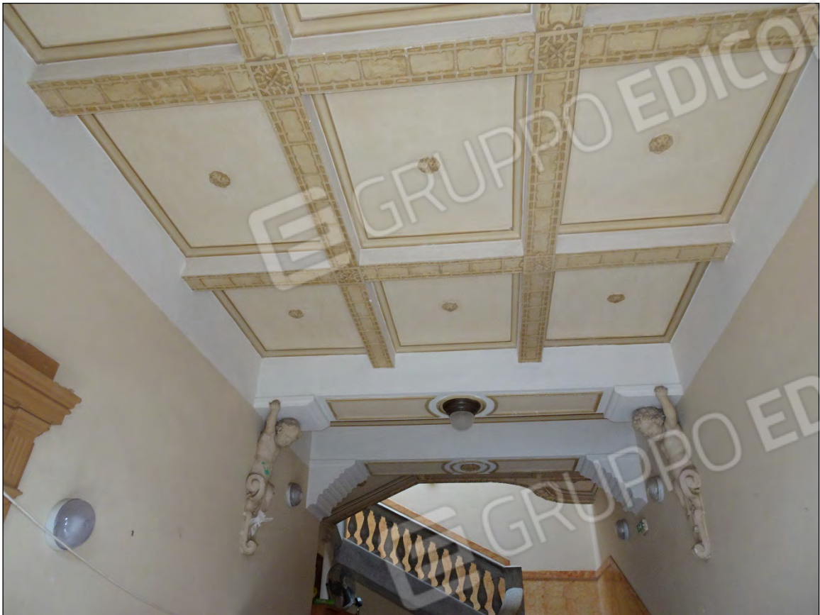
Foto 21: Vista particolare soffitto ingresso sub 7 - bene comune ai sub 9 e 10
