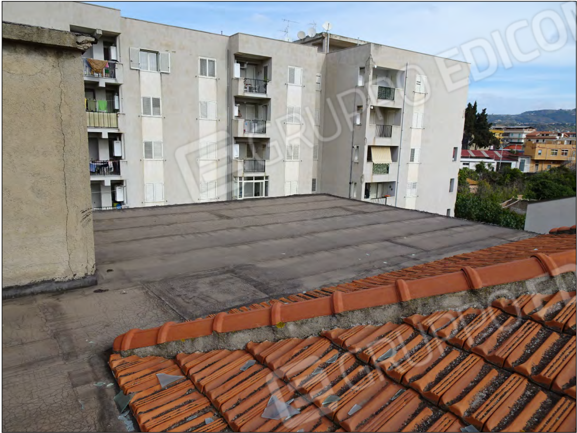
Foto 145: Vista piano copertura
