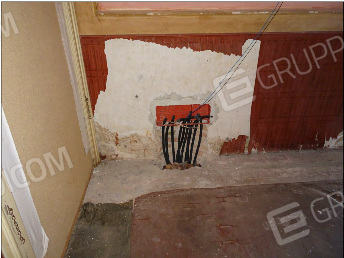
Foto 102: Vista interna vano 6 immobile piano primo sub 10
