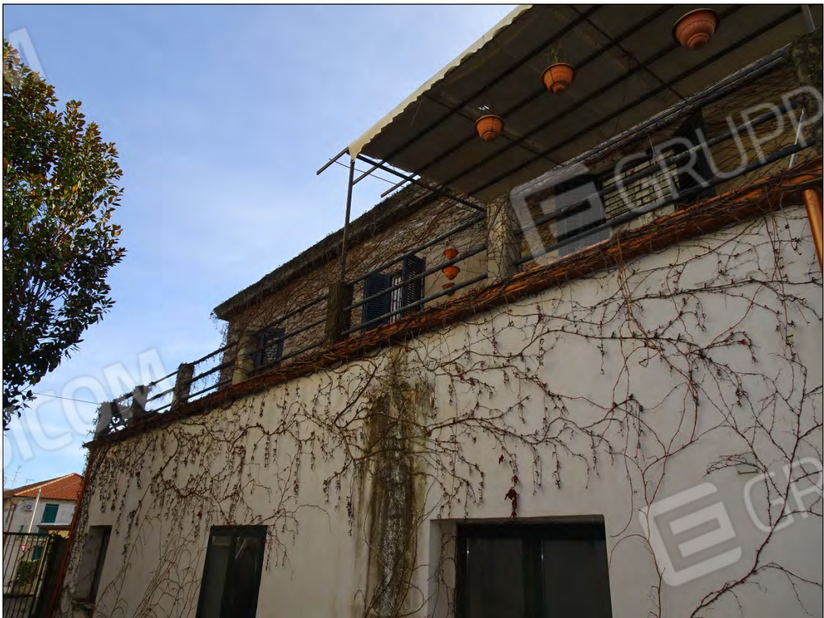
Foto 18: Vista prospetto esterno lato est
