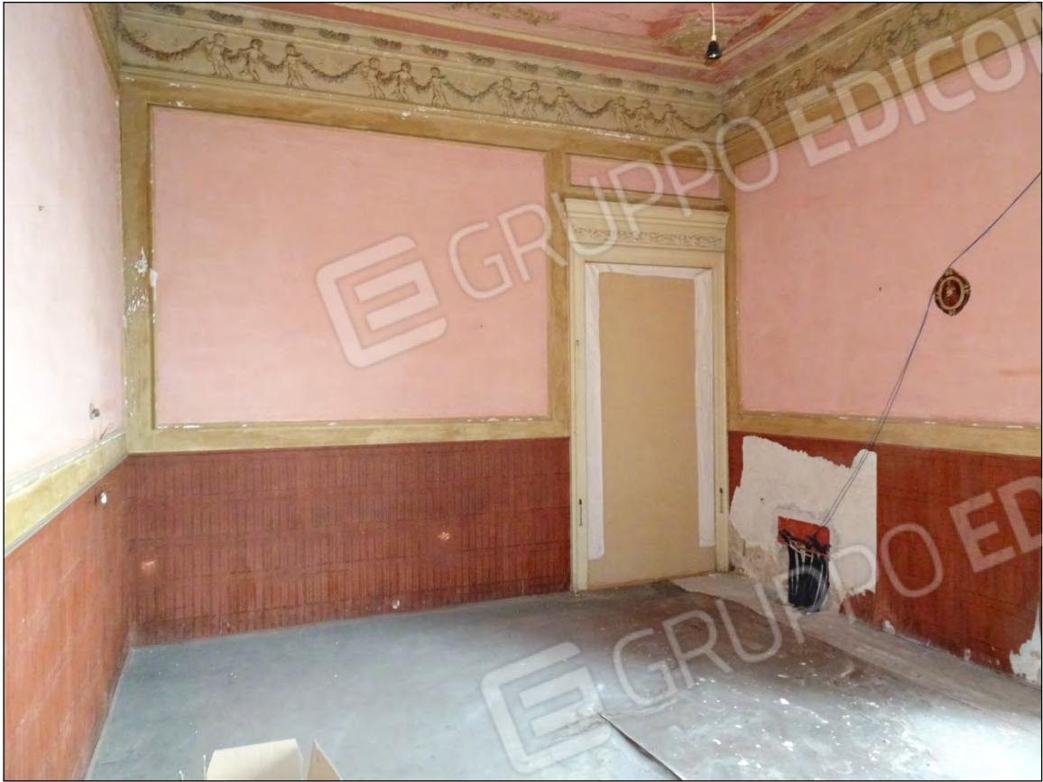
Foto 99: Vista interna vano 6 immobile piano primo sub 10
