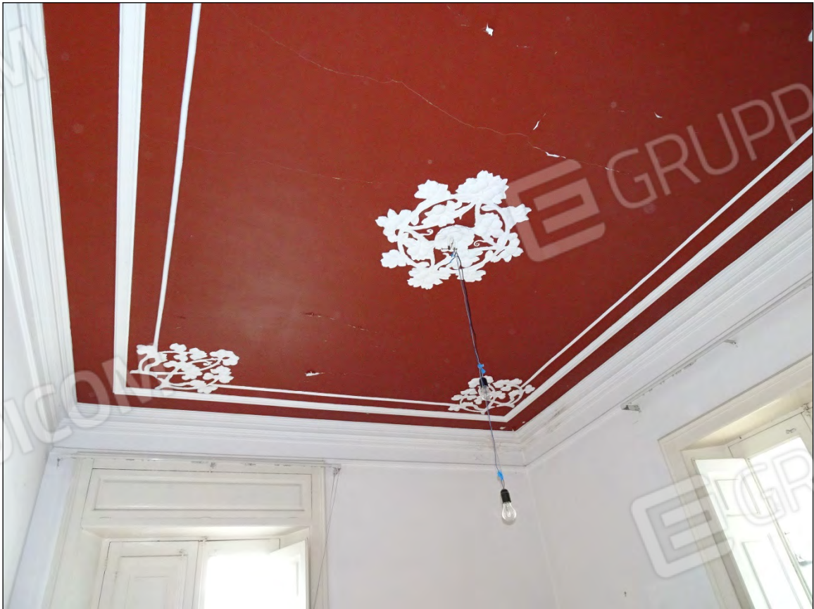
Foto 84: Vista interna vano 2 immobile piano primo sub 10
