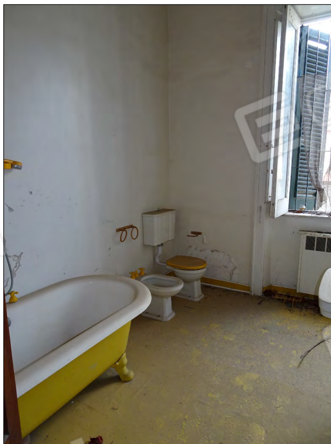
Foto 120: Vista bagno immobile piano primo sub 10
