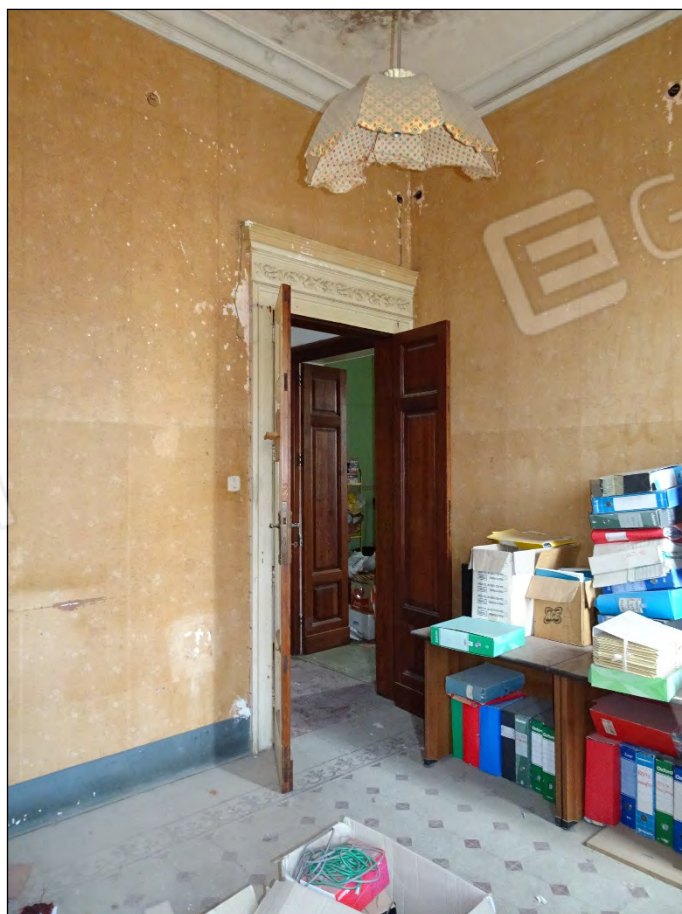
Foto 114: Vista interna vano 3 immobile piano primo sub 10
