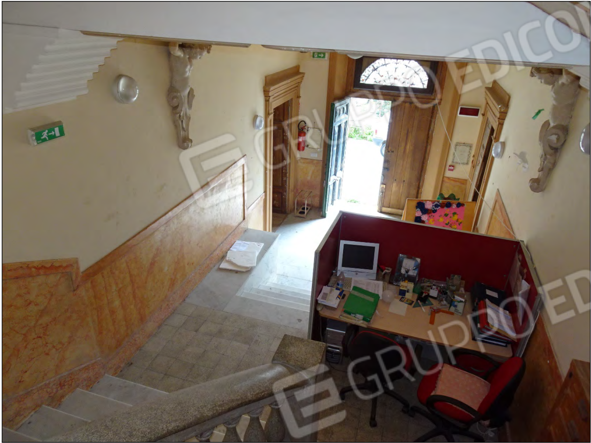
Foto 23: Vista ingresso sub 7 - bene comune ai sub 9 e 10
