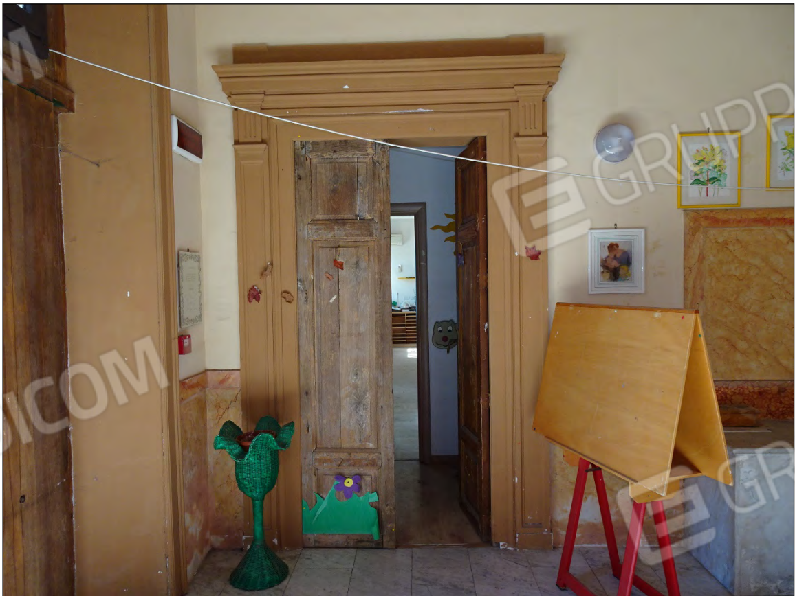
Foto 24: Vista ingresso immobile piano terra sub 9
