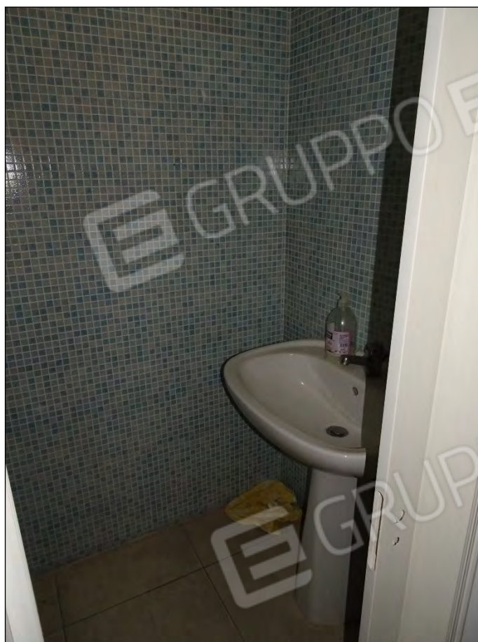
Foto 37: Vista wc 3 immobile piano terra sub 9
