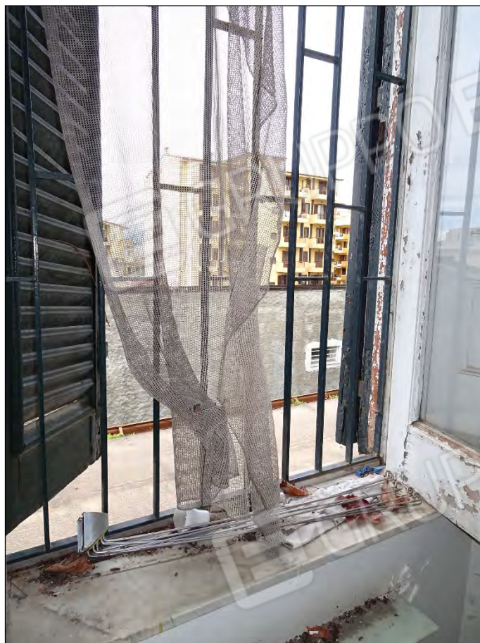
Foto 121: Vista bagno immobile piano primo sub 10
