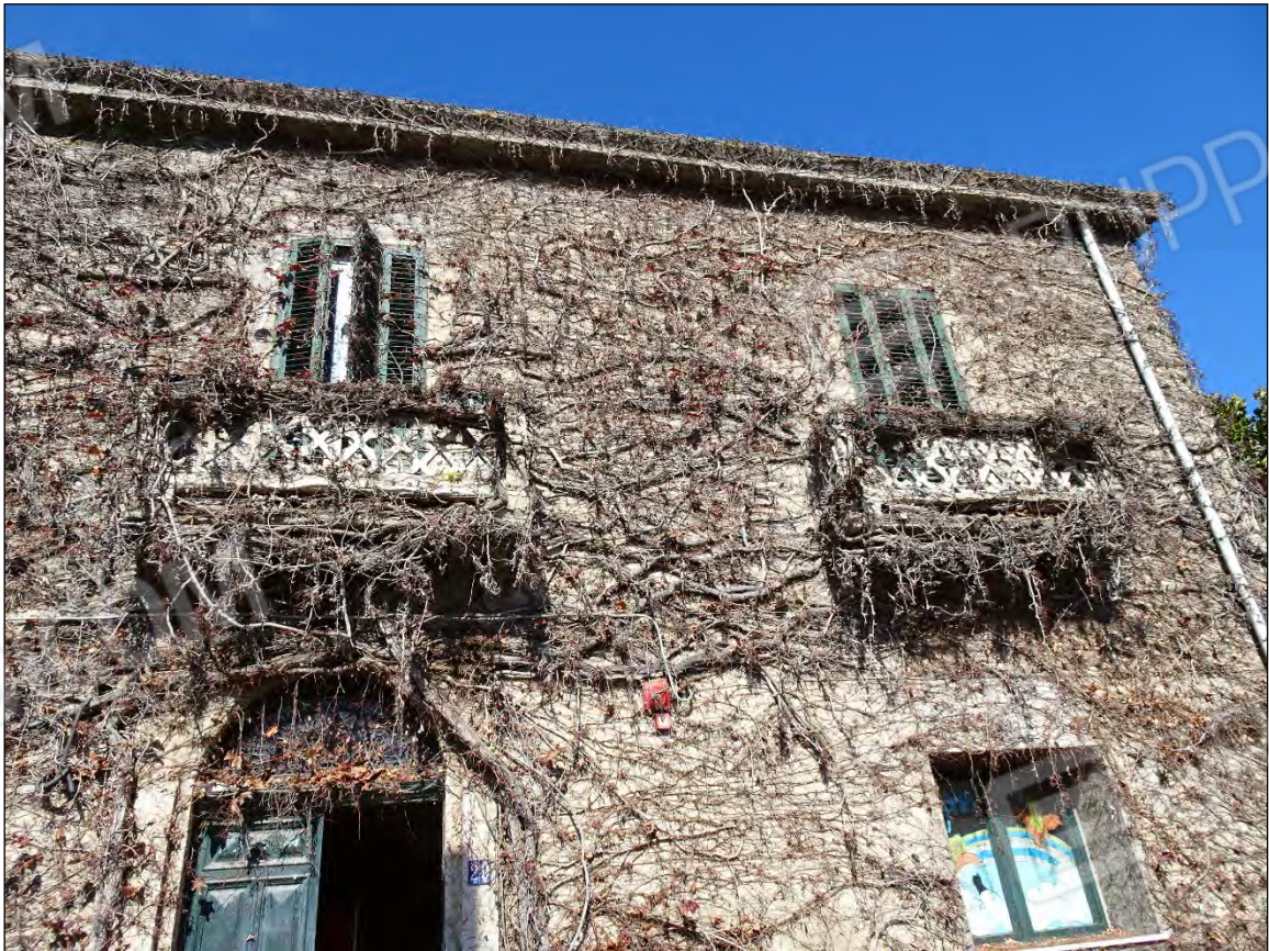
Foto 8: Vista prospetto esterno fabbr. Reggio Cal. località Catona Via Romana n. 29
