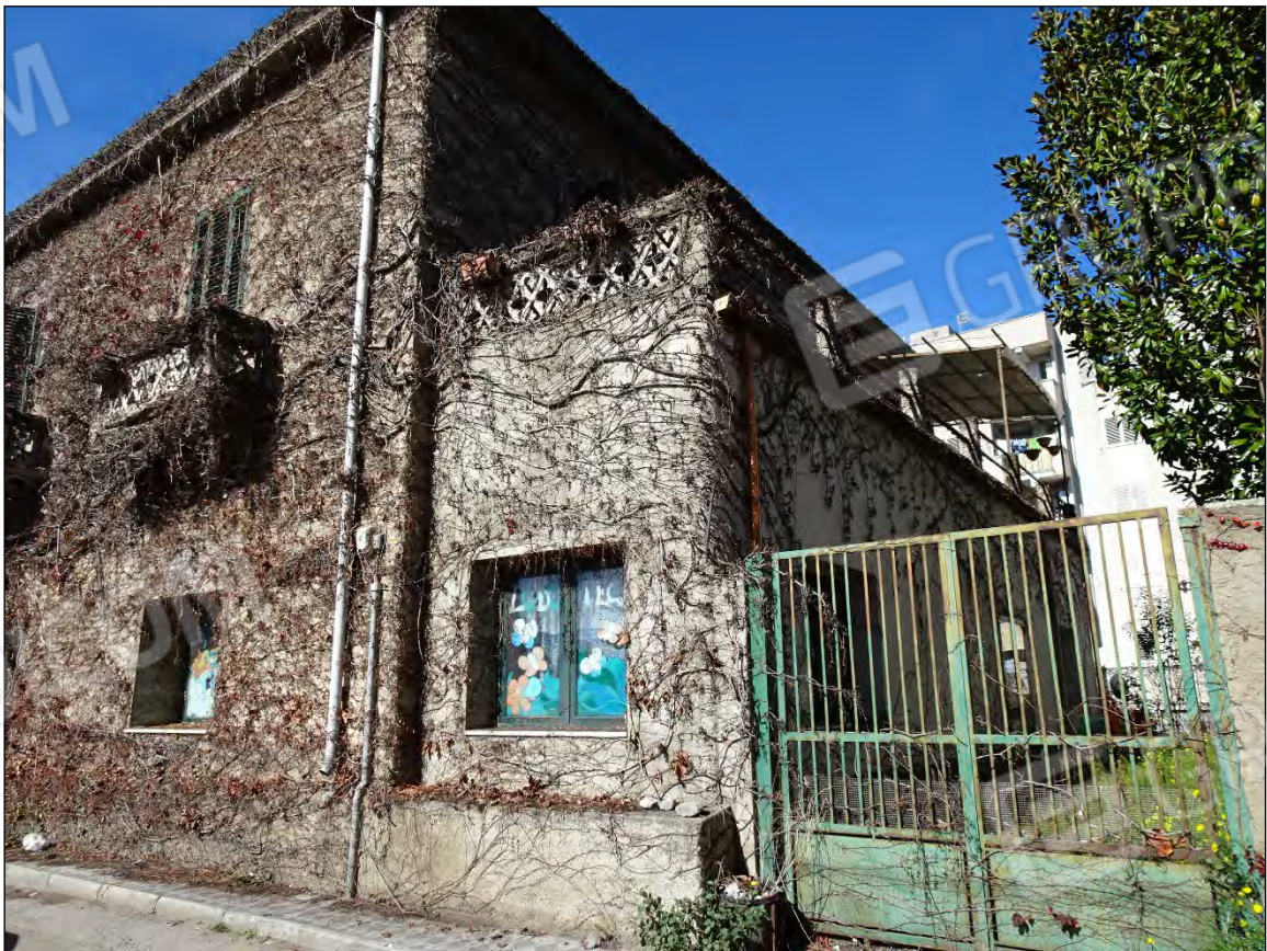
Foto 4: Vista prospetto esterno fabbr. Reggio Cal. localiyà Catona Via Romana n. 29
