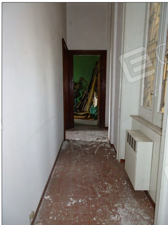
Foto 118: Vista corridoio immobile piano primo sub 10
