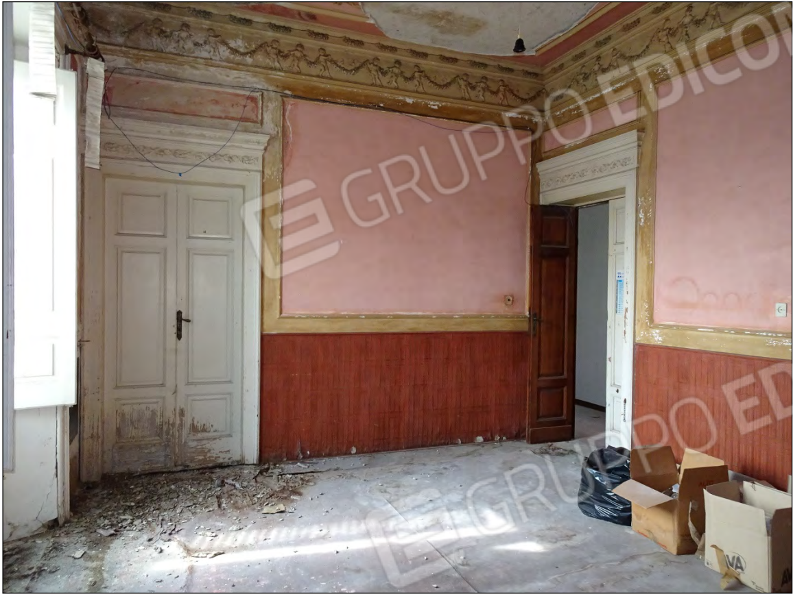
Foto 103: Vista interna vano 6 immobile piano primo sub 10
