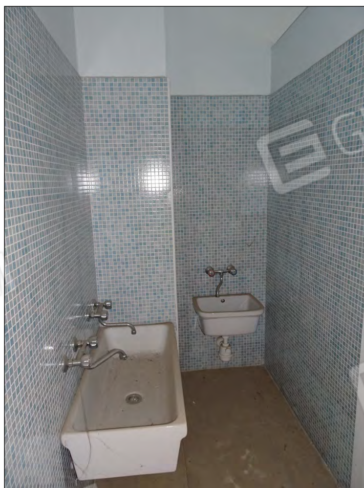
Foto 44: Vista wc 2 immobile piano terra sub 9
