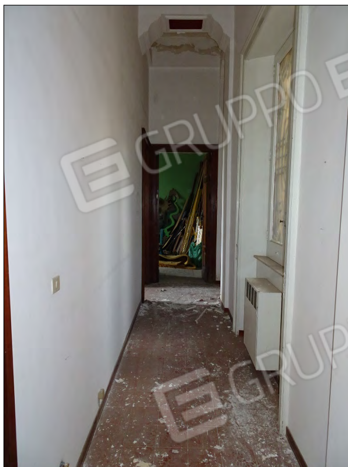
Foto 109: Vista corridoio immobile piano primo sub 10
