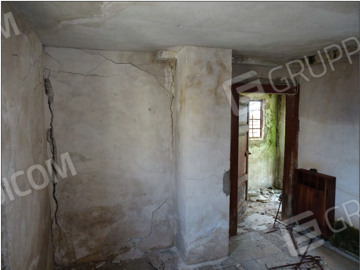
Foto 138: Vista vano tecnico piano copertura
