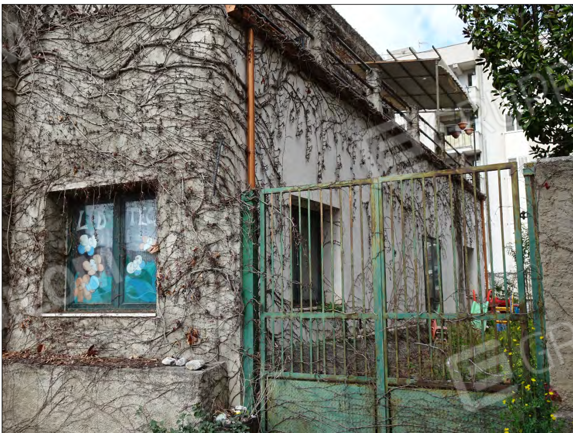
Foto 6: Vista prospetto esterno fabbr. Reggio Cal. località Catona Via Romana n. 29
