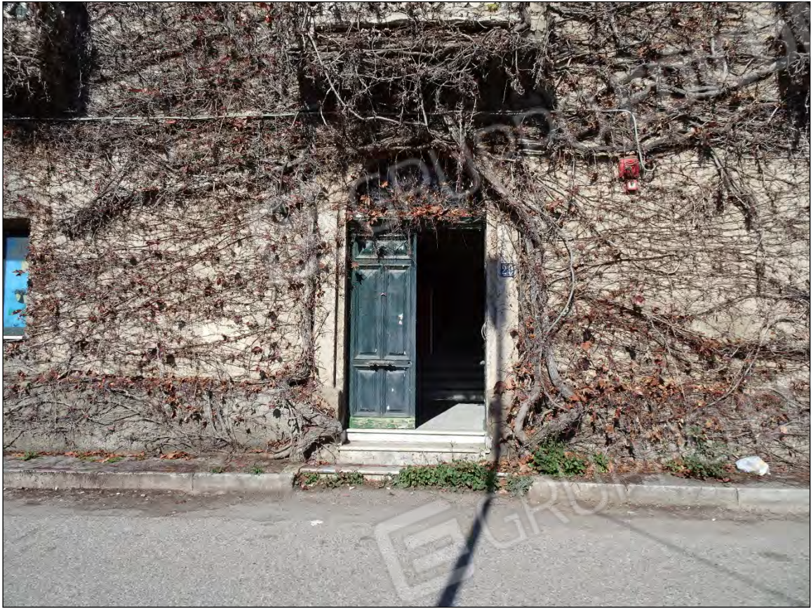
Foto 7: Vista ingresso fabbricato Reggio Cal. località Catona Via Romana n. 29
