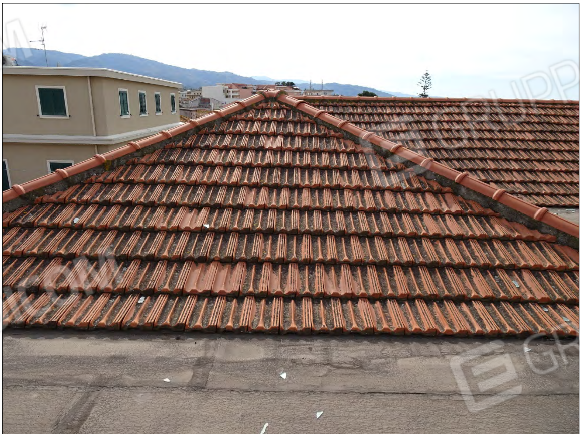
Foto 148: Vista piano copertura
