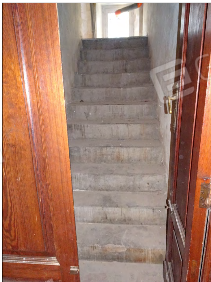
Foto 132: Vista scala di accesso al piano copertura
