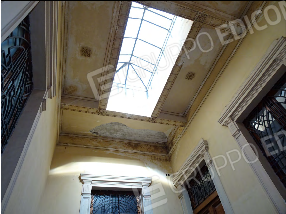
Foto 71: Vista vano scala sub 7 (B.C. ai sub 9 e 10) di accesso al piano primo sub 10
