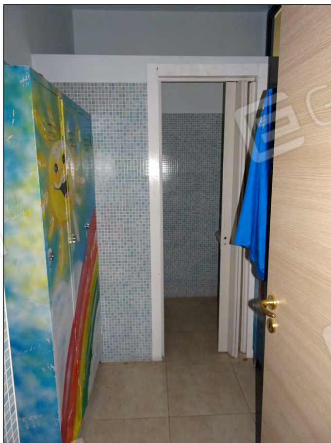
Foto 36: Vista wc 3 immobile piano terra sub 9
