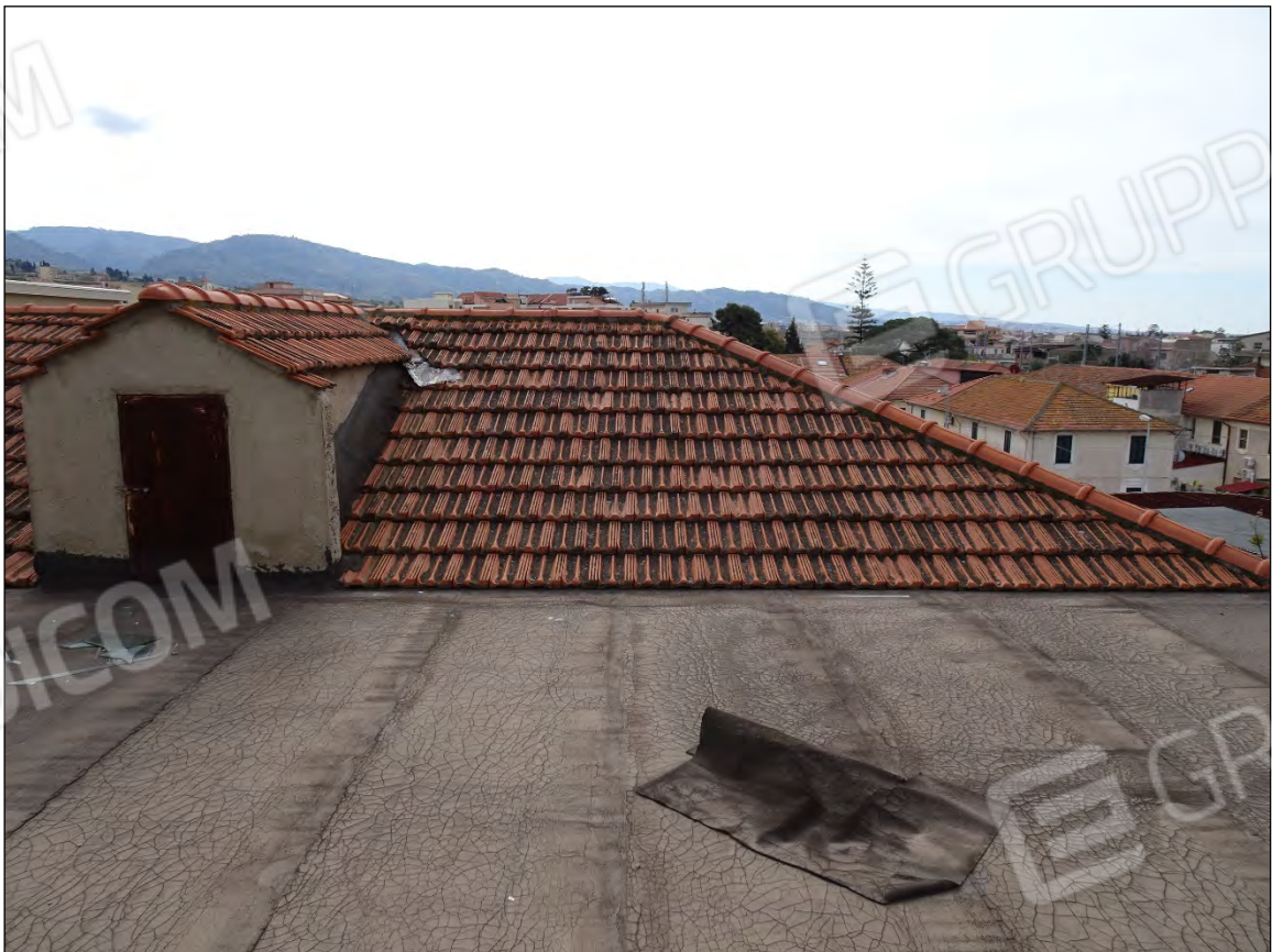
Foto 144: Vista piano copertura
