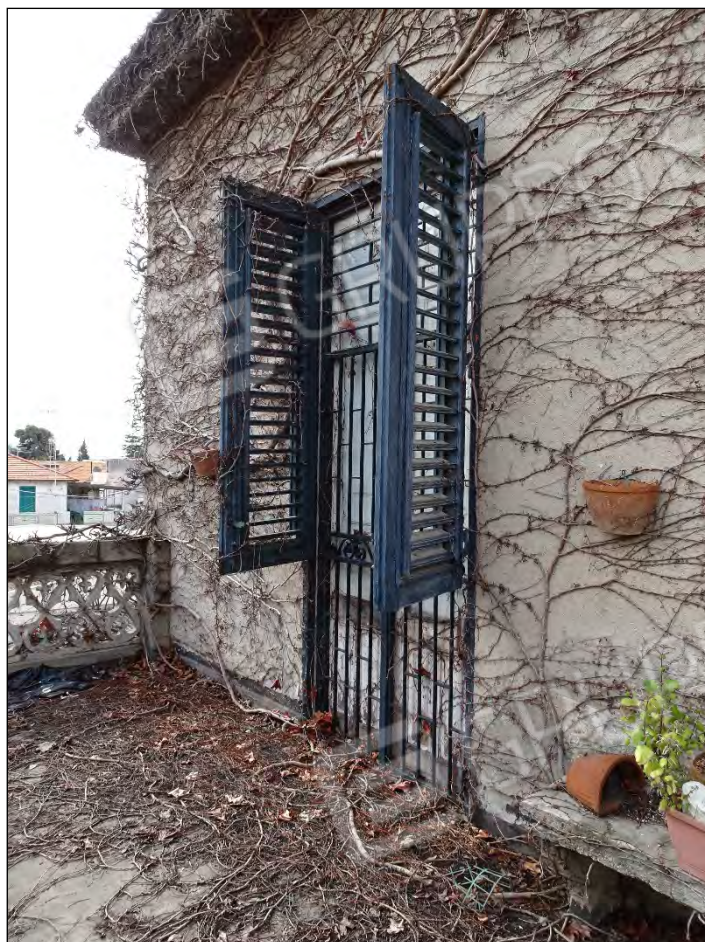
Foto 79: Vista terrazzo lato est immobile piano primo sub 10
