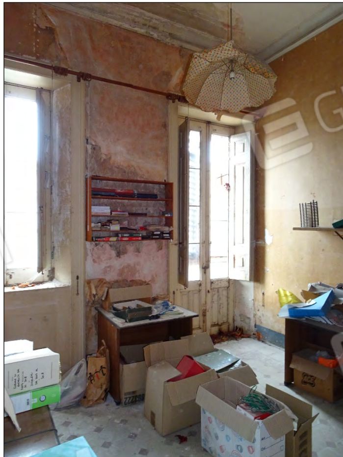
Foto 112: Vista interna vano 3 immobile piano primo sub 10
