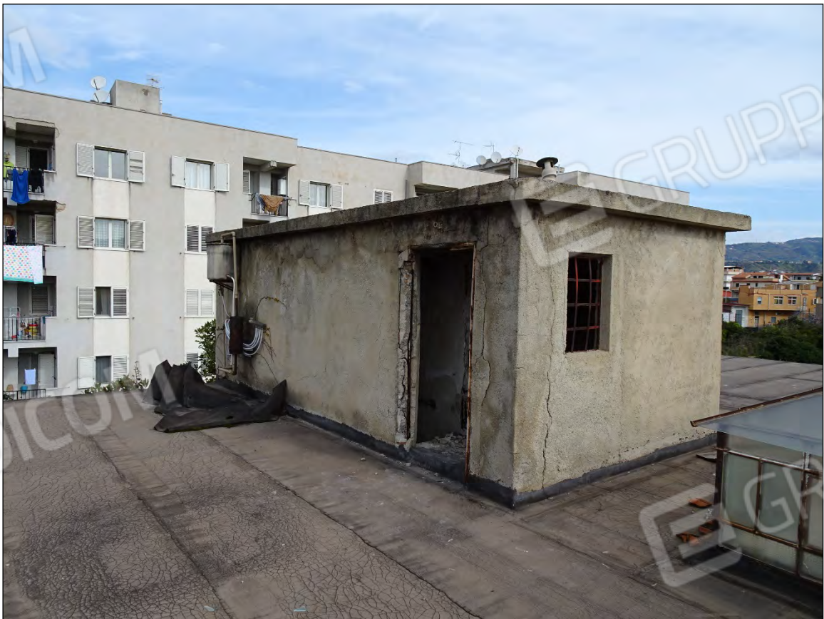
Foto 142: Vista piano copertura e vano tecnico
