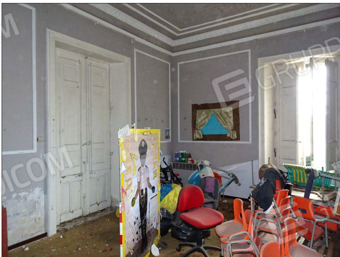
Foto 92: Vista interna vano 7 immobile piano primo sub 10
