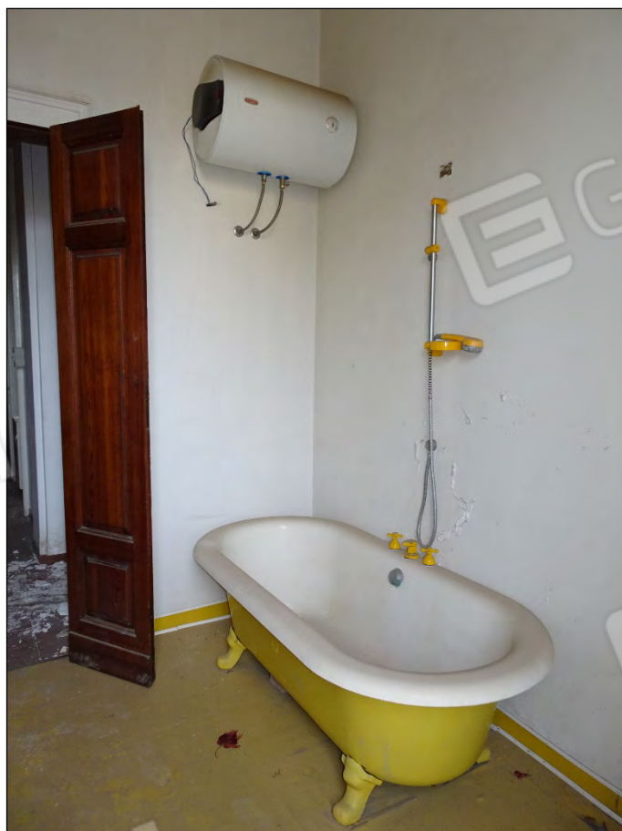
Foto 122: Vista bagno immobile piano primo sub 10
