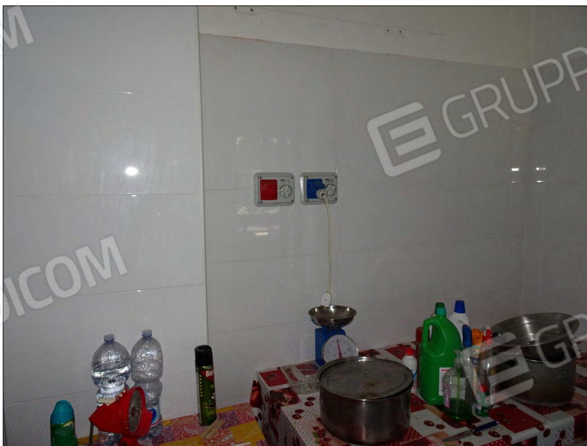
Foto 54: Vista vano cucina immobile piano terra sub 9 - particolare impianto elettrico
