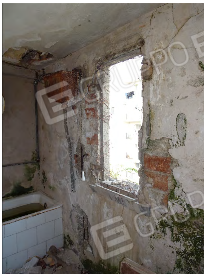
Foto 139: Vista vano tecnico piano copertura
