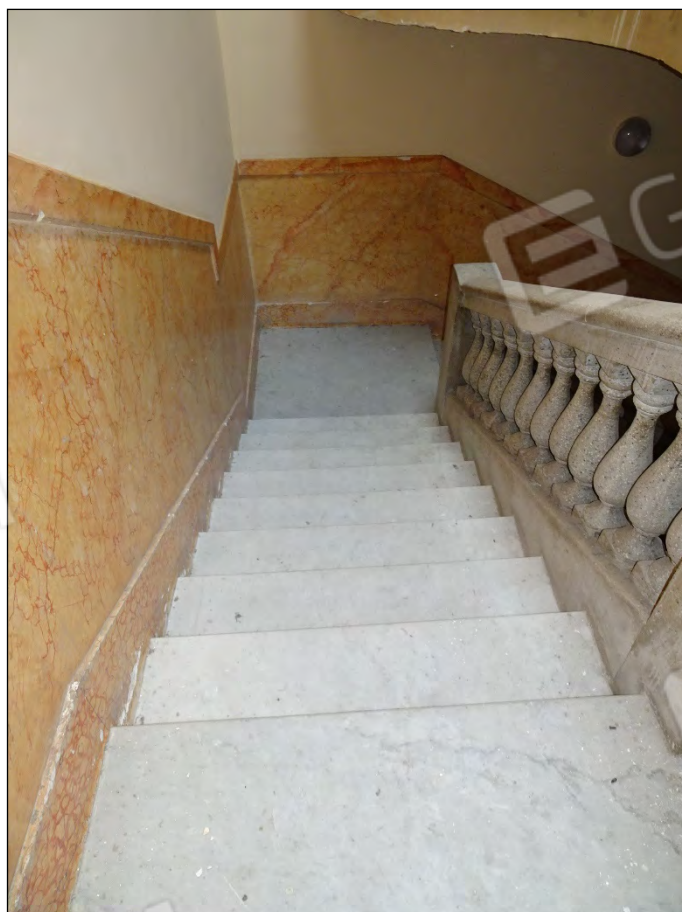
Foto 70: Vista vano scala sub 7 (B.C. ai sub 9 e 10) di accesso al piano primo sub 10
