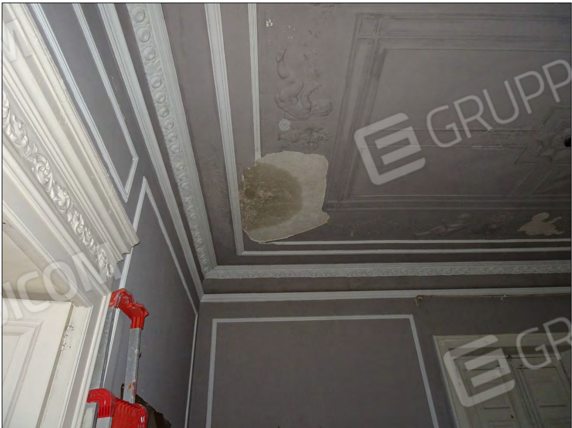
Foto 94: Vista interna vano 7 immobile piano primo sub 10
