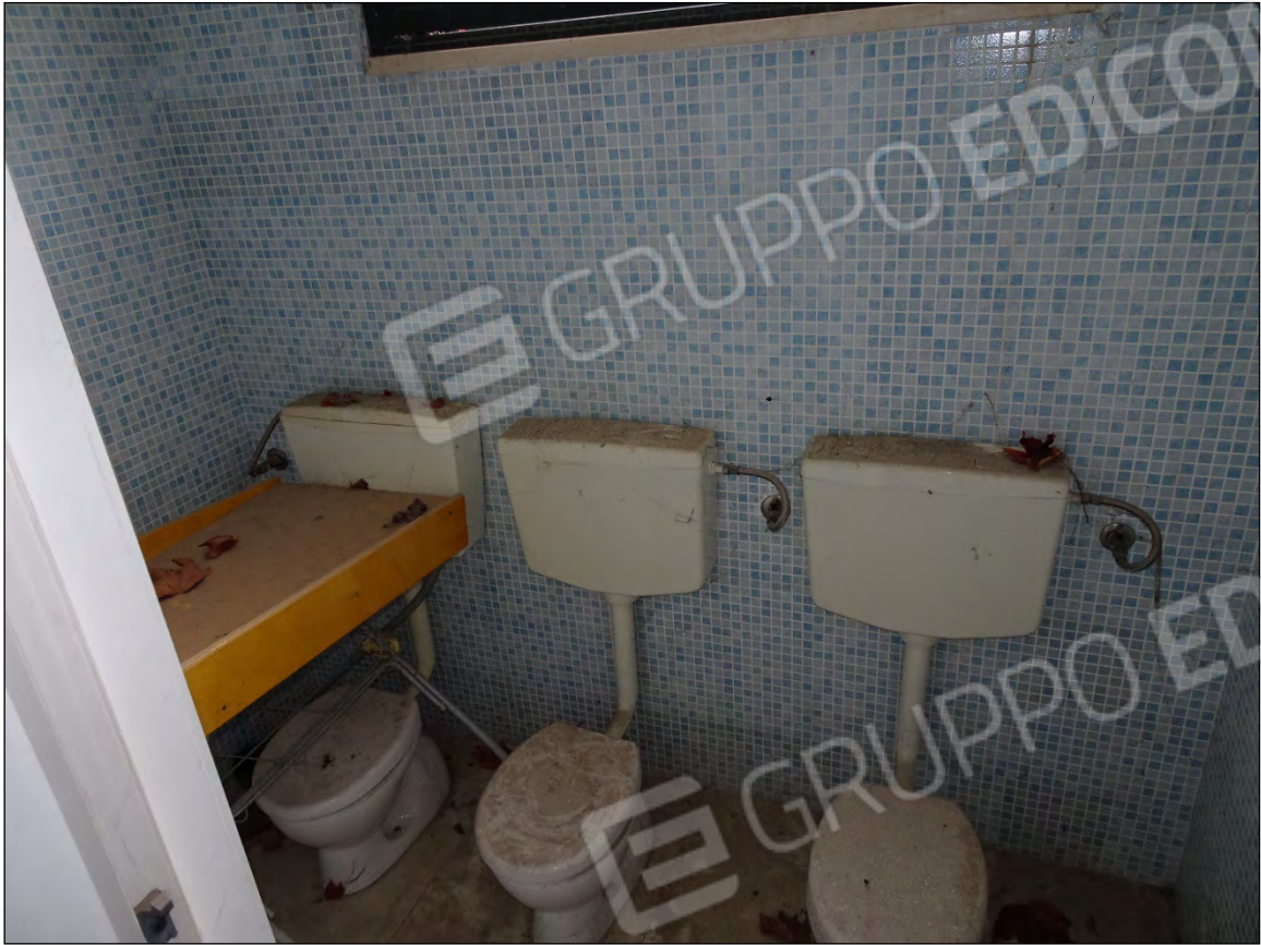
Foto 45: Vista wc 2 immobile piano terra sub 9
