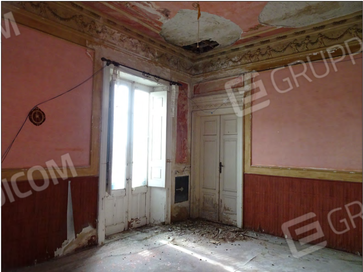
Foto 100: Vista interna vano 6 immobile piano primo sub 10
