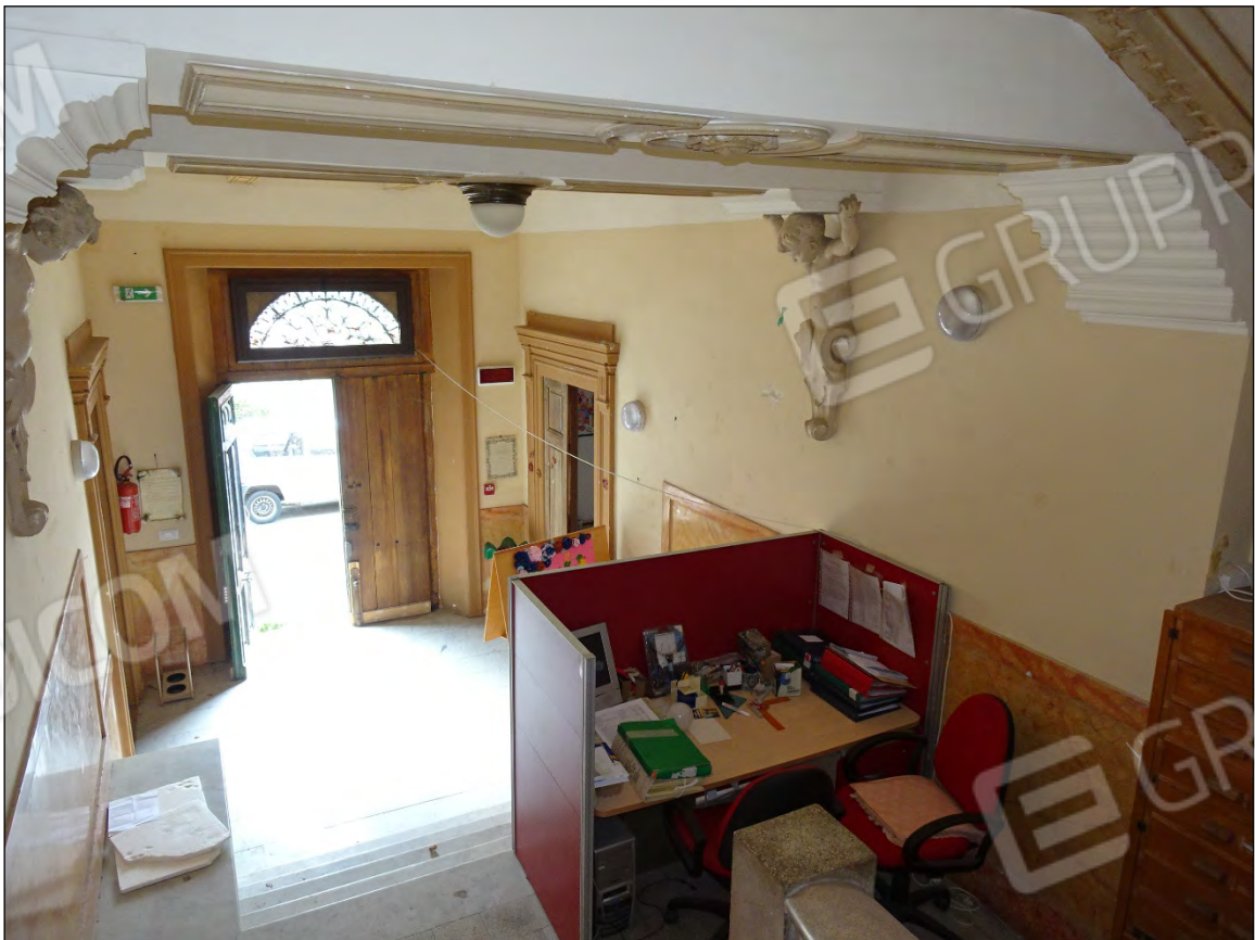
Foto 22: Vista ingresso sub 7 - bene comune ai sub 9 e 10
