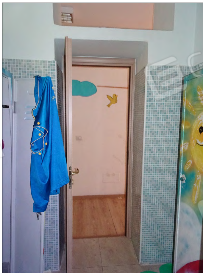
Foto 38: Vista wc 3 immobile piano terra sub 9
