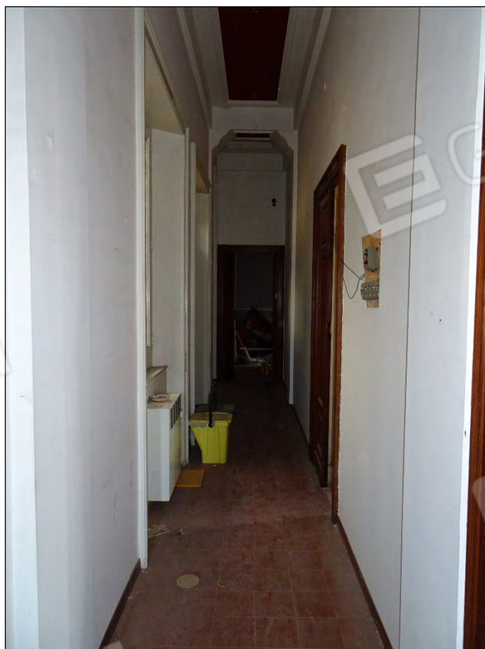
Foto 110: Vista corridoio immobile piano primo sub 10
