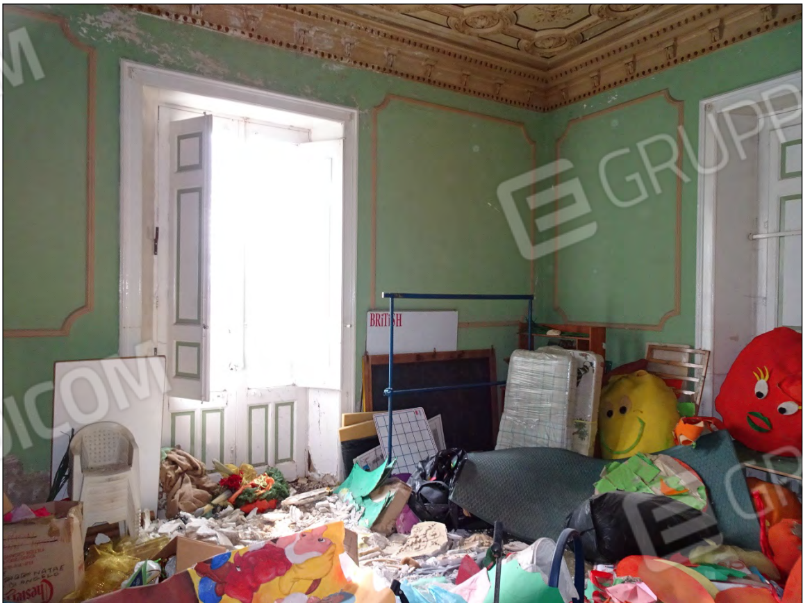
Foto 104: Vista interna vano 5 immobile piano primo sub 10
