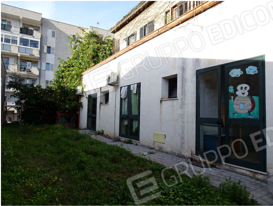
Foto 15: Vista prospetto esterno lato ovest
