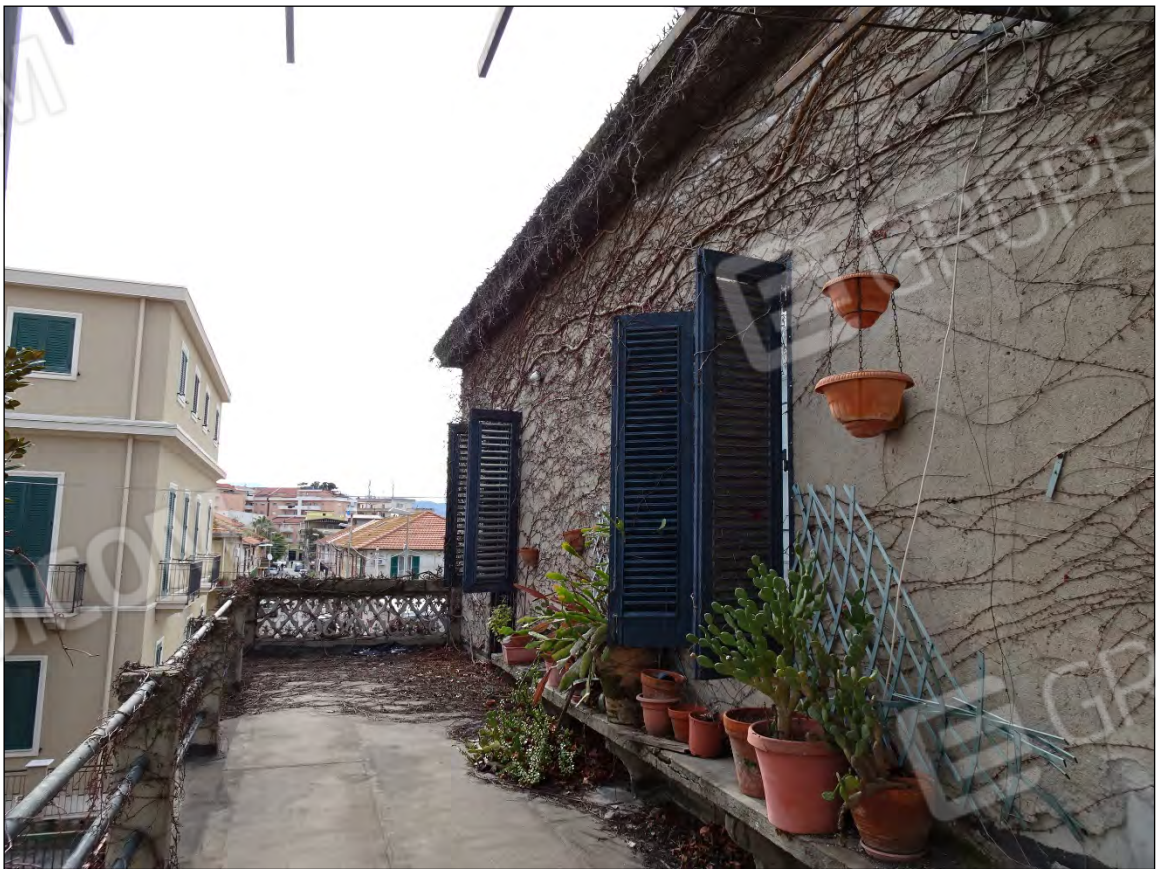
Foto 78: Vista terrazzo lato est immobile piano primo sub 10
