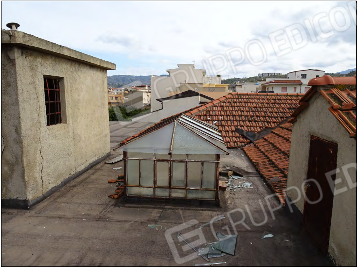
Foto 143: Vista piano copertura
