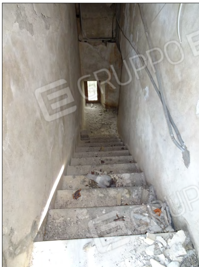
Foto 135: Vista scala di accesso al piano copertura
