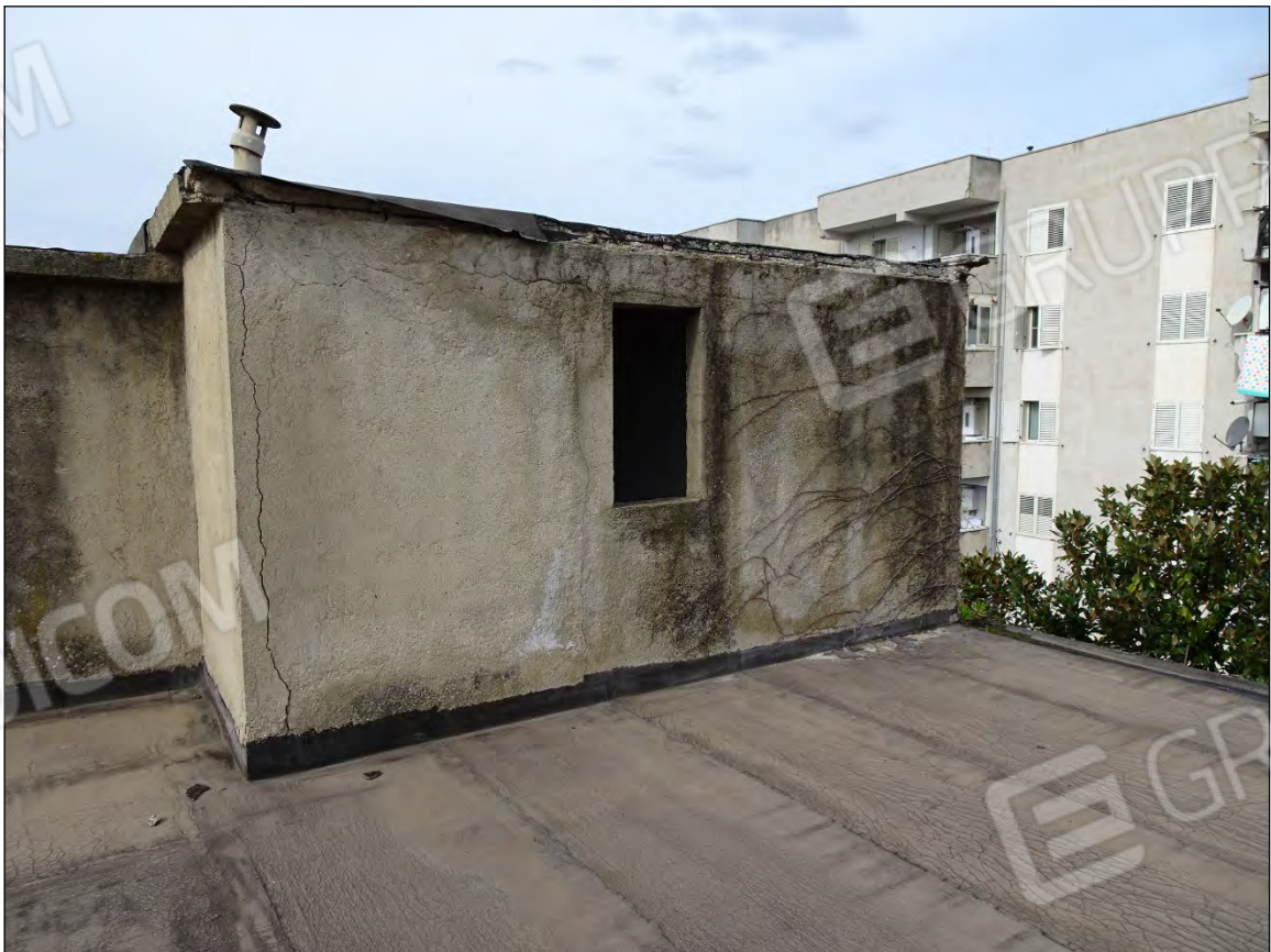
Foto 146: Vista piano copertura e vano tecnico
