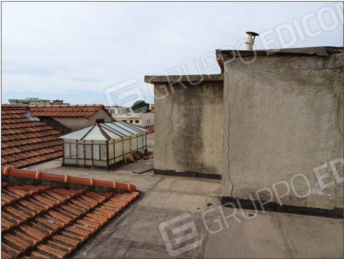
Foto 147: Vista piano copertura e vano tecnico
