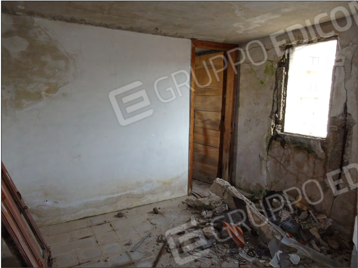
Foto 137: Vista vano tecnico piano copertura
