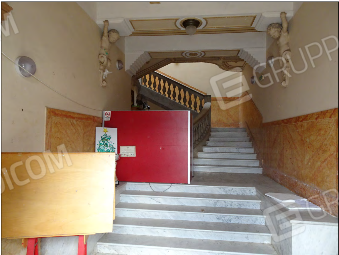
Foto 20: Vista ingresso sub 7 - bene comune ai sub 9 e 10
