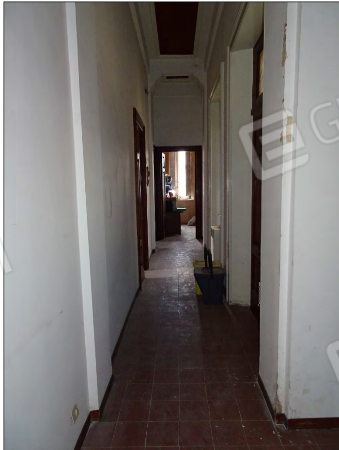
Foto 96: Vista corridoio immobile piano primo sub 10
