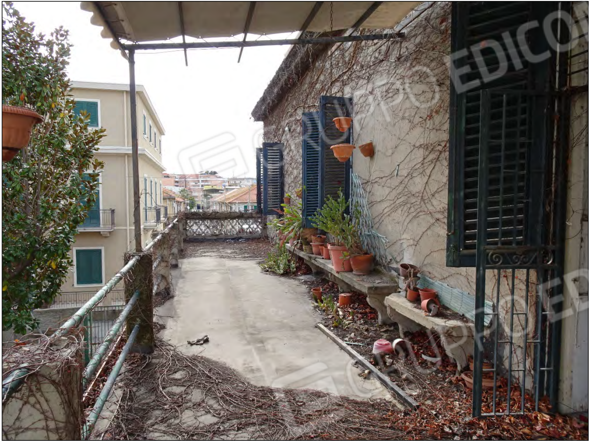
Foto 77: Vista terrazzo lato est immobile piano primo sub 10
