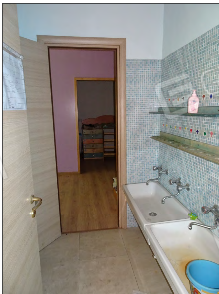
Foto 28: Vista wc 1 immobile piano terra sub 9
