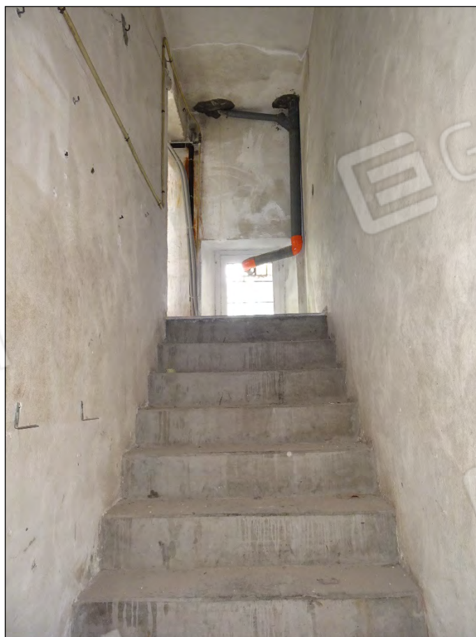
Foto 134: Vista scala di accesso al piano copertura
