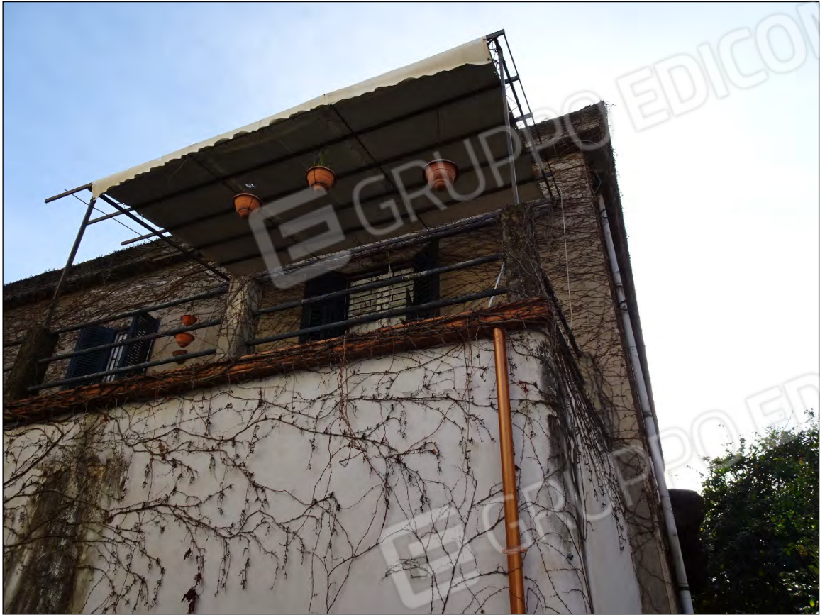
Foto 19: Vista prospetto esterno lato est
