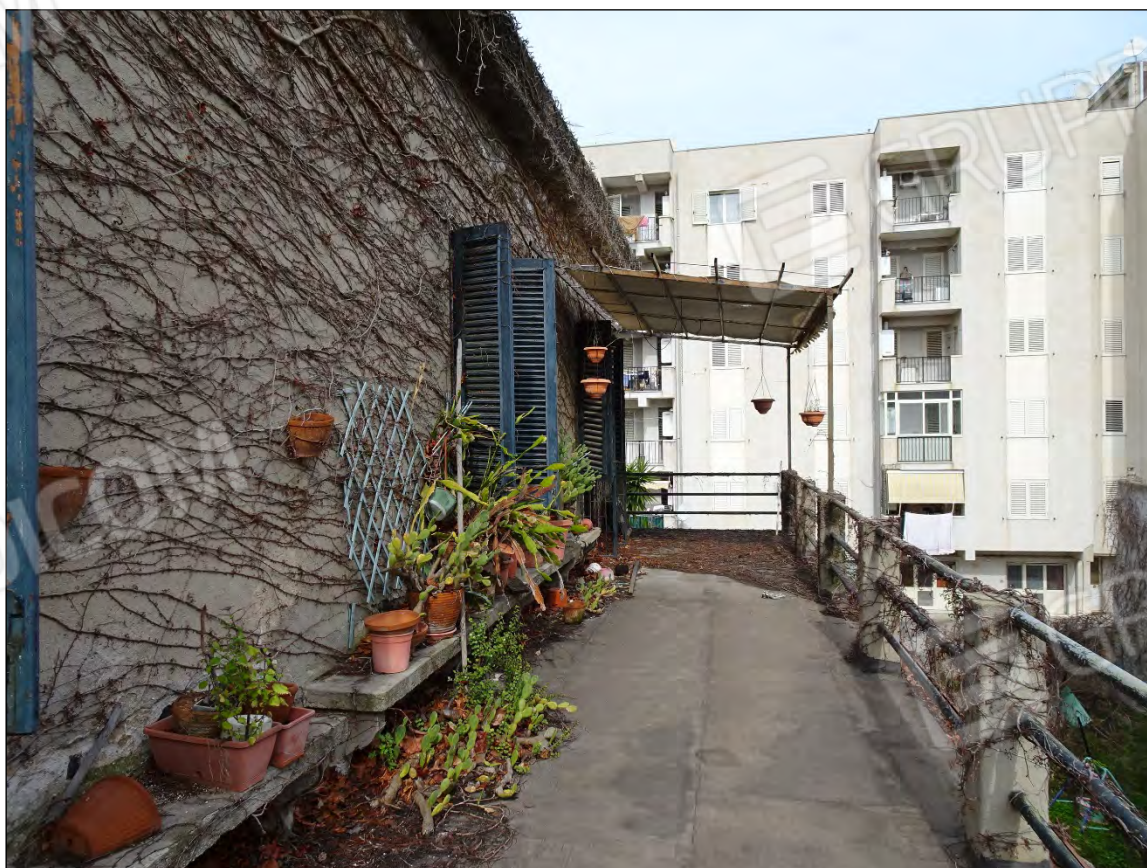
Foto 80: Vista terrazzo lato est immobile piano primo sub 10
