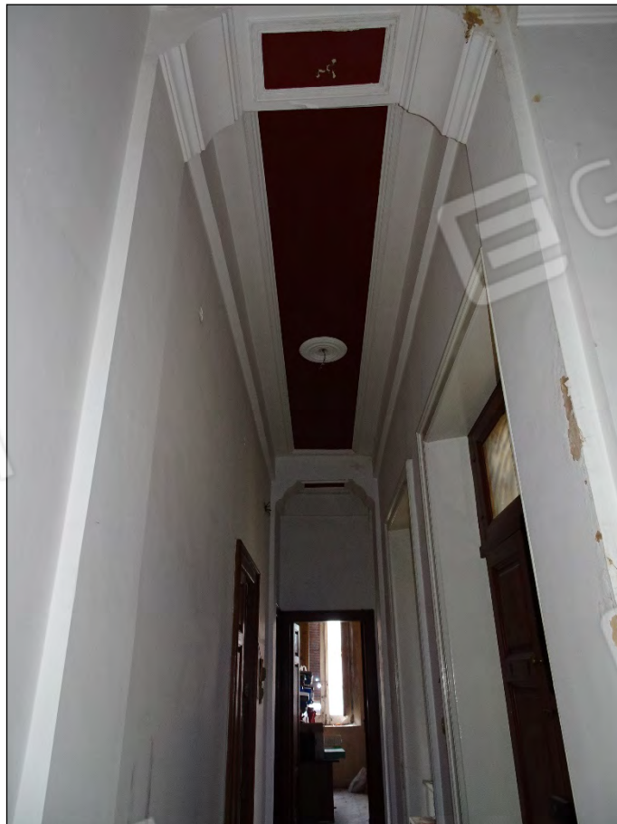
Foto 98: Vista particolare soffitto corridoio immobile piano primo sub 10
