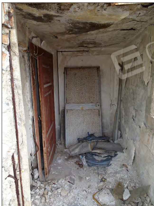
Foto 136: Vista vano tecnico piano copertura
