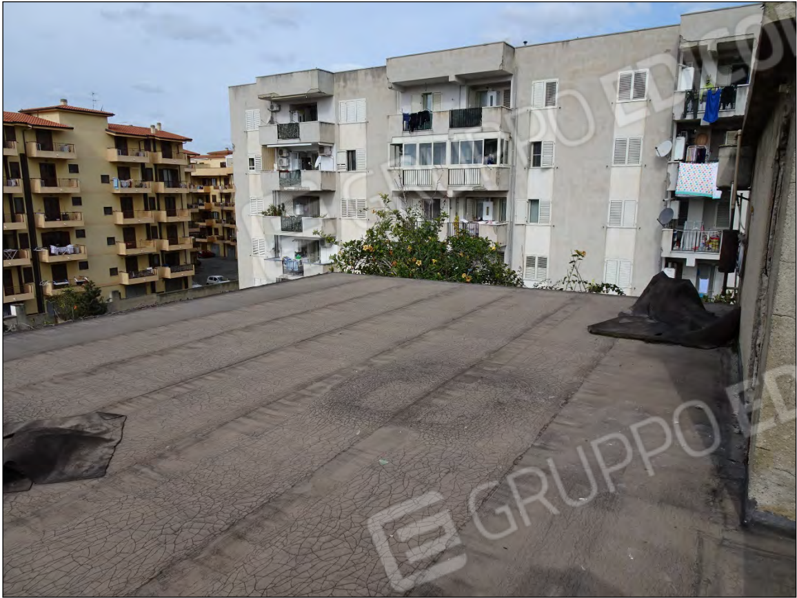
Foto 141: Vista piano copertura
