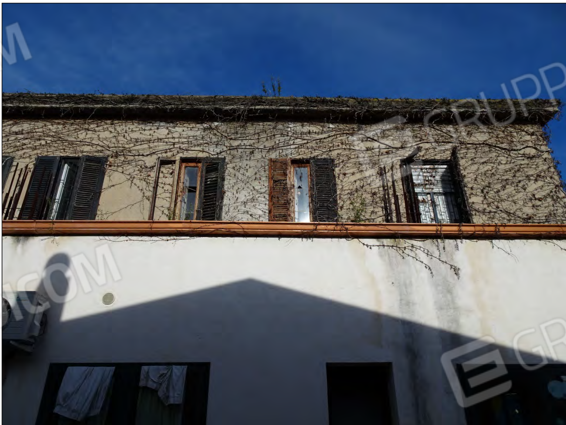
Foto 16: Vista prospetto esterno lato ovest
