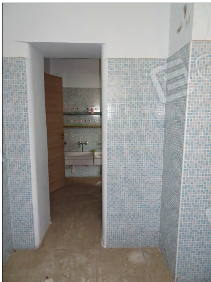
Foto 30: Vista wc 1 immobile piano terra sub 9
