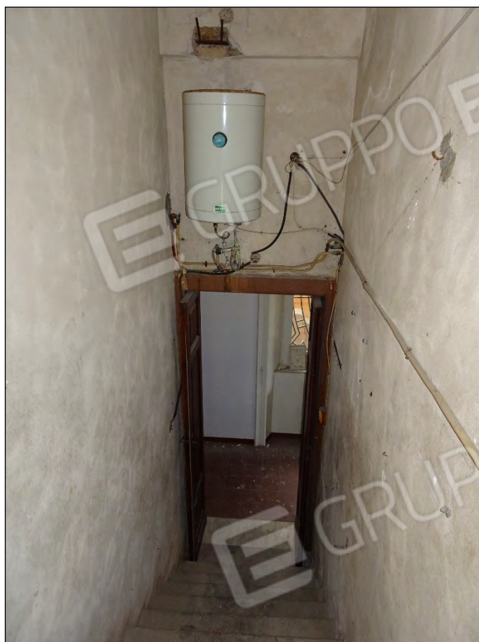
Foto 133: Vista scala di accesso al piano copertura
