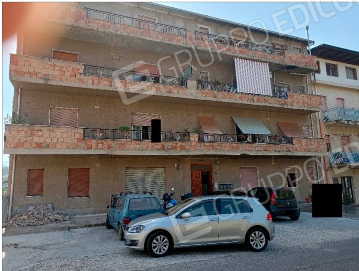
FOTO 1: ESTERNO (FRONTE PRINCIPALE)
