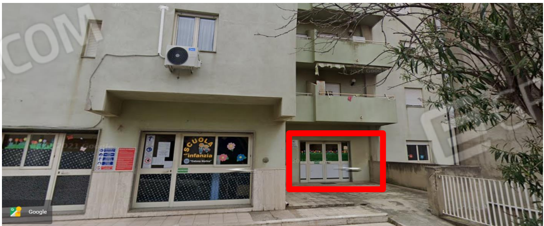
Foto n. 3 – Prospetto secondario. Ingresso su Via Collegiata (Sub. 16)
