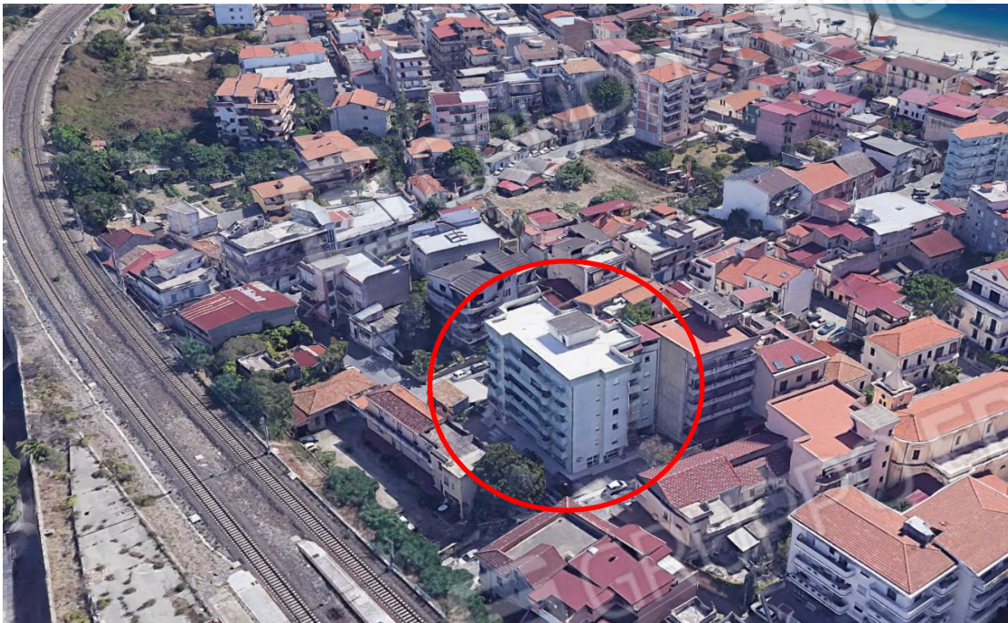
Foto n. 1 – Foto aerea con Individuazione edificio
