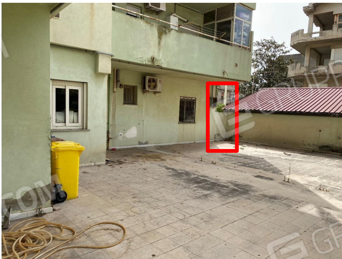
Foto n. 11 – Cortile interno. Muretto di cinta chiude la corte e taglia una parte del sub16
