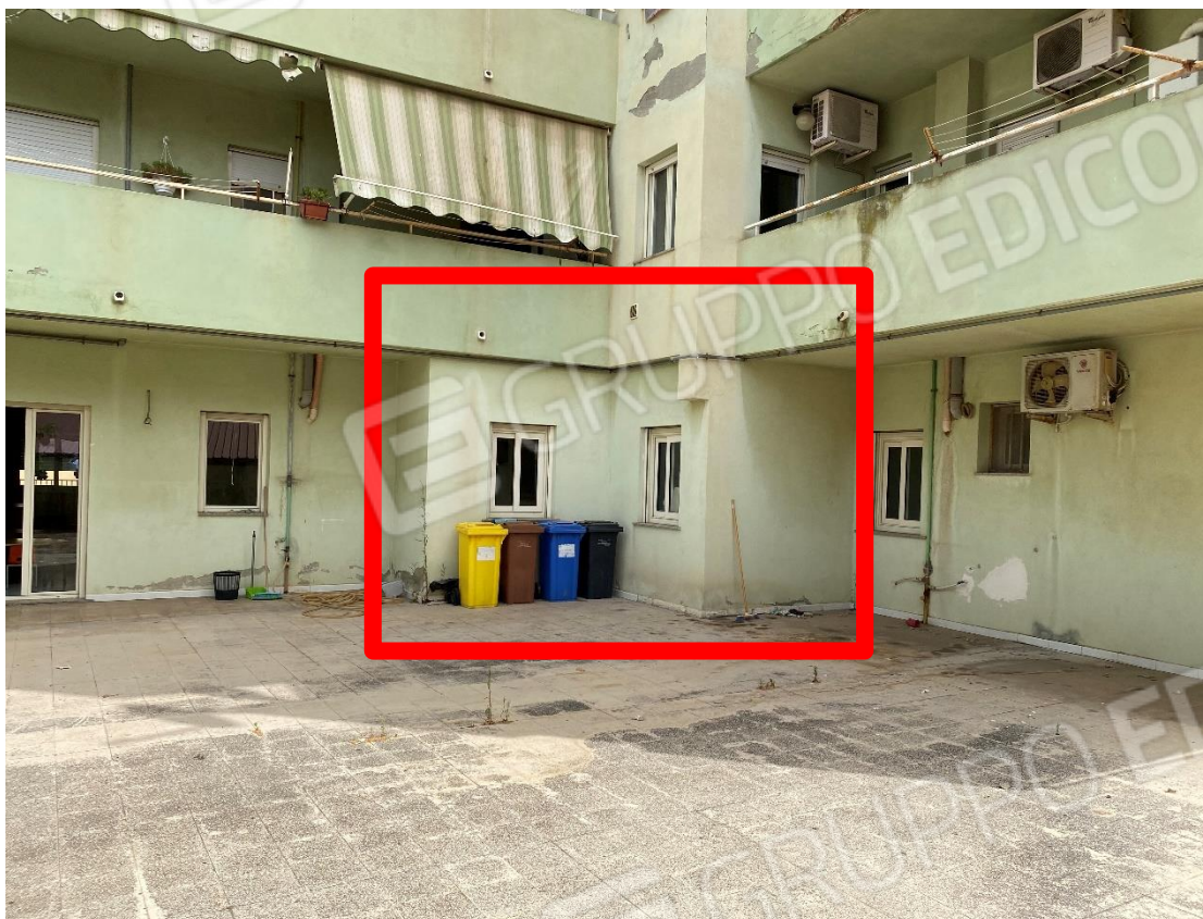
Foto n. 10 – Cortile interno. Idivduazione esterna del vano di collegamento tra I sub
