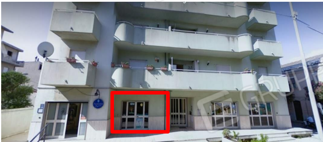
Foto n. 2 – Prospetto principale dell'edificio. Ingresso su Via dei Garibaldini (Sub. 44)
