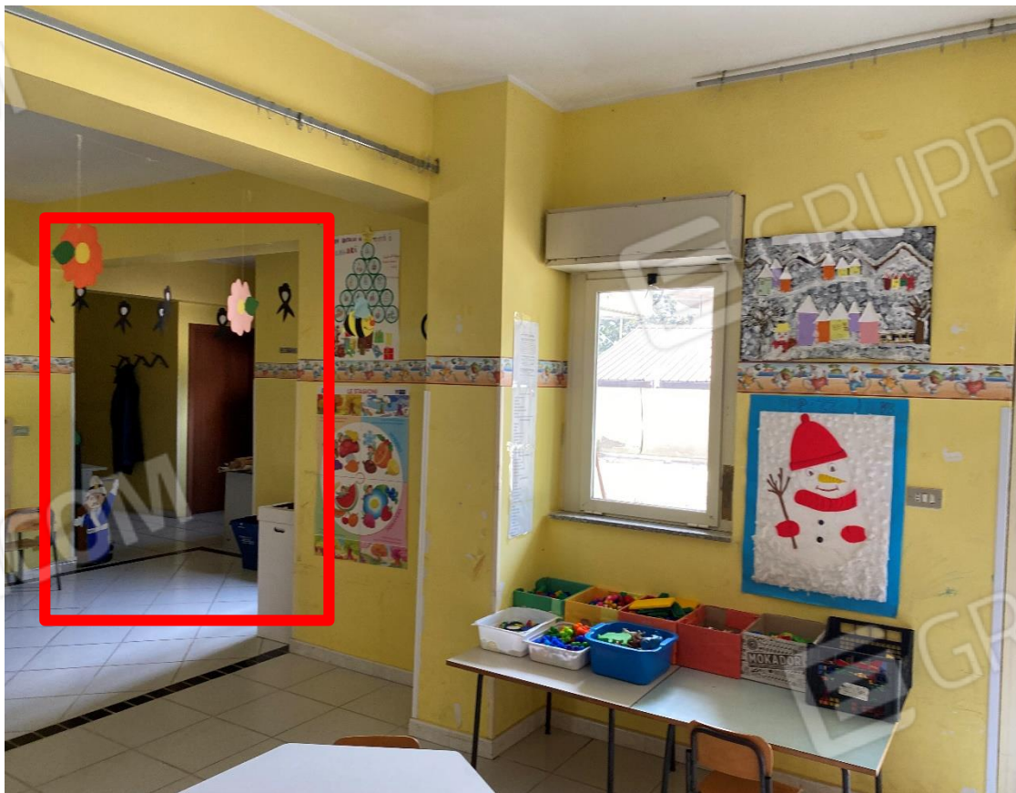
Foto n. 9 – Sub. 16, Vano di raccordo tra I sub 16 e 44.
