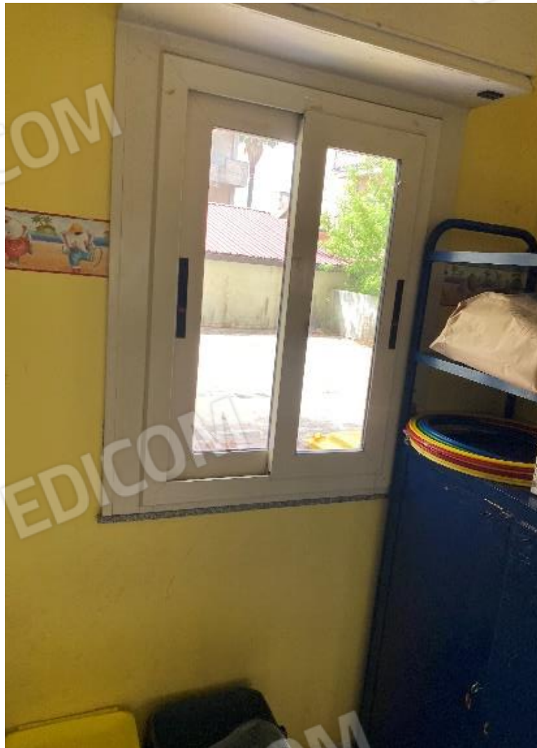
Foto n. 16, n. 17 – Vano di collegamento al sub.44 - ingresso bagno
