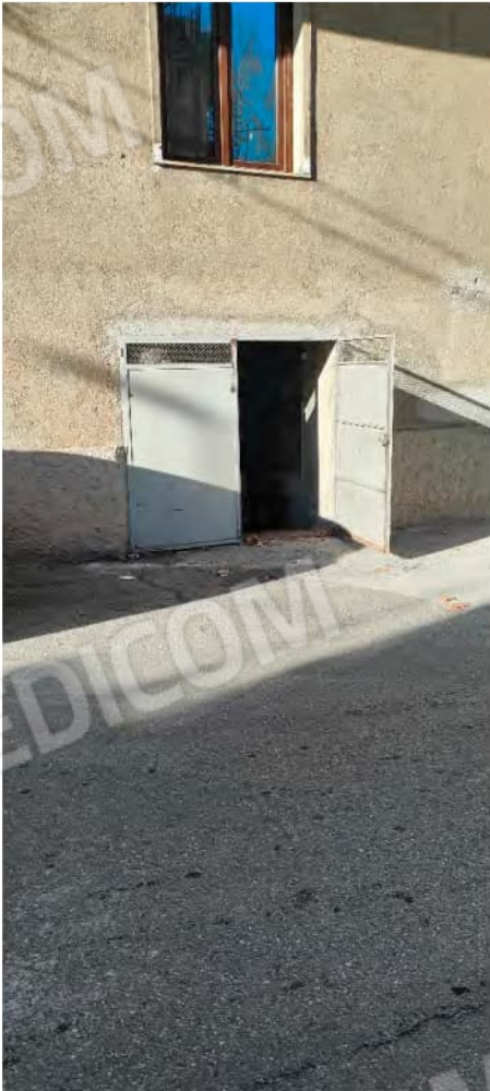
Foto n. 16 accesso garage sub 6
