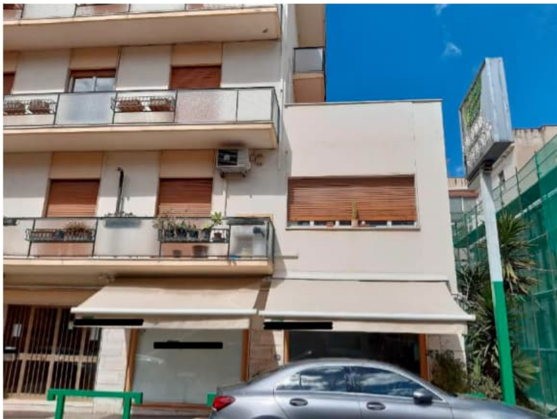
Figura 23: cono ottico 23 - prospetto esterno dell'unità oggetto di pignoramento
