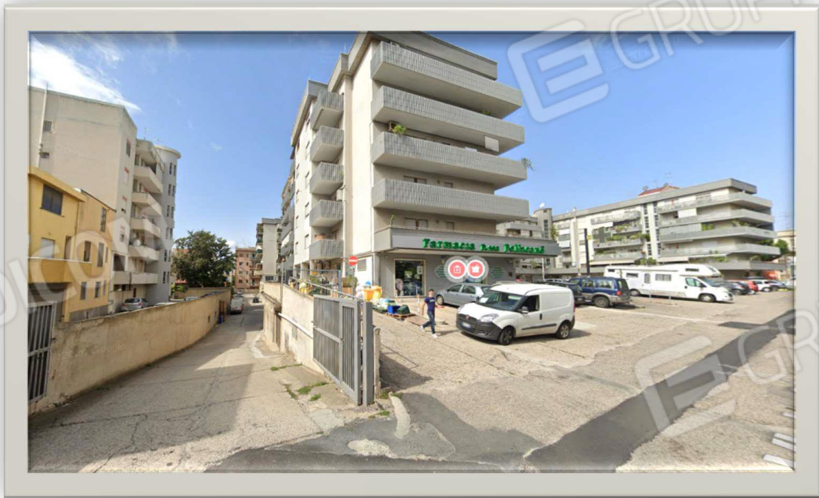
Fig. 5.2.1.1. Edificio "D" - Foto aerea - Foto di strada
