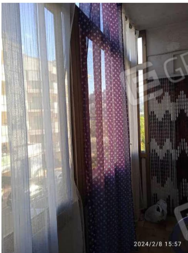
Foto n. 21 La veranda abusiva realizzata dalla chiusura del balcone.
