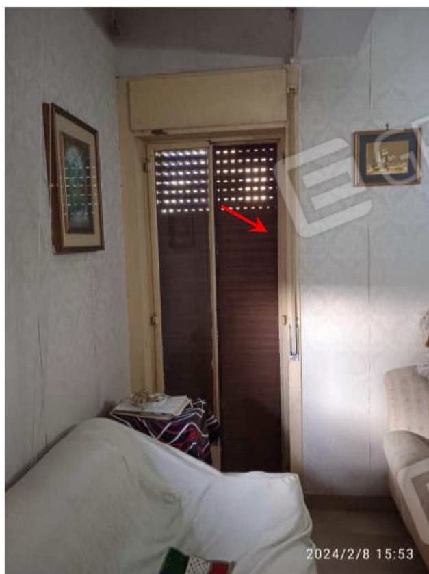
Foto n. 7 L'infisso esterno sprovvisto di anta interna.
