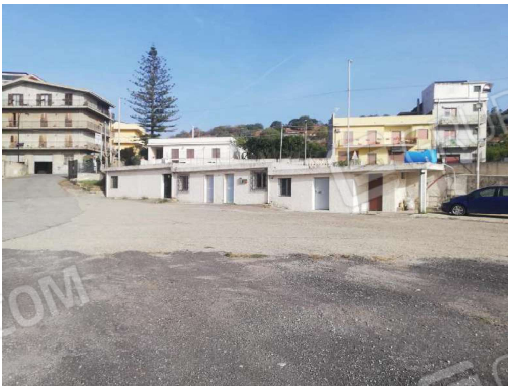
Foto 12. Vista esterna del fabbricato adibito ad ufficio, bene 1 sub 3.
