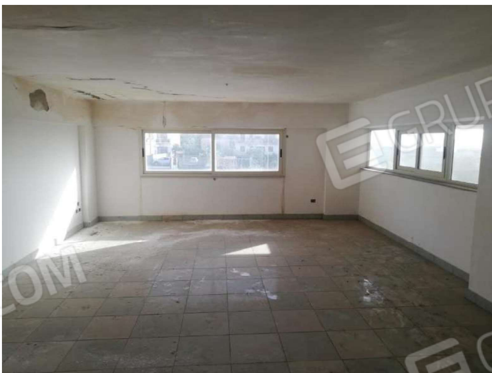
Foto 62. Vista dei locali interni del piano soppalcato: ambiente 7, open space.
