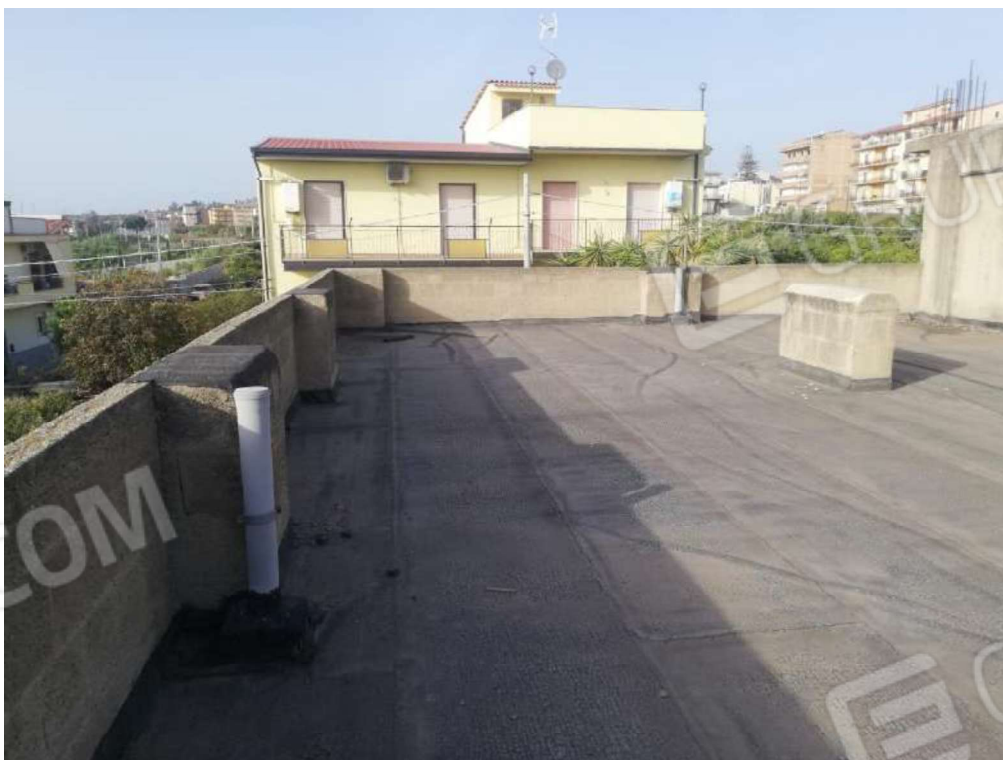
Foto 66. Vista del lastrico solare.
