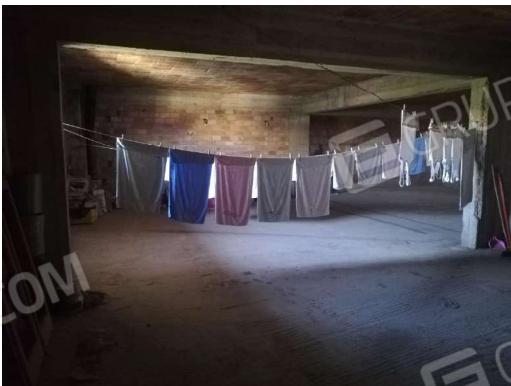
Foto 34. Vista dei locali interni.
