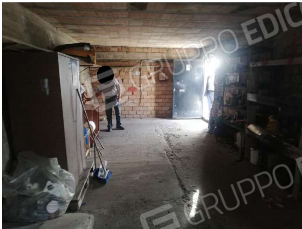
Foto 25. Vista dei locali interni: ambiente 4 adibito ad officina.
