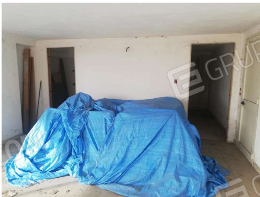
Foto 54. Vista dei locali interni: ambiente 2.
