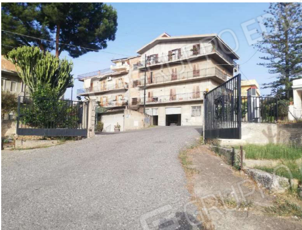
Foto 5. Vista dell'ingresso principale costituito da un cancello carrabile.
