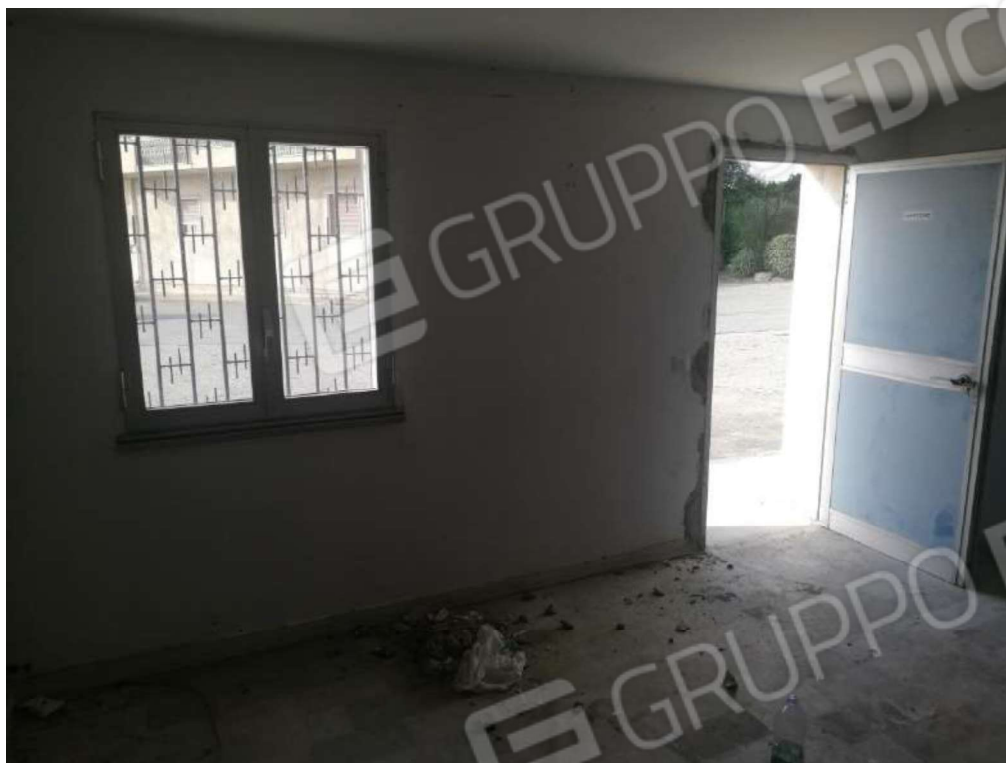
Foto 19. Vista dei locali interni: ambiente 2 adibito ad ufficio.
