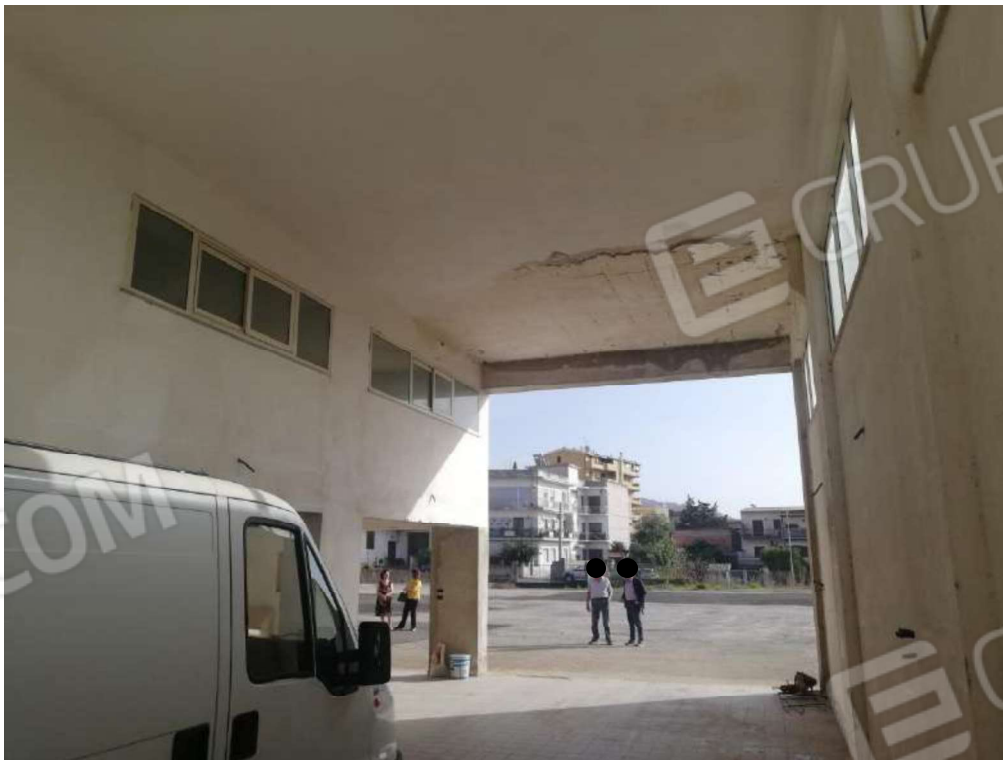
Foto 50. Vista dei locali interni del piano terra: ambiente 1 adibito a parcheggio.
