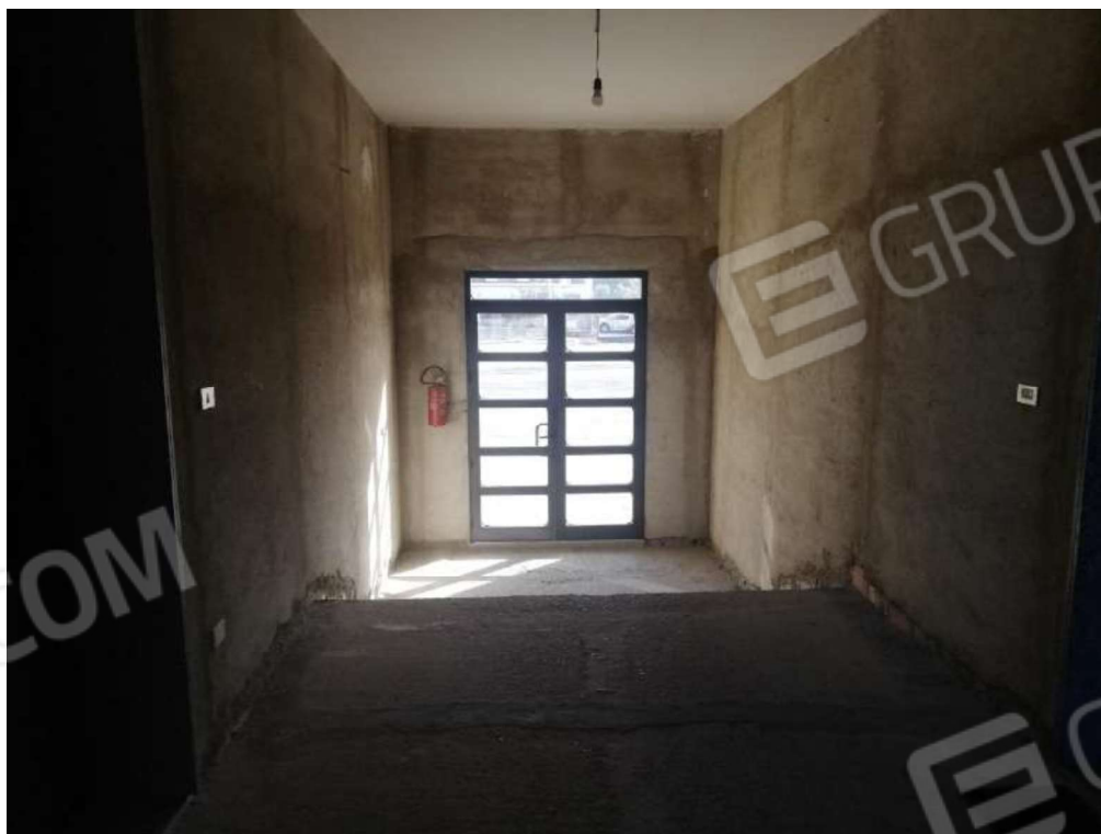
Foto 28. Vista interna dell'ingresso principale e dell'androne condominiale sub 1 B.C.N.C.
