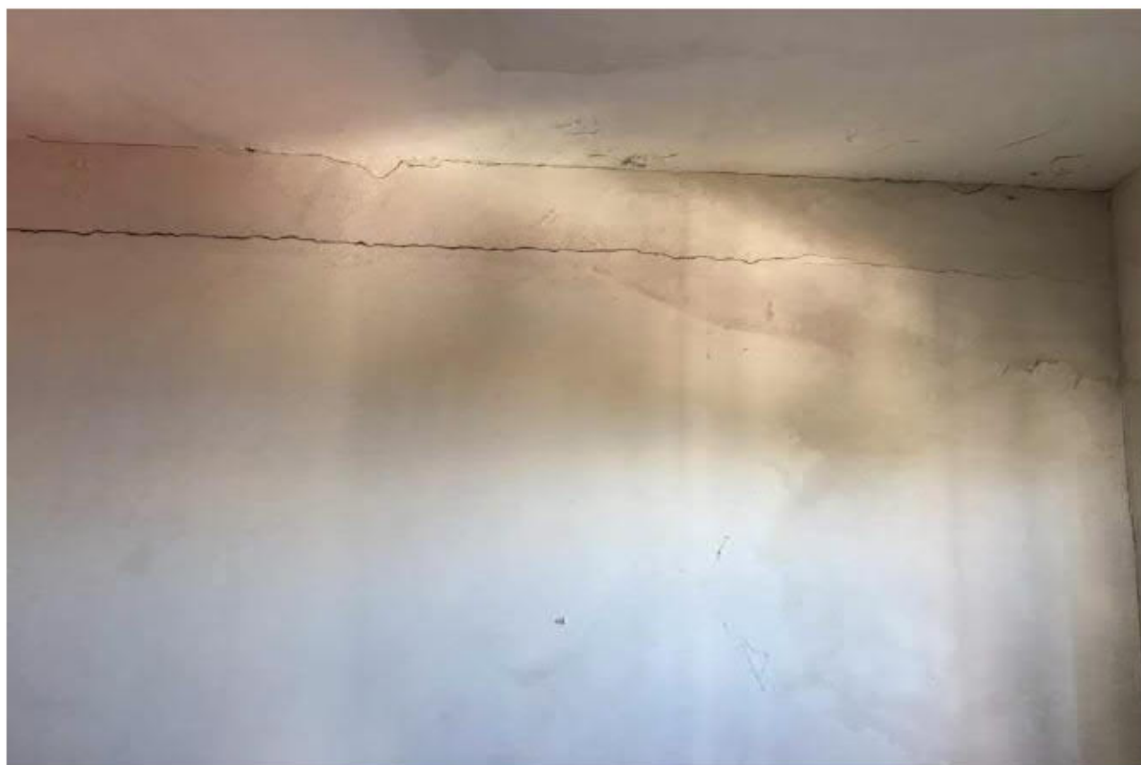
Piano Secondo – Lesioni e Fessurazioni
