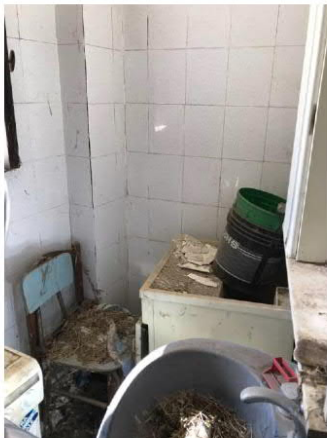
Piano Terra - Bagno
