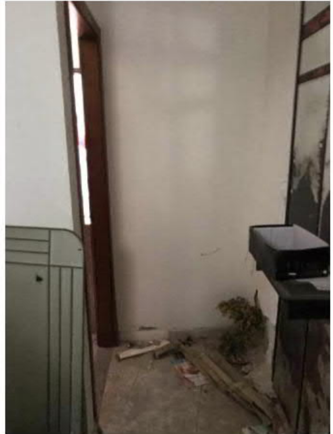
Piano Terra – Ingresso
