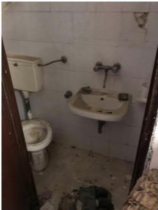
Piano Terra - Bagno
