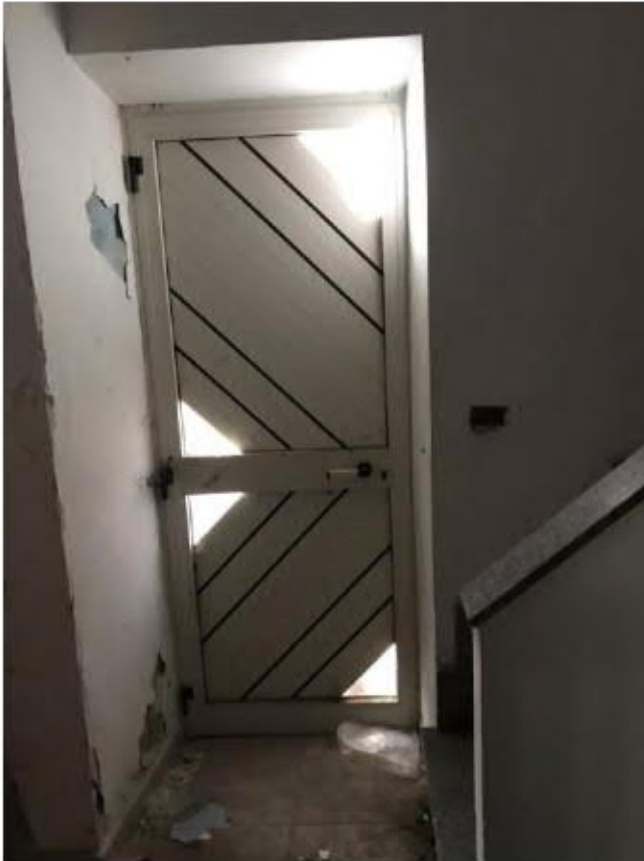
Piano Terra – Portone Ingresso
