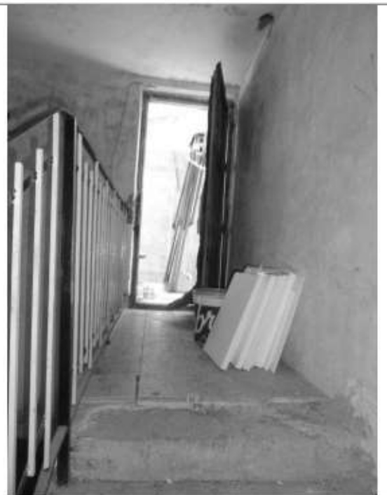
024 – VANO SCALE ACCESSO TERRAZZO
