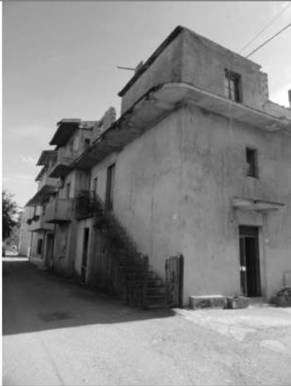
01 – LATO NORD - EST
