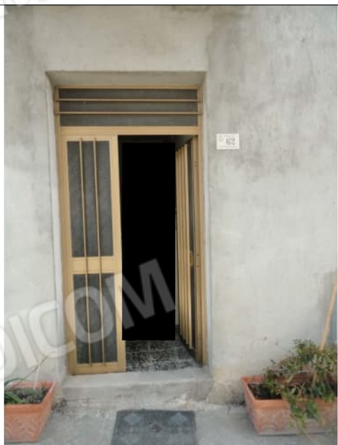
03 – INGRESSO SU VIA G. MORABITO 62
