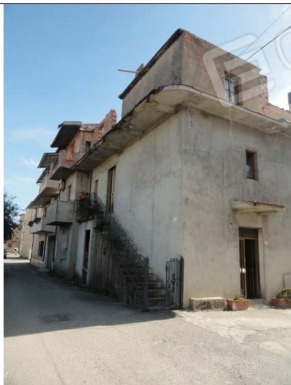
01 – LATO NORD - EST
