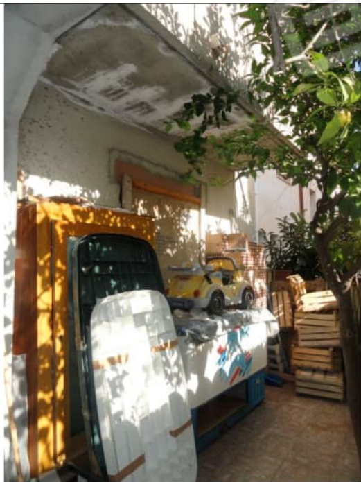
013 – LATO OVEST - AMPLIAMENTO
