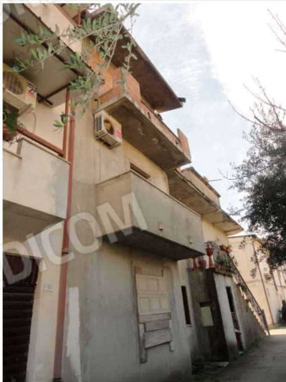
07 – LATO EST - AMPLIAMENTO
