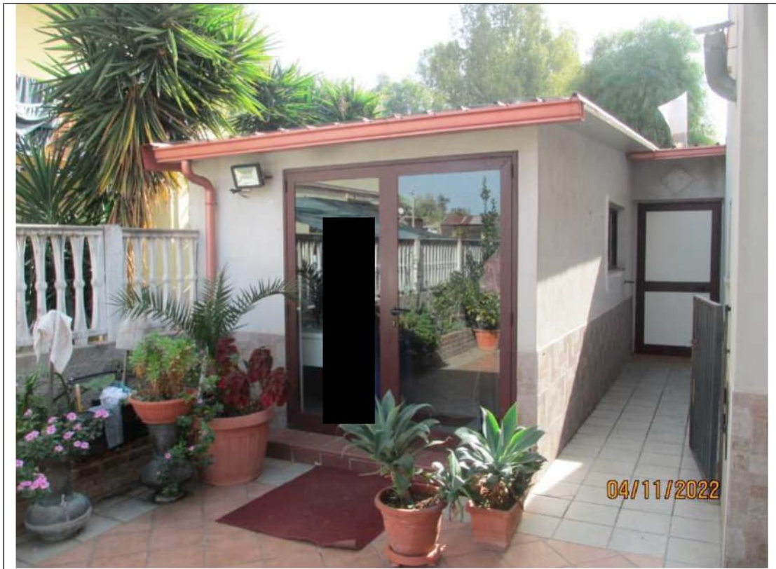
Foto 9. Particolare del manufatto insistente all'interno della corte amessa al fabbricato, adibito a deposito
