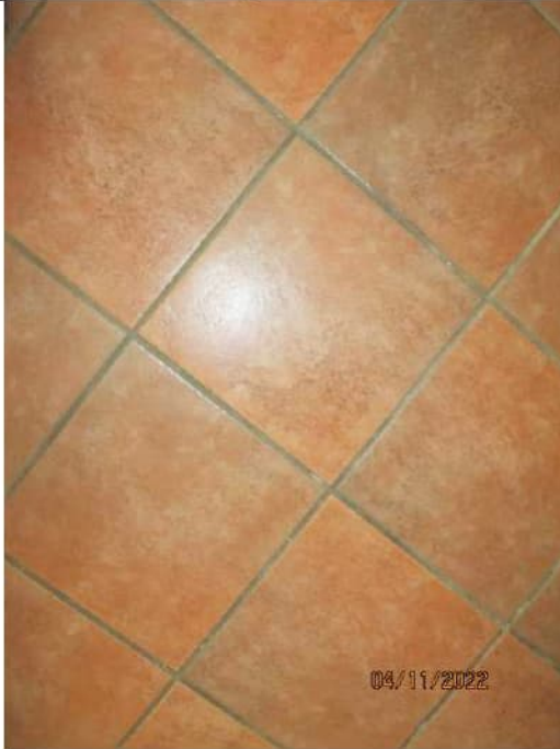
Foto 28. Particolare della tipologia di pavimentazione in gres porcellanato, presente nell'immobile
