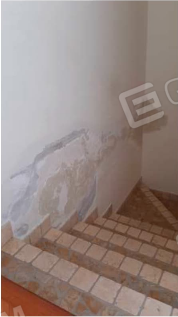
Infiltrazioni e umidità al piano secondo, proveniente dal terrazzo
