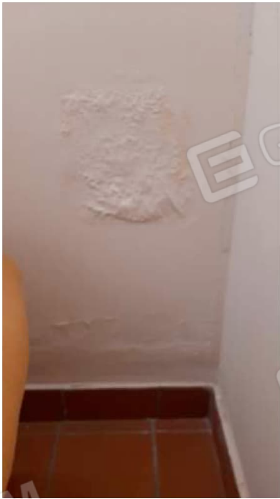
Segni di infiltrazioni al piano Seminterrato
