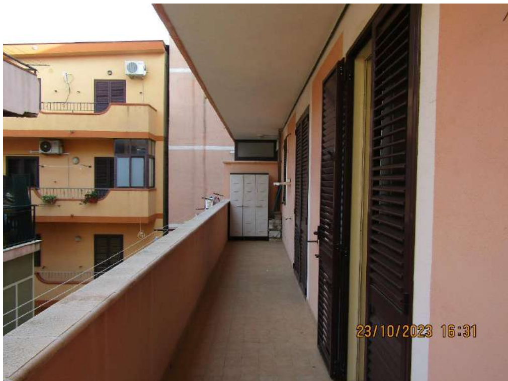
Foto n. 18: balcone lato nord
