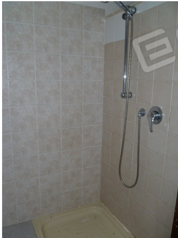
Foto n° 30 Bagno seminterrato bar-pizzeria (sub 2)
