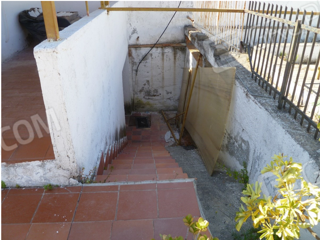
Foto n° 24 Scala accesso seminterrato bar-pizzeria (sub 2)
