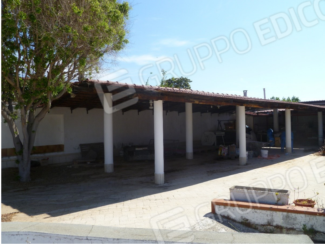
Foto n° 35 Tettoia su corte comune (sub 4)
