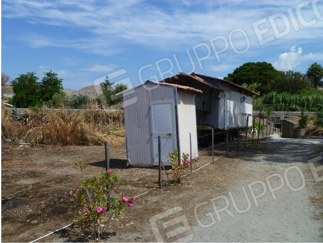
Foto n° 49 Box prefabbricati (particella 511)
