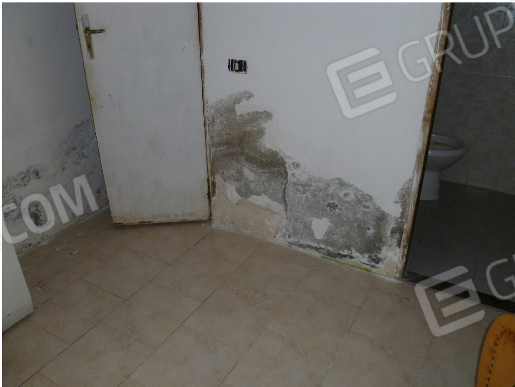
Foto n° 28 Particolare interno seminterrato bar-pizzeria (sub 2)
