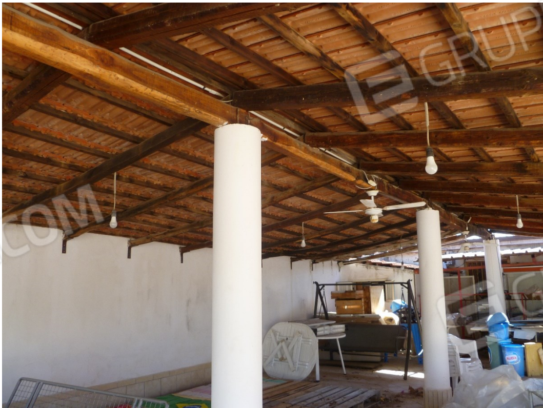
Foto n° 36 Tettoia su corte comune (sub 4)
