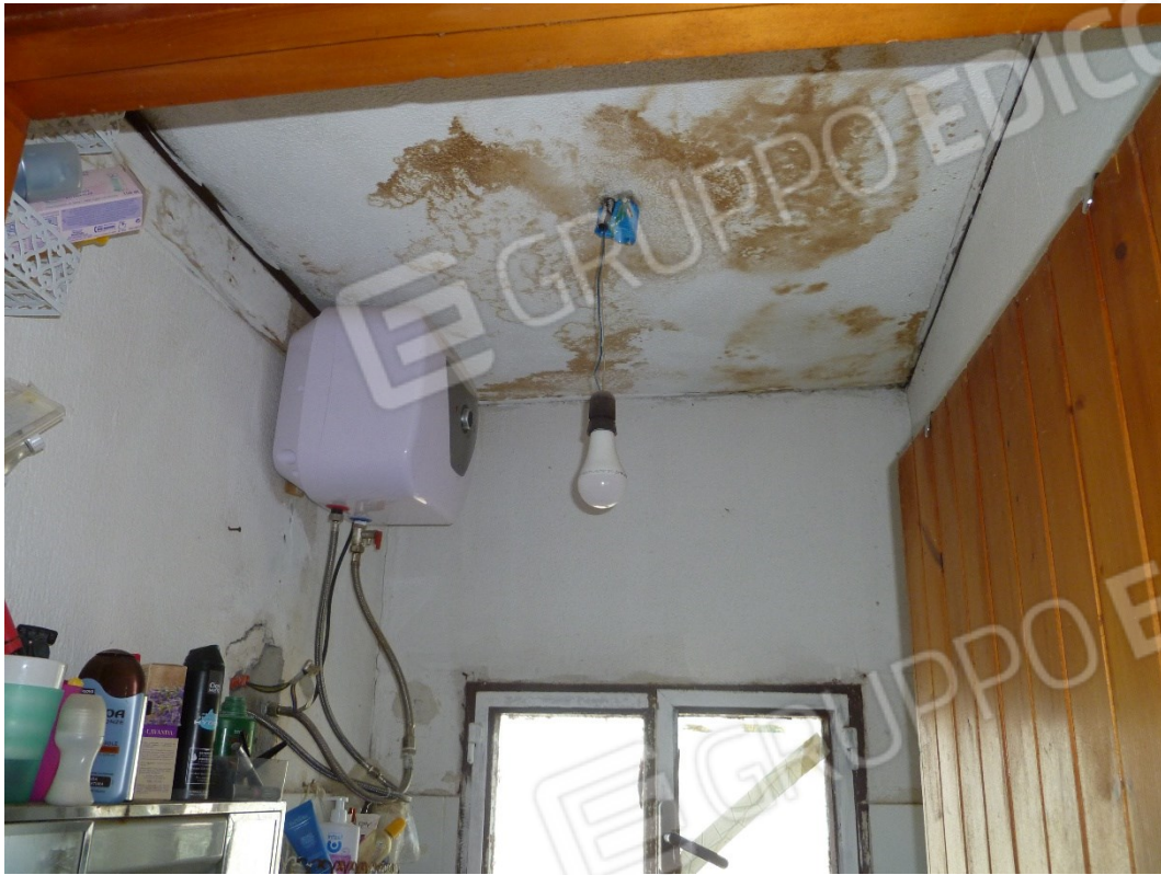
Foto n° 11 Bagno alloggio custode (sub 2)
