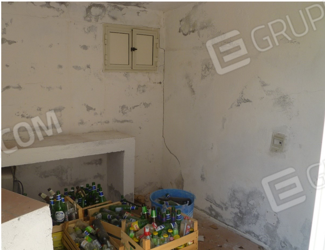
Foto n° 42 Interno manufatto (sub 6)
