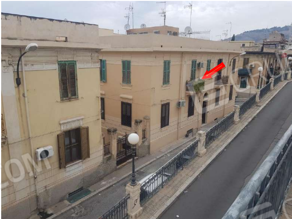
Foto n.1: fabbricato sito in Reggio Calabria via Aschenez n.8, comprendente gli immobili oggetto di pignoramento posti al piano primo e al piano seminterrato
