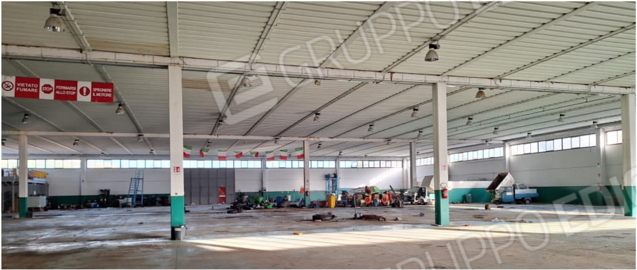
Vista all'interno del Capannone B
