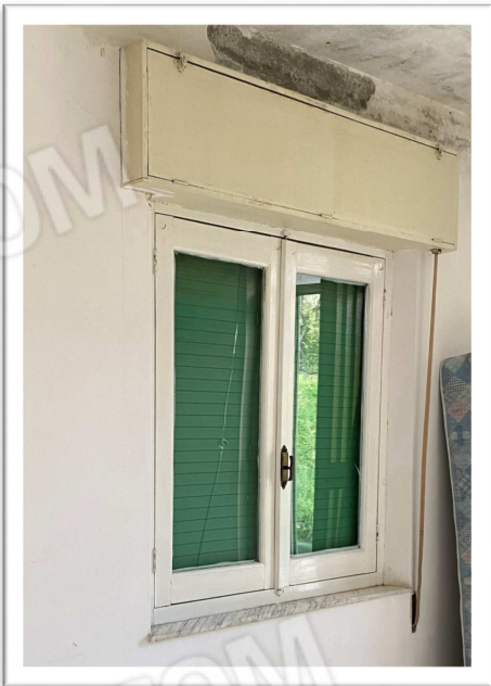
FOTO 27 – INFISSO IN LEGNO CON TAPPARELLA IN PVC
