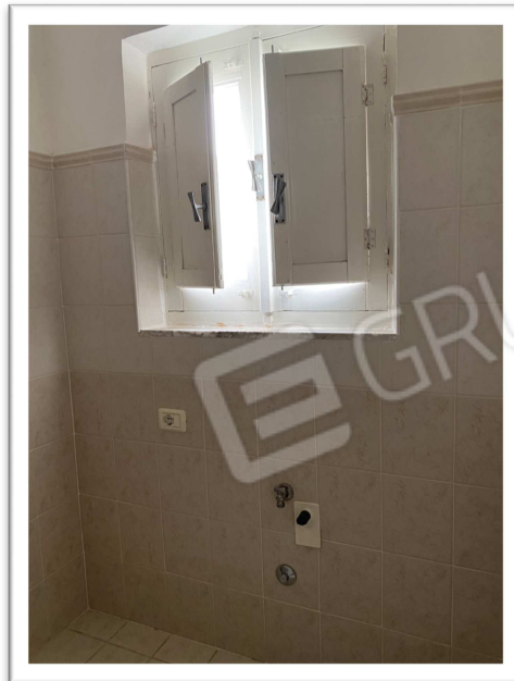
FOTO 28 – INFISSO IN LEGNO CON SCURI IN LEGNO
