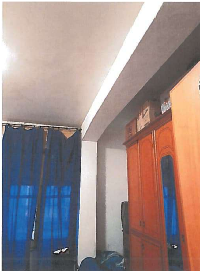
PARTICOLARE ARETRAMENTO TRAMEZZO IN CARTONGESSO
