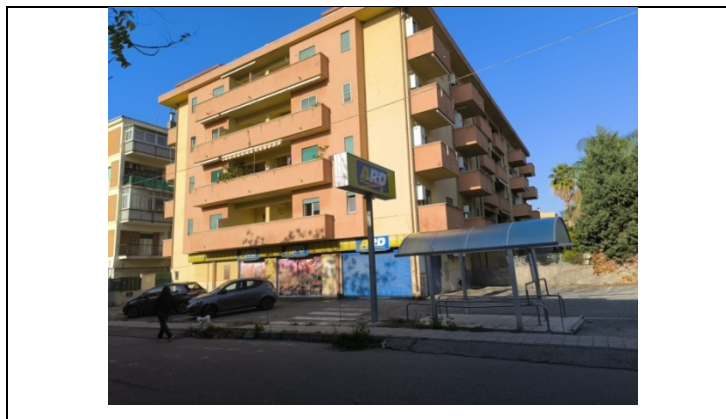
Figura 7- Vista dell'area urbana sub140 –parte (A)
