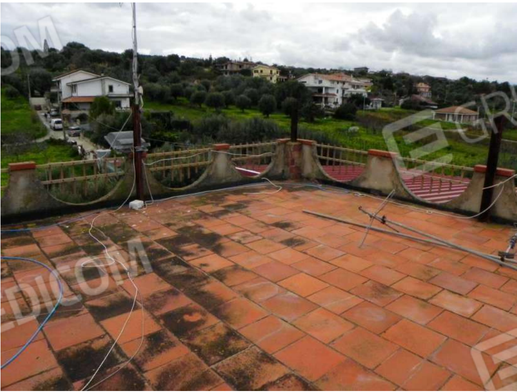
Foto 4 – Lastrico solare a copertura sub 7
