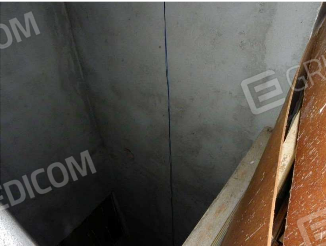
Foto 2 – Vano Ascensore sub 7 (secondo piano)
