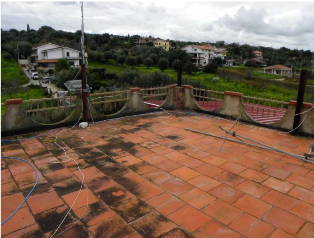
Foto 4 – Lastrico solare a copertura sub 7
