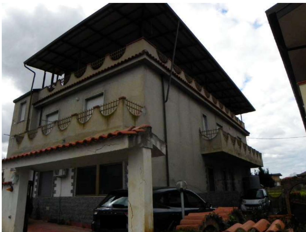
Foto 1 – Unità Immobiliare primo piano lato strada privata (sub3)
