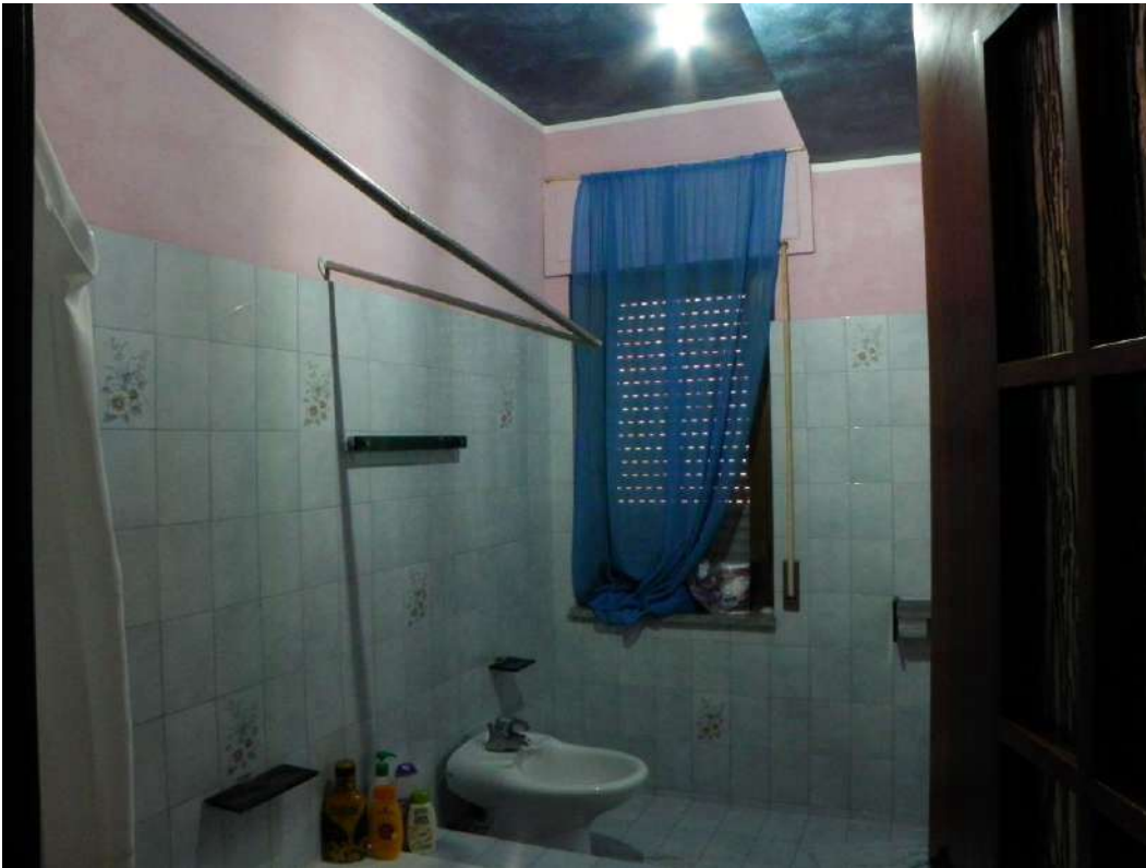
Foto 3 – Servizio Igienico sub 3 (primo piano)
