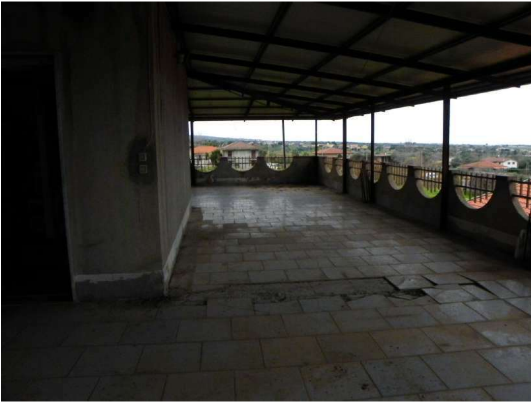
Foto 3 – Lastrico solare sub 7 (terzo piano)
