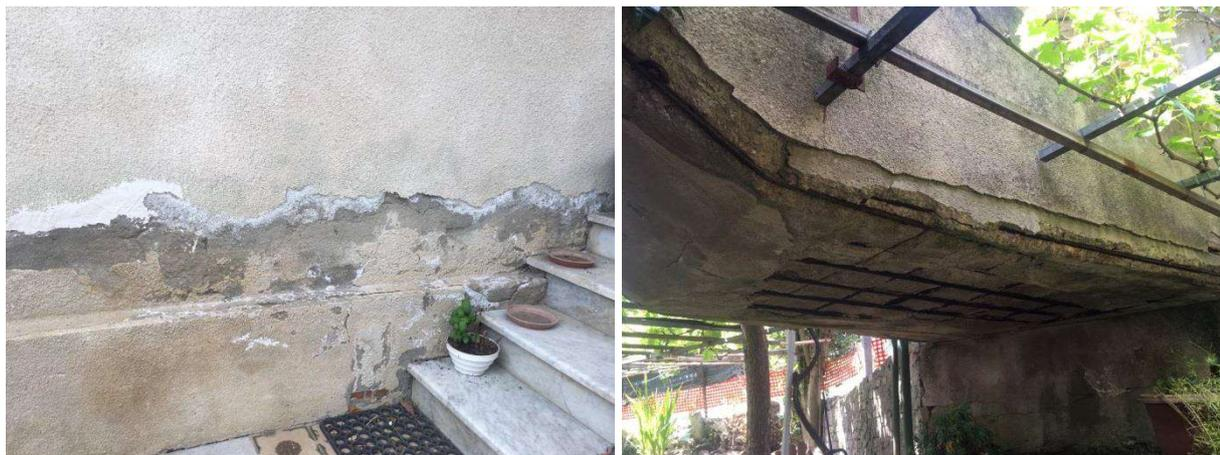
La costruzione ha una struttura portante realizzata in muratura di mattoni pieni e solai in laterocemento, il fabbricato è stato intonacato e rifinito, oggi però presenta segni di degrado dovuti alla vetustà. In diversi punti vi sono distacchi d'intonaco conseguenti in taluni casi al principio d'ossidazione dei ferri d'armatura, tale problematica è evidentissima negli sporti e nei balconi.
