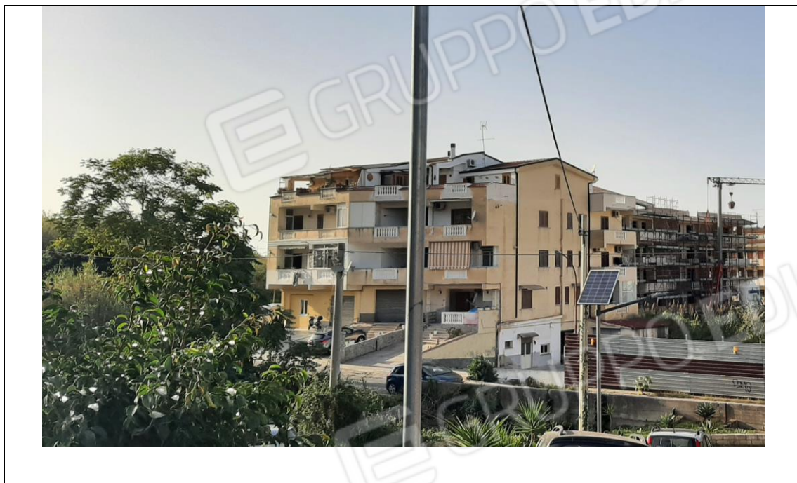
Foto n. 1: Vista da Viale don Mottola
