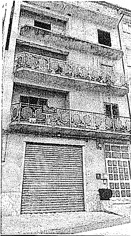
Figura 23 prospetto immobile Via Carmine
