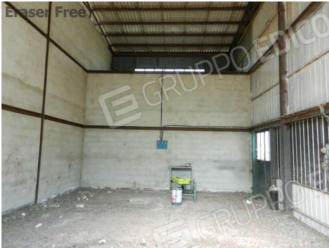
Foto 13 deposito fg. 18 - p.lla 201 NTC Fg. 7 p.lla 1121
