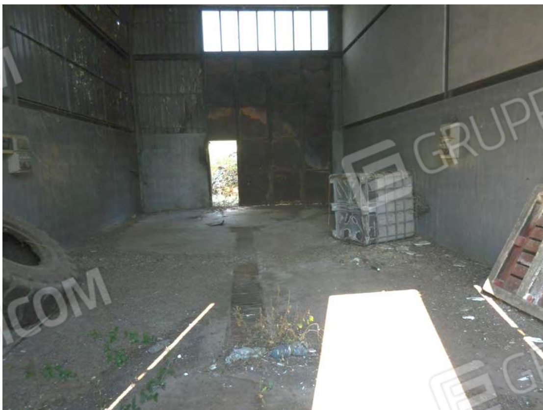
Foto 14 deposito fg. 18 - p.lla 201 NTC Fg. 7 p.lla 1121
