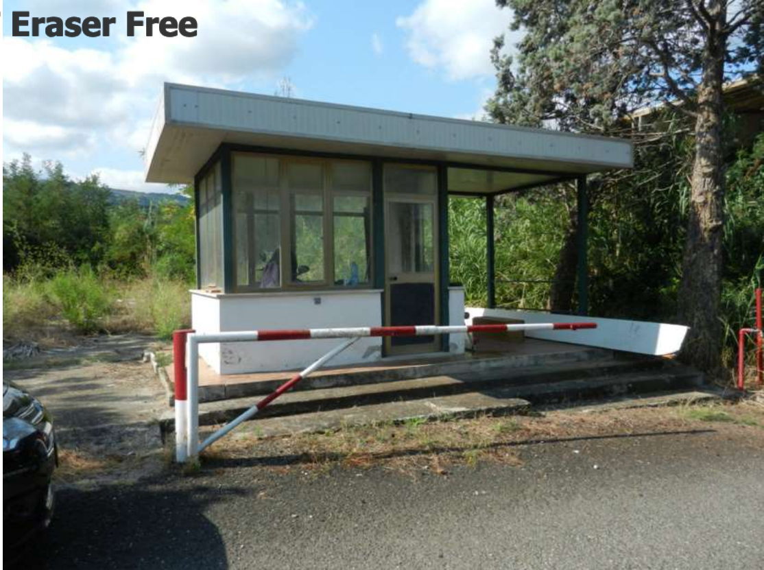
Foto 3 N.C.T. Fg. 7 p.lla 1122
