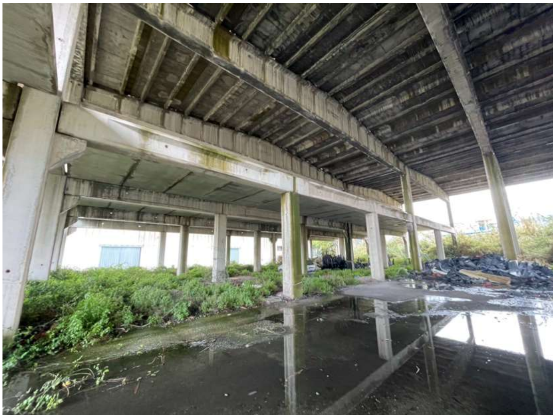
Foto 10 N.C.T. Fg. 7 p.lla 1123
