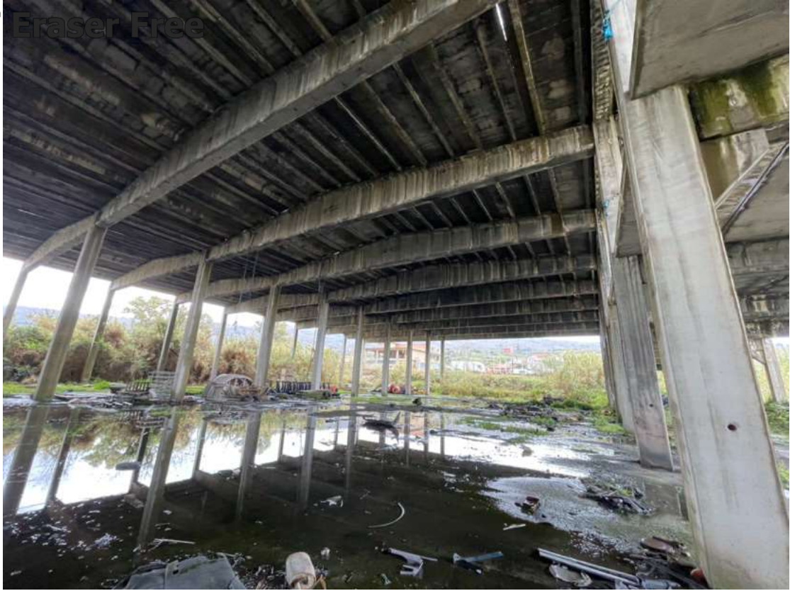
Foto 5 N.C.T. Fg. 7 p.lla 1123
