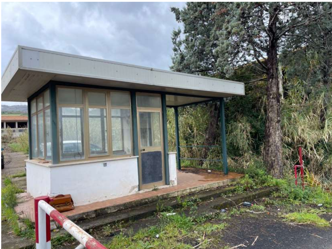
Foto 2 N.C.T. Fg. 7 p.lla 1122
