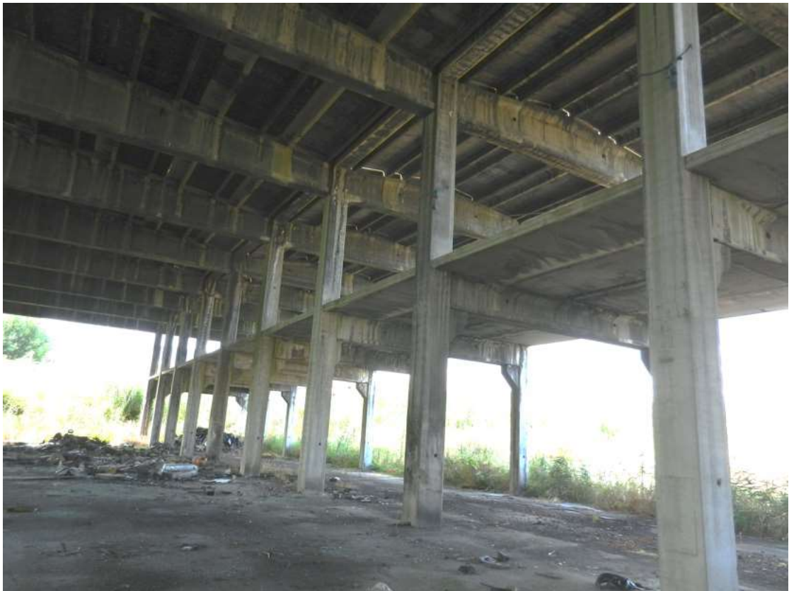
Foto 6 N.C.T. Fg. 7 p.lla 1123
