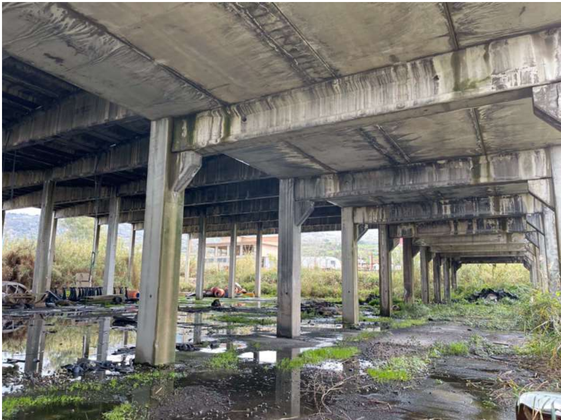
Foto 8 N.C.T. Fg. 7 p.lla 1123
