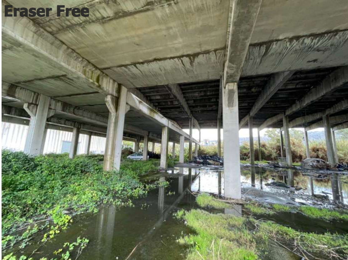
Foto 9 N.C.T. Fg. 7 p.lla 1123
