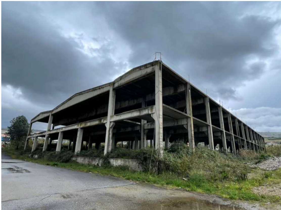
Foto 4 N.C.T. Fg. 7 p.lla 1123
