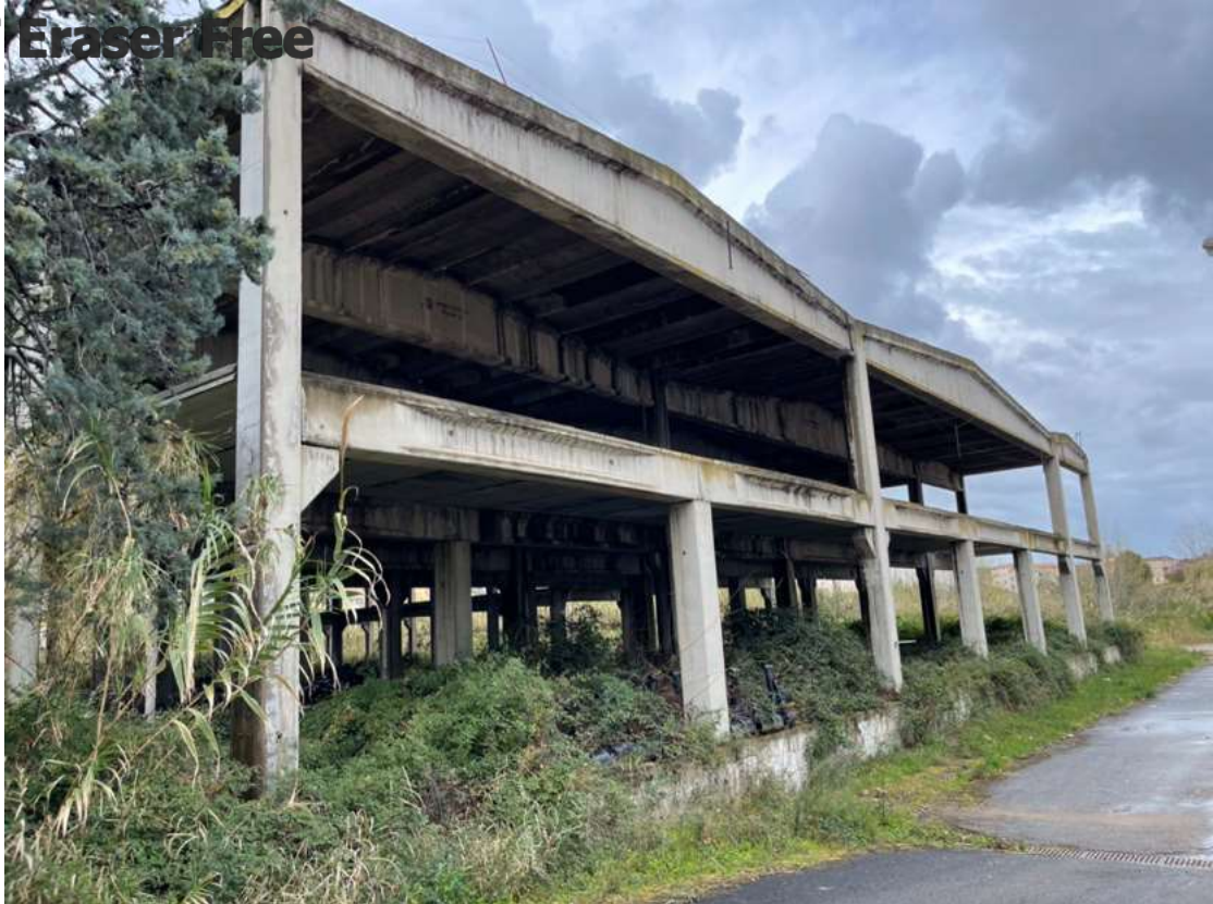
Foto 7 N.C.T. Fg. 7 p.lla 1123
