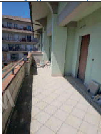
foto 57. Dettaglio vista corte da sub. 11 part. 1096
