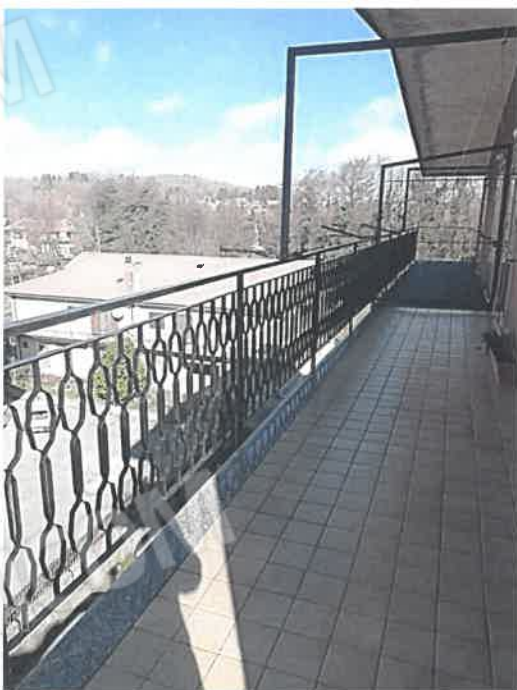
foto n. 21 - vista balcone - fronte ovest
