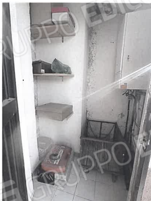
foto n. 20 - veduta vano caldaia
