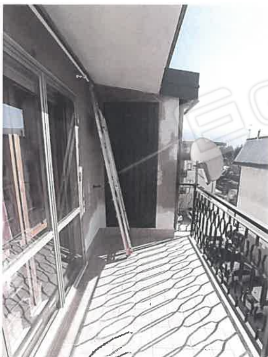
foto n. 19 - vista balcone - fronte sud
