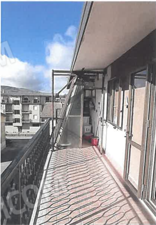
foto n. 17 - vista balcone - fronte sud
