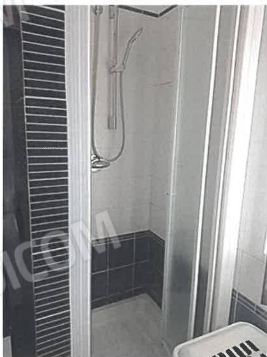
foto n. 13 - particolare box doccia
