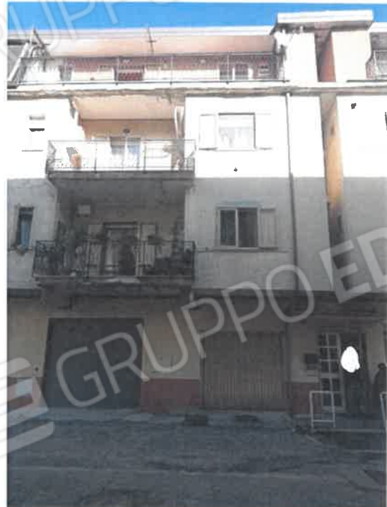
foto n. 2 -prospetto ingresso Località La Prisa - fronte sud
