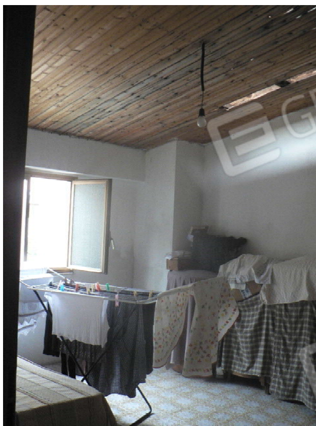
Foto 18 – Vista Deposito, zona Notte
