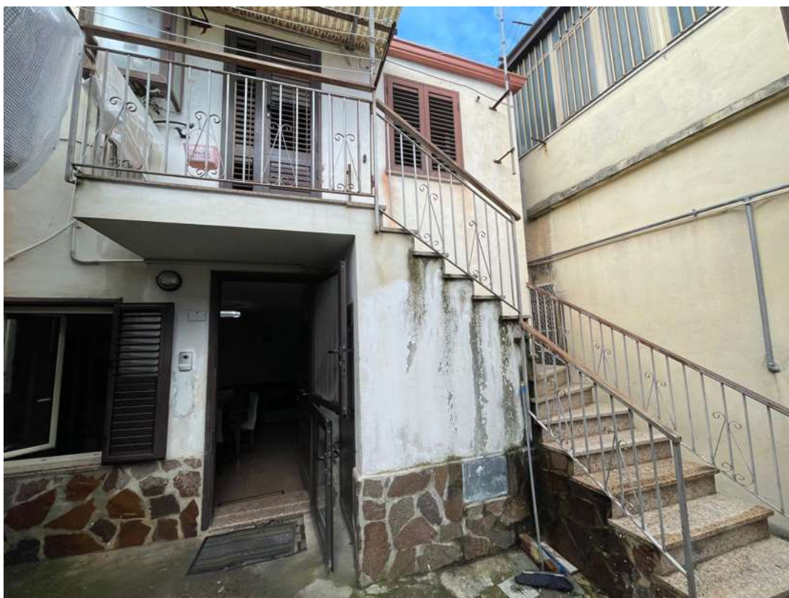
Foto 2 N.C.E.U. Maierato Fg. 34 p.lla 448 sub 1 – p.lla 449 sub 1
