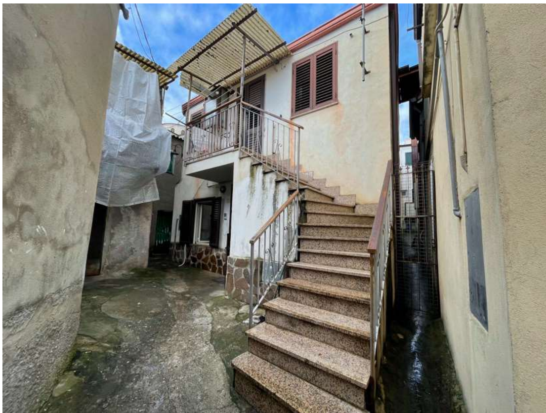
Foto 1 N.C.E.U. Maierato Fg. 34 p.lla 448 sub 1 – p.lla 449 sub 1
