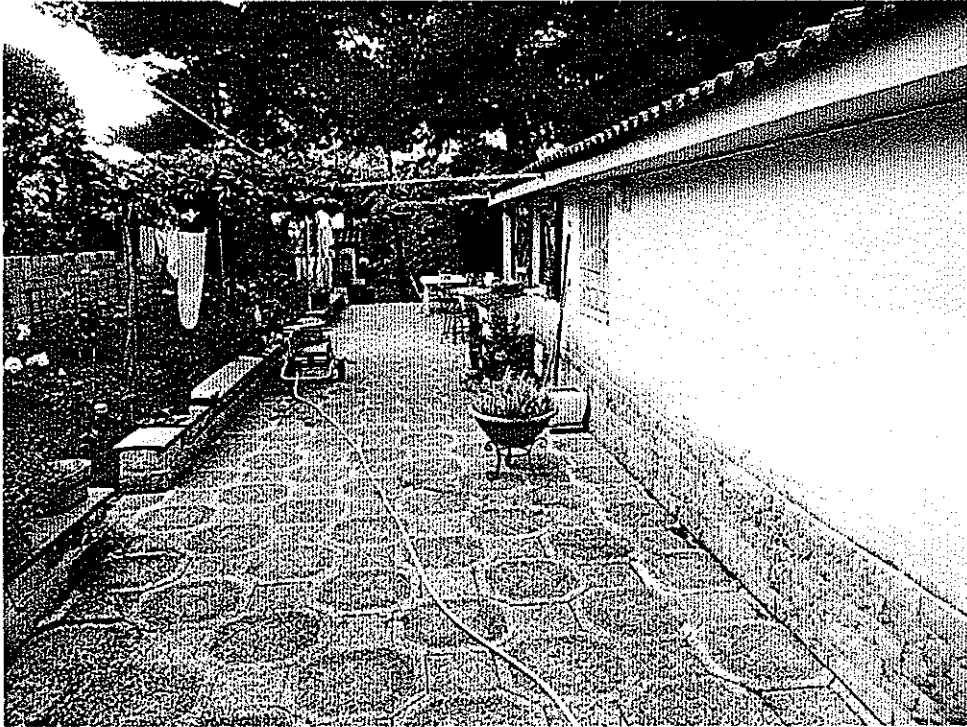
Foto 28 fg. 23 p.lla 659 Pavimentazione Esterna
