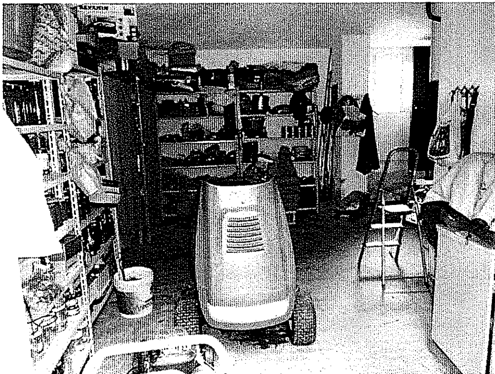
Foto 34 fg. 23 p.lla 659 Locale Caldaia
