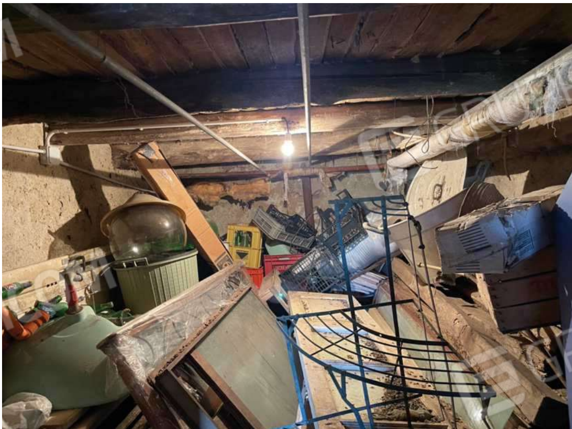
Foto 12 N.C.E.U. Sant'Onofrio fg. 6 - p.lla 724 sub 2 cortile (seminterrato)
