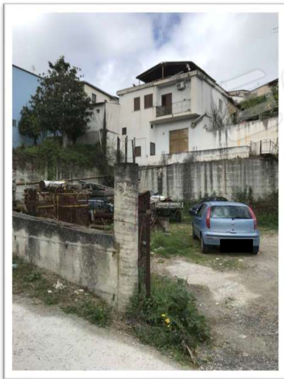
Foto n.14: Appartamento per civile abitazione sito in Piazzetta Sant'Anna di cui al Lotto 3
