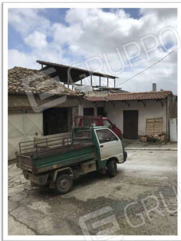
Foto n.13: Appartamento per civile abitazione sito in Piazzetta Sant'Anna di cui al Lotto 3
