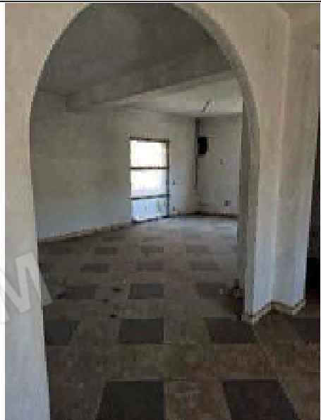
foto 33. Dettaglio appartamento sub. 11 part. 1096
