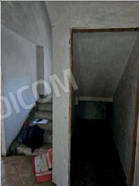
foto 41. Dettaglio appartamento sub. 11 part. 1096
