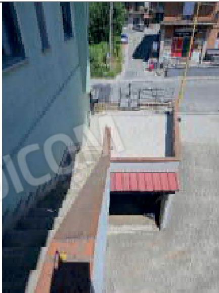
foto 59. Dettaglio rampa sub. 11 part. 1096
