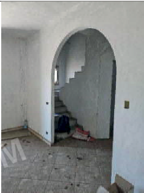
foto 39. Dettaglio appartamento sub. 11 part. 1096
