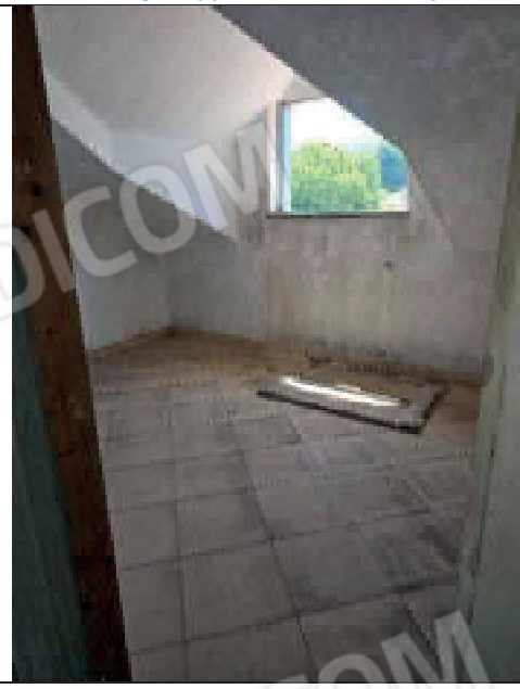
foto 47. Dettaglio appartamento sub. 11 part. 1096
