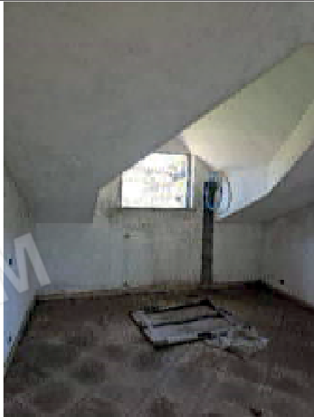
foto 51. Dettaglio appartamento sub. 11 part. 1096
