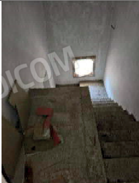
foto 53. Dettaglio appartamento sub. 11 part. 1096
