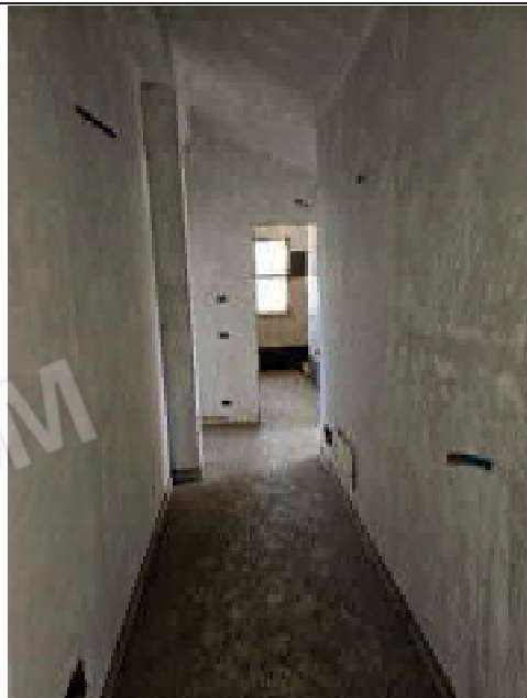
foto 45. Dettaglio appartamento sub. 11 part. 1096
