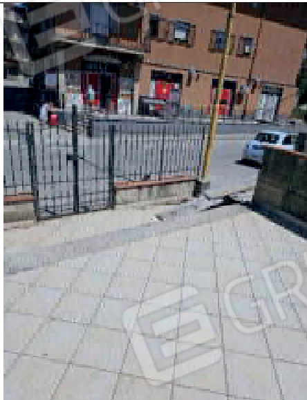
foto 60. Dettaglio rampa sub. 11 part. 1096
