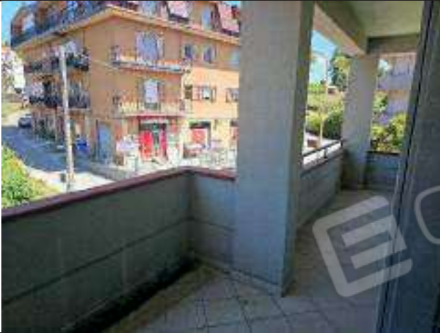
foto 37. Dettaglio appartamento sub. 11 part. 1096
