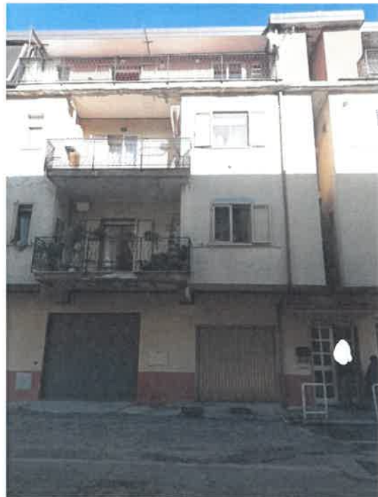
foto n. 2 -prospetto ingresso Località La Prisa - fronte sud
