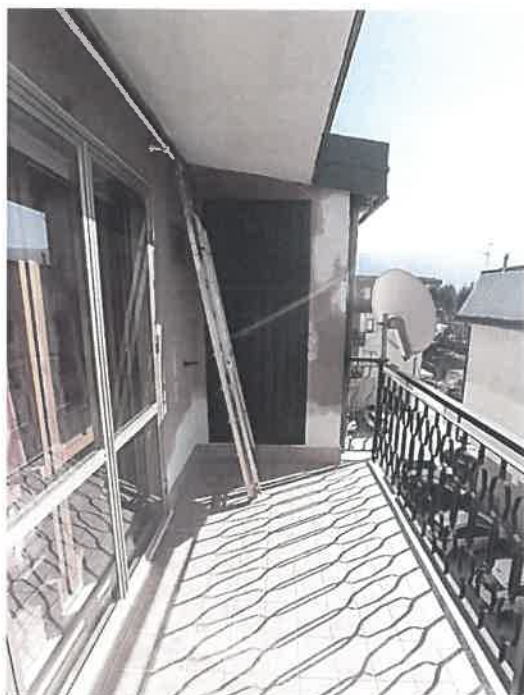
foto n. 19 - vista balcone - fronte sud
