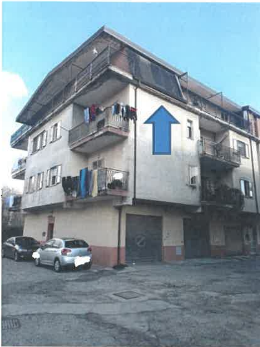
foto n. 1 - prospetto Località La Prisa – fronte sud-ovest
