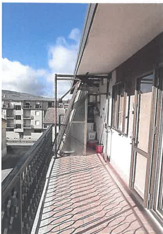
foto n. 17 - vista balcone - fronte sud
