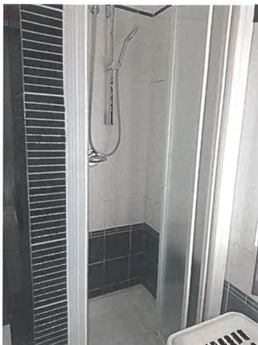
foto n. 13 - particolare box doccia
