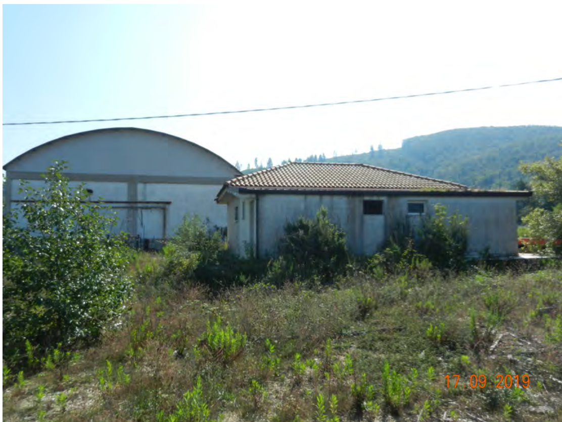
Foto 15 capannone e uffici - servizi fg. 10 - p.lle 467-468
