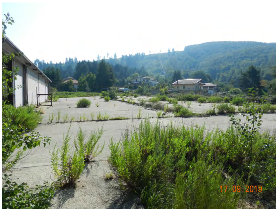
Foto 1 corte - area esterna fg. 10 - p.lla 466
