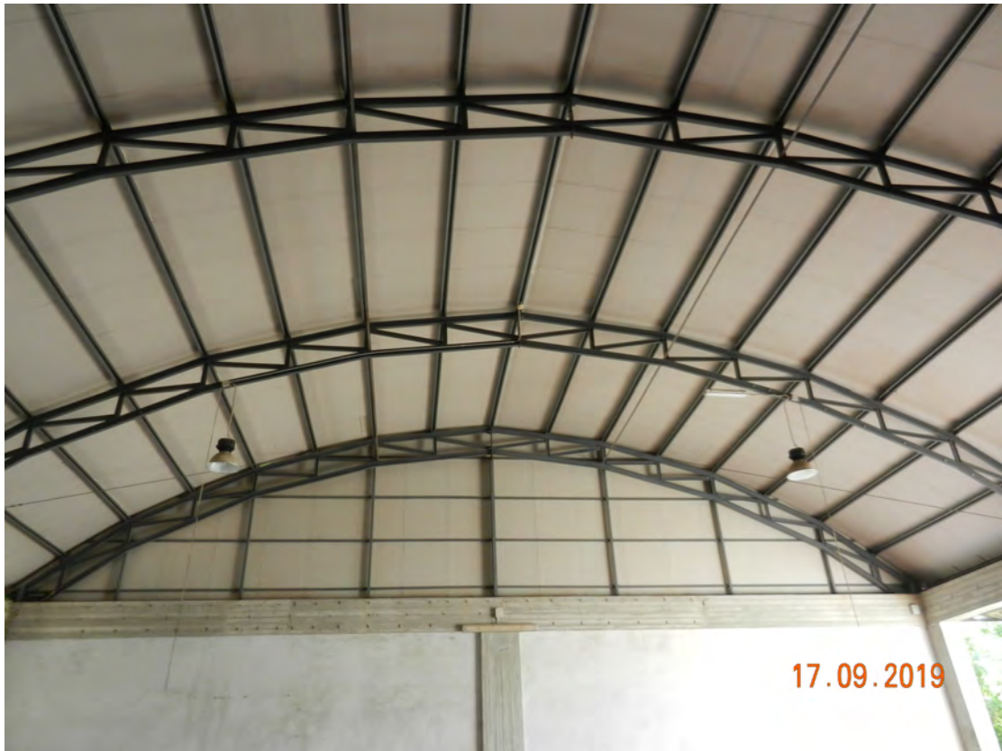
Foto 14 particolare struttura in ferro copertura fg. 10 - p.lla 467
