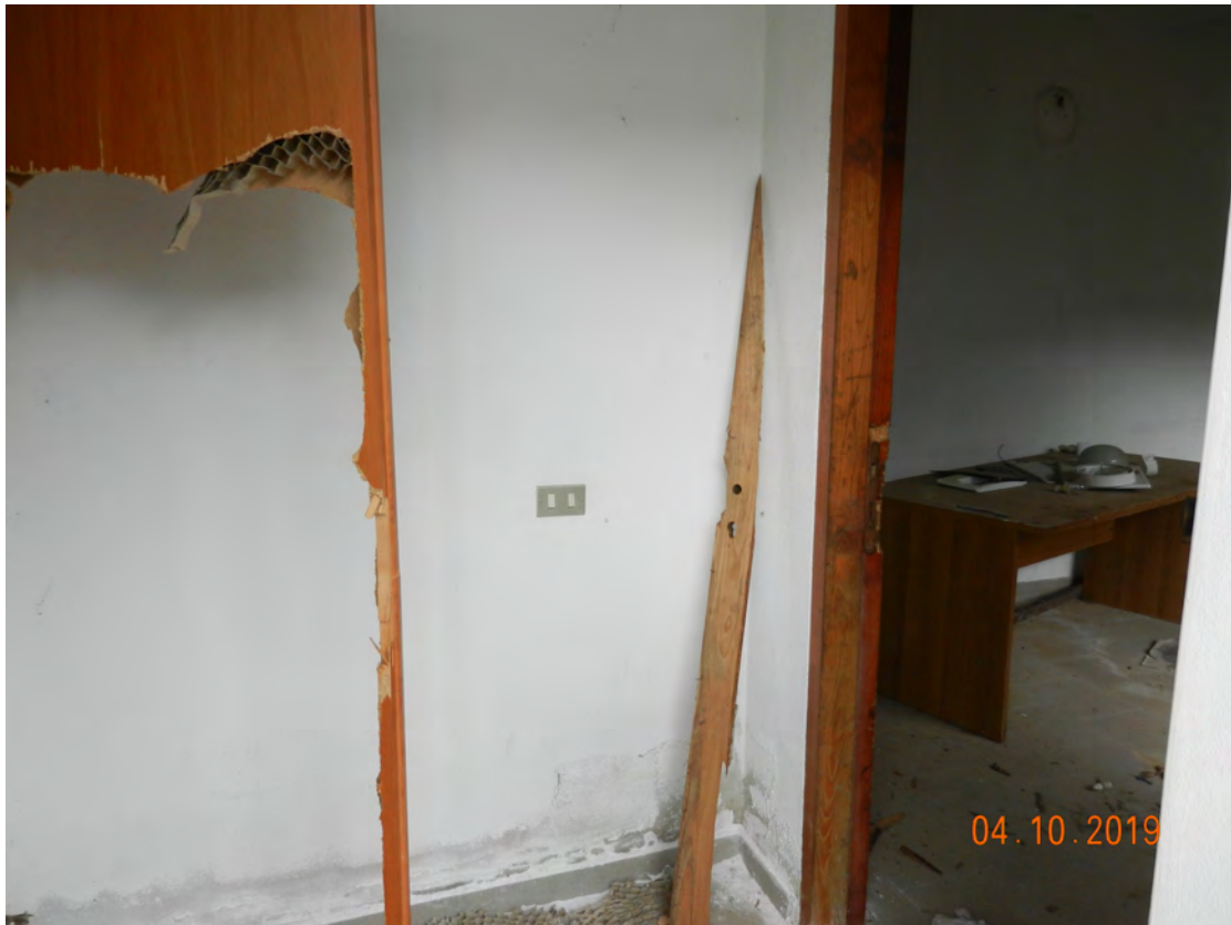
Foto 20 uffici – ingresso fg. 10 - p.lla 467
