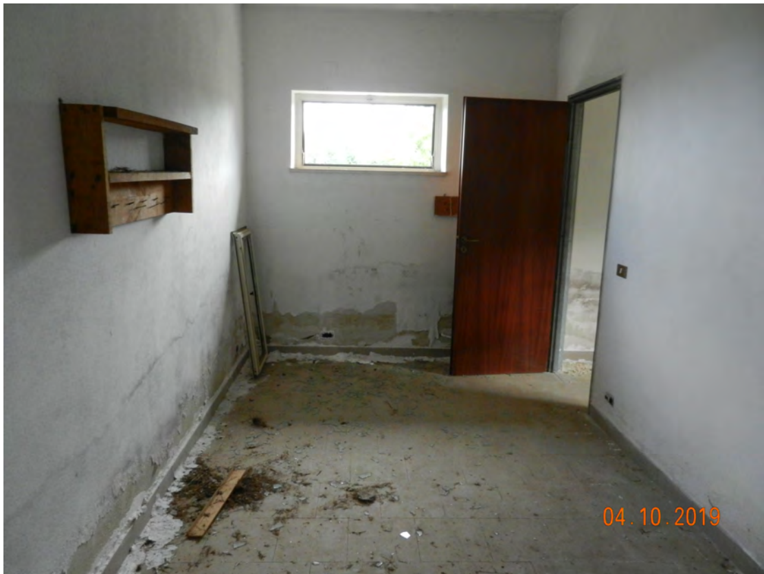
Foto 21 ambiente ripostiglio fg. 10 - p.lla 467
