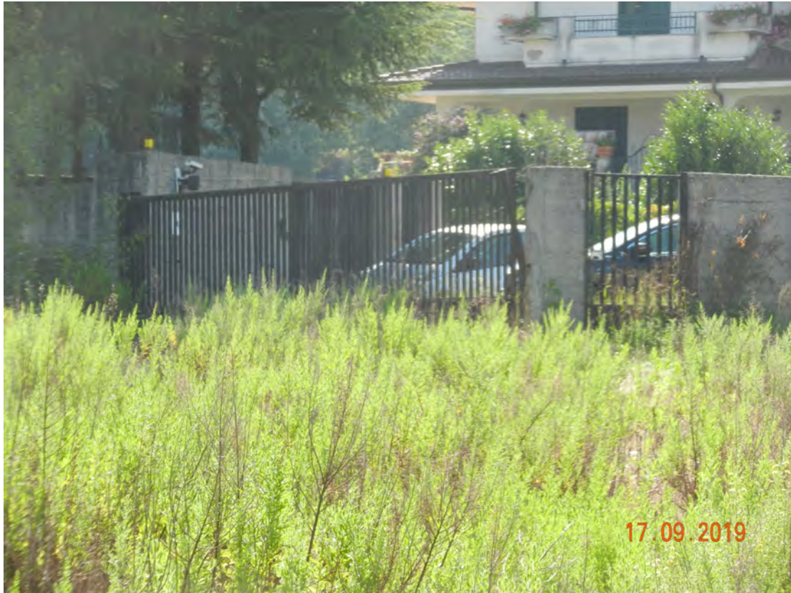
Foto 2 cancello d'ingresso fg. 10 - p.lla 466
