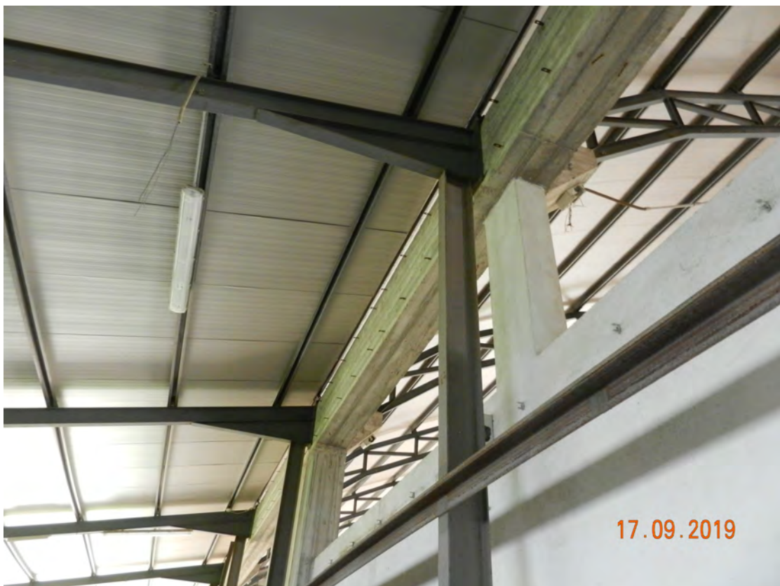
Foto 13 particolare struttura in ferro deposito legna fg. 10 - p.IIa 467
