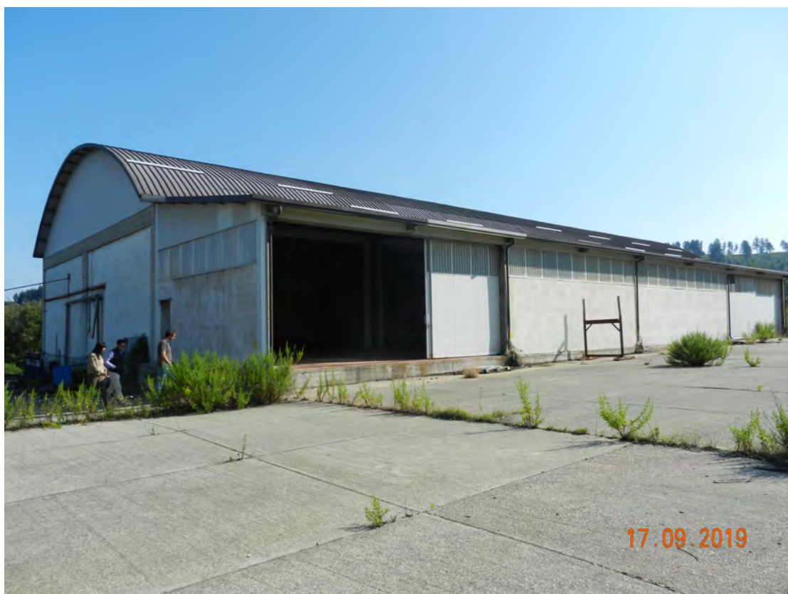
Foto 5 capannone fg. 10 - p.lla 467
