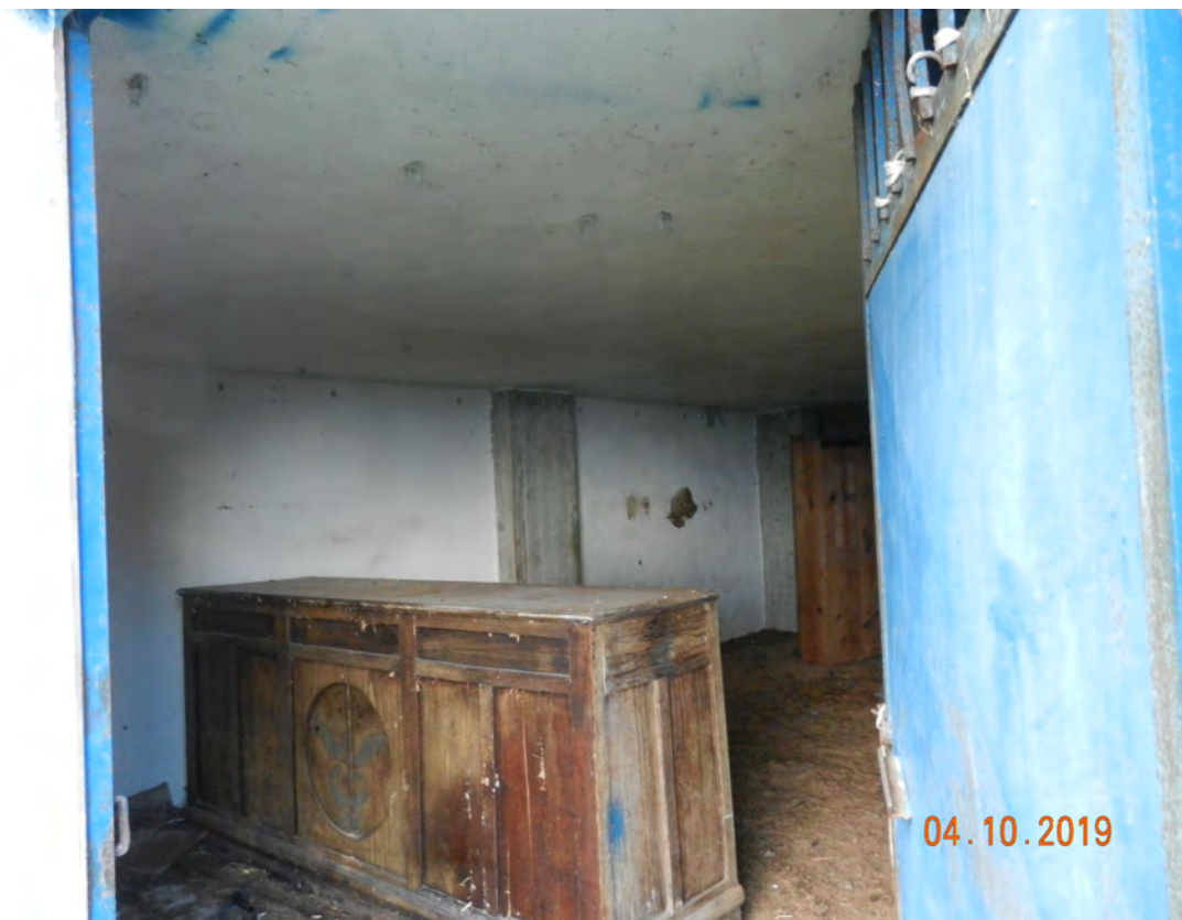
Foto 11 deposito attrezzi seminterrato fg. 10 - p.lla 467
