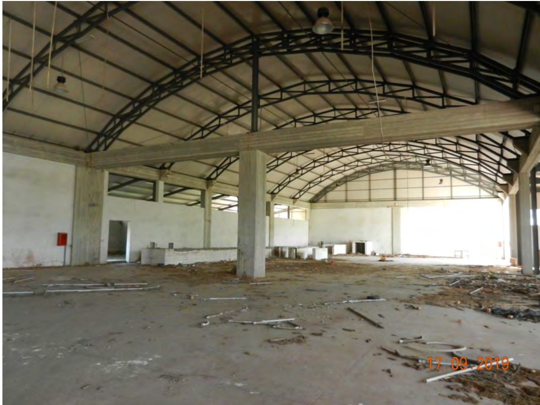
Foto 6 capannone corpo centrale fg. 10 - p.lla 467
