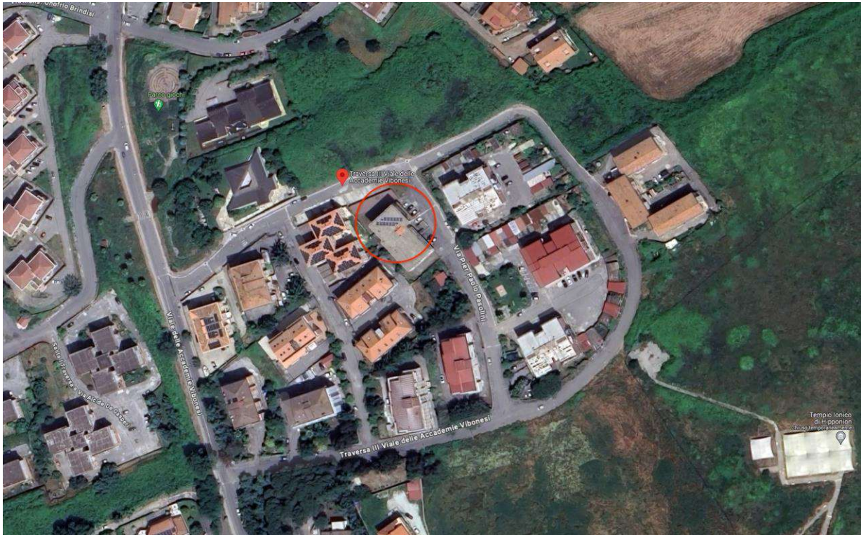
Figura 2 - Inquadramento territoriale . In evidenza l'immobile oggetto di analisi.
