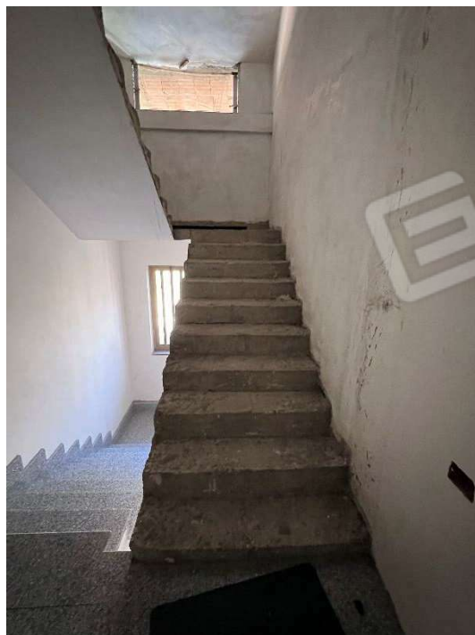
Foto 53 – Dettaglio rampa scale condominiale (ultima rampa – piano mansardato)
